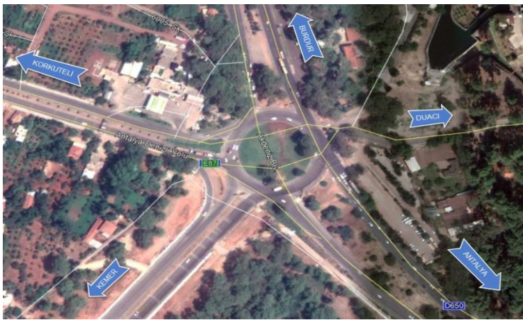
Şekil 4.62. Kavşak bölgesi uydu görüntüsü-3 (Kavşağın kemer yolu bağlantısı yapıldıktan sonraki hali, modern dönel kavşak)
