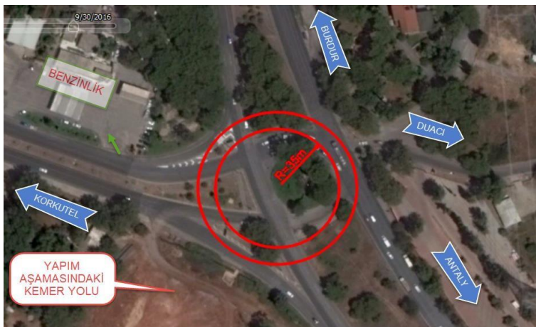
Şekil 4.61. Kavşak bölgesi uydu görüntüsü-2 (Kavşağın kemer yolu bağlantısı yapılmadan önceki hali ve uygulanan modern dönel kavşak adasının yerleşimi)
