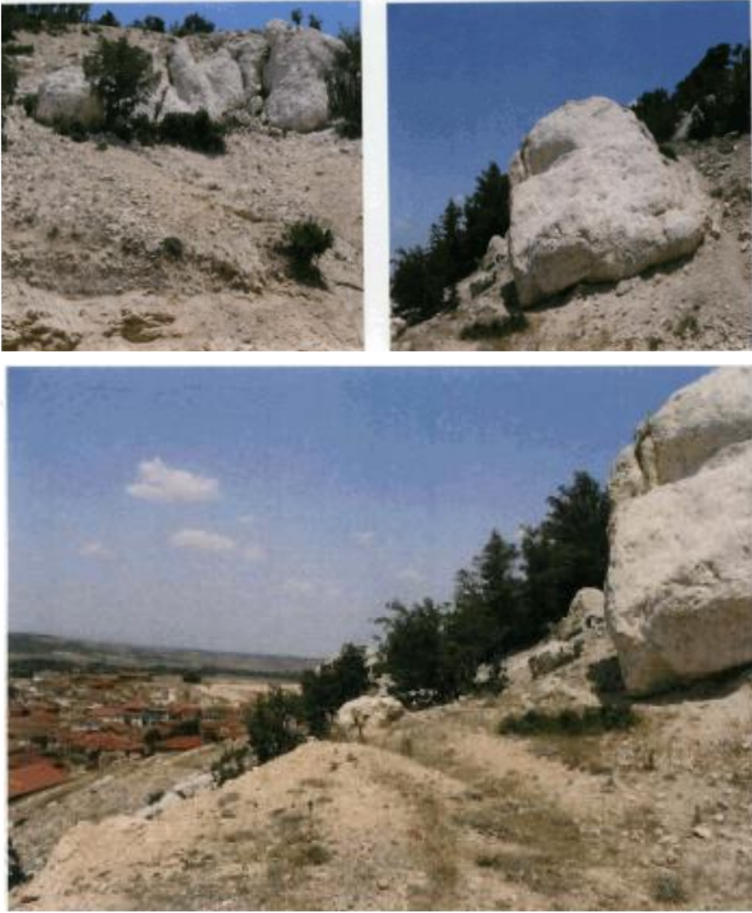
Şekil 2.3. Yörükkırka köyünde düşme tehlikesi bulunan kaya bloklarından görüntüler (AFAD, 2014).
