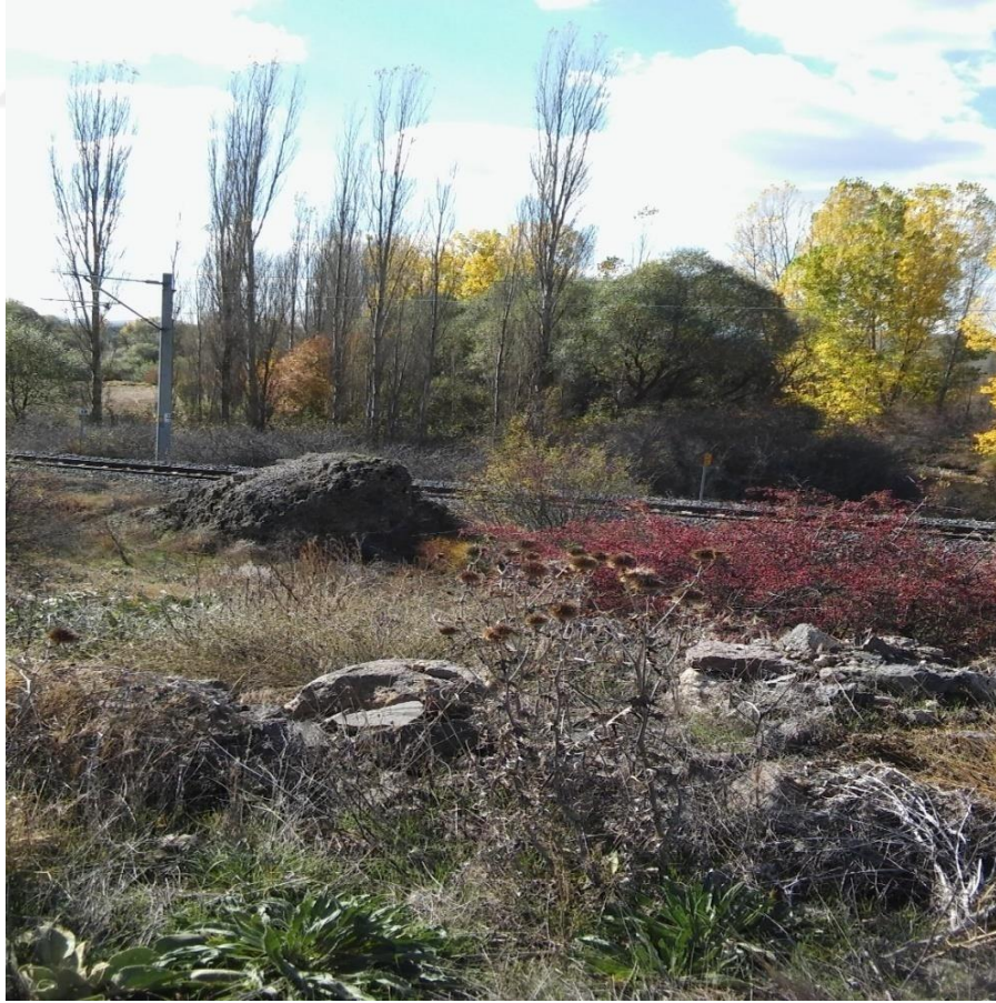
Şekil 5.17. Demiryoluna yakın düşmüş bloklardan bir görünüm.
