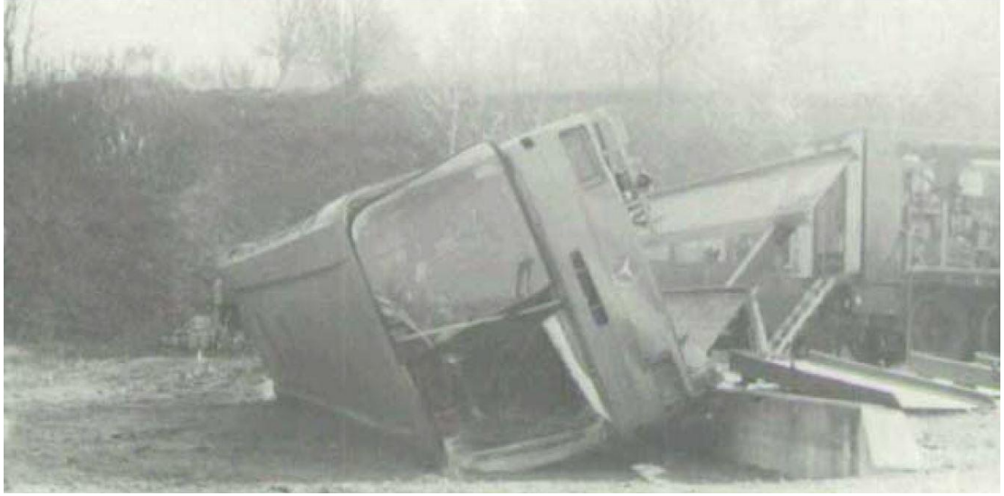
Şekil 2.1 : Mercedes O 303 devrilme testi [9].
