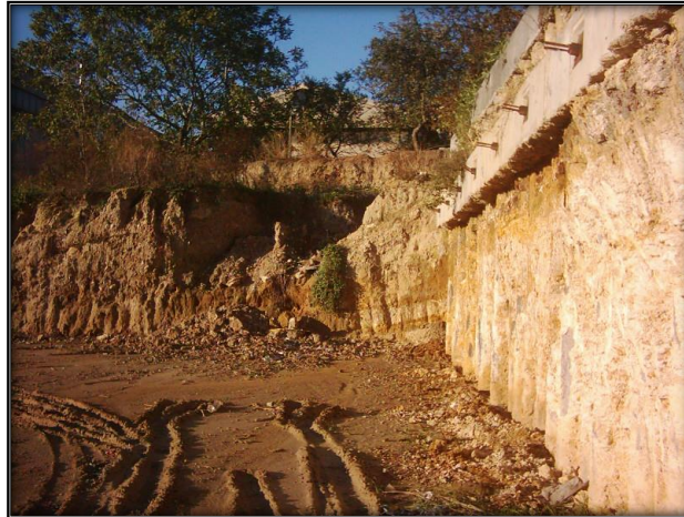
Şekil 5.18: Dere yatağı alüvyonunun görünümü (Kaynak: Bağcılar Belediyesi, Yerleşime Uygunluk Raporu,2008)
