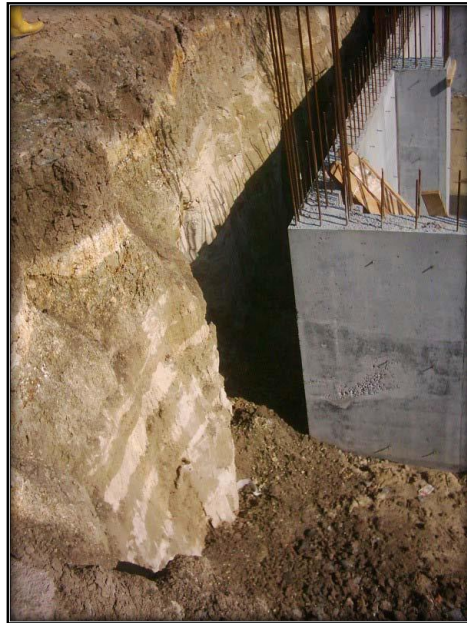
Şekil 5.16: Güngören Formasyonu Görünümü (Kaynak: Bağcılar Belediyesi, Yerleşime Uygunluk Raporu,2008)
