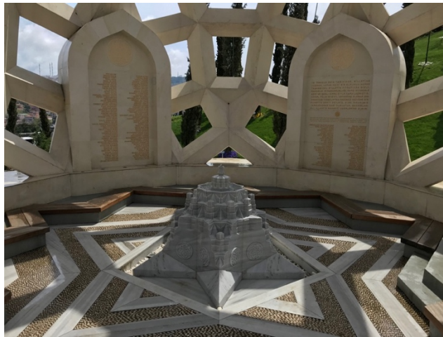
Şekil 3.27 : 15 Temmuz Şehitler Anıtı iç mekanda bulunan mukarnas havuz ve kademelenme.
