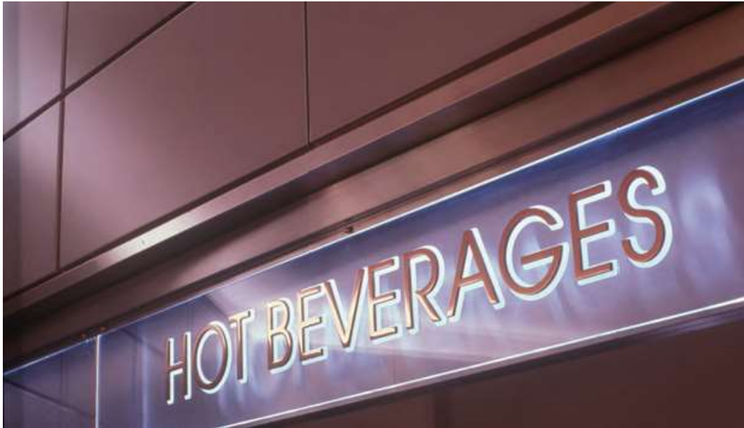
Görsel 37. Şeffaf akrilik tabela paneli üzerine kesilmiş bakır tipografi
