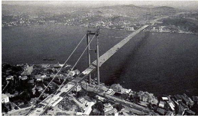
Şekil 3-37: Boğaziçi Köprüsü'nün inşaatı.
