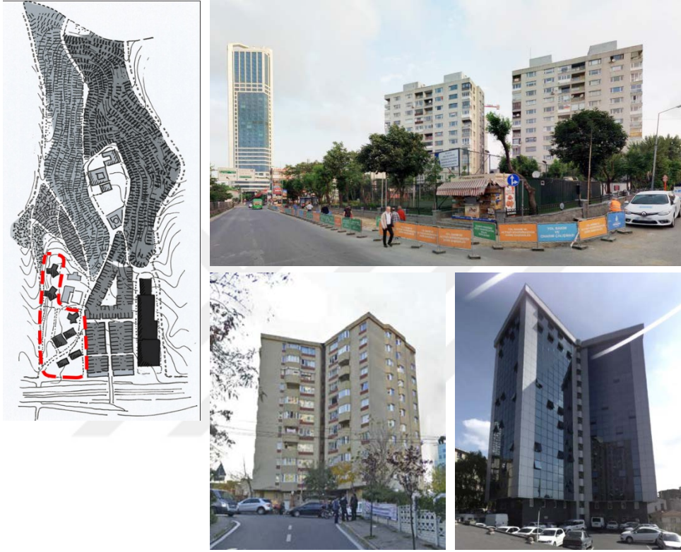
Şekil 4-39: Konut bloklarından oluşan doku Kaynak: Kişisel arşiv, 2019.
