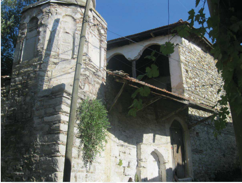
Resim 92: Darkale Minareli Cami, genel görünüş
