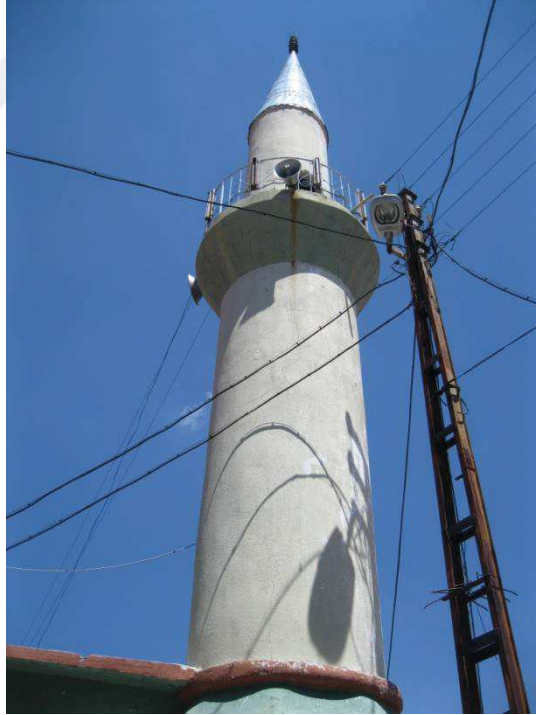
Resim 111: Orta Cami, minareden bir görünüş
