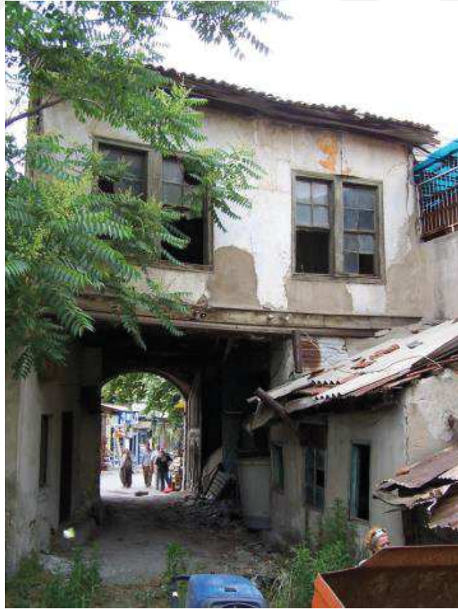
Resim 131: Balcı Han, güneybatı iç cephe
