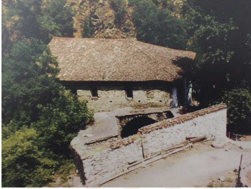
Resim 156: Çamaşırhane, güneydoğudan genel bir görünüş(Acun 2013)
