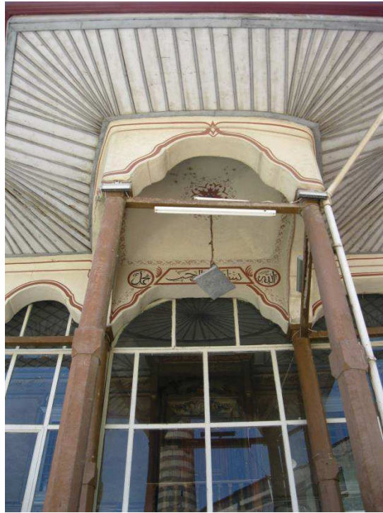
Resim 7: Emir Hızır Bey Cami, kuzey cephe giriş kapısı
