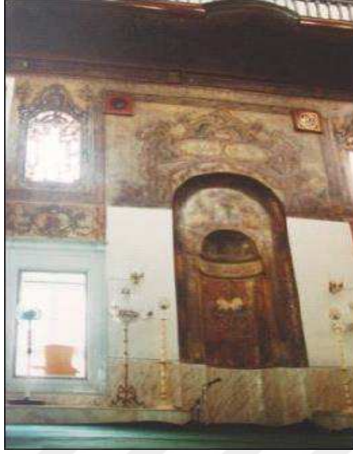
Resim 38: Emir Hızır Bey Cami, mihrabı onarım çalışmaları öncesi görünüm (VGM'den)
