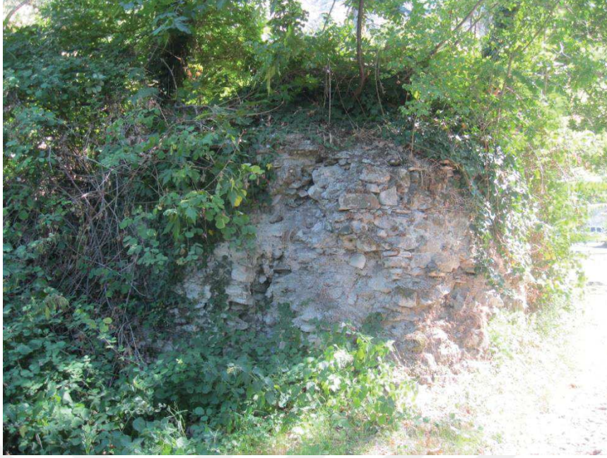
Resim 118: Darkale Hamam, doğu cephe
