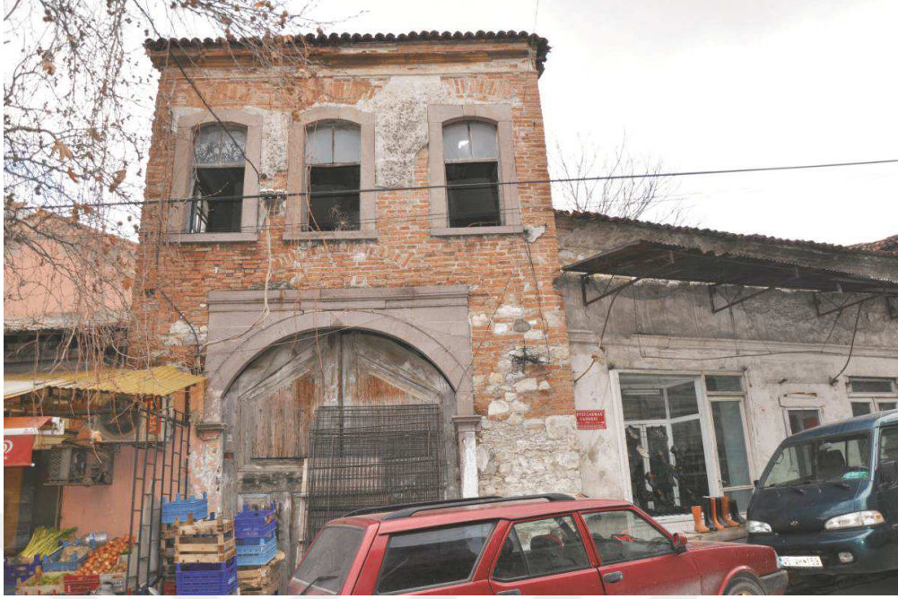
Resim 130: Balcı Han, güneybatı cephe
