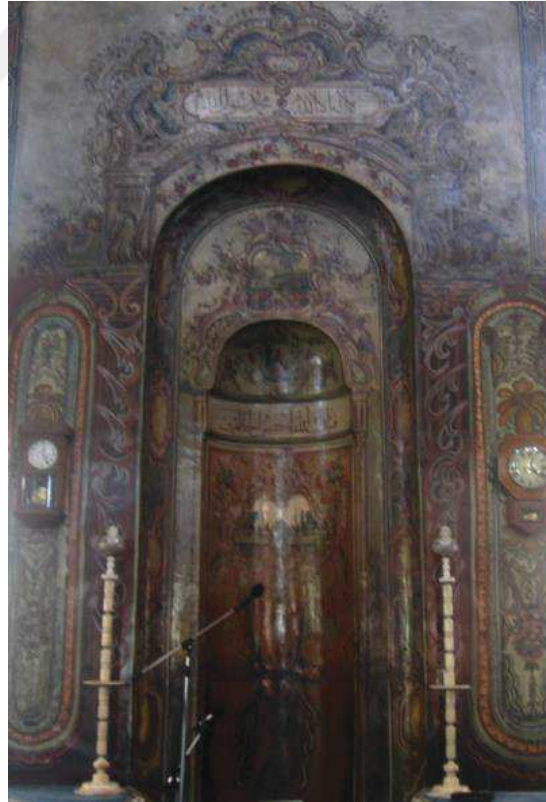
Resim 39: Emir Hızır Bey Cami, mihrabı onarım çalışmaları sonrası görünüm
