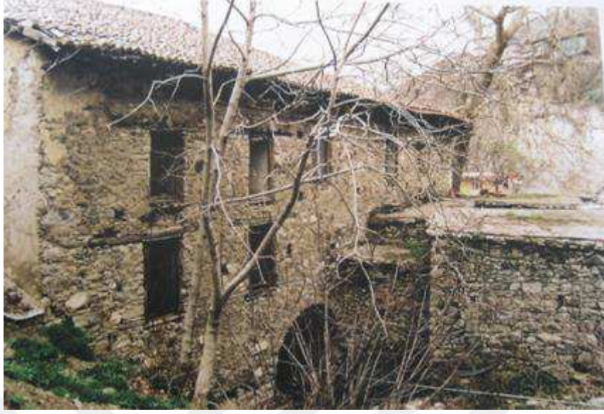
Resim 158: Çamaşırhane, güney cephesi
