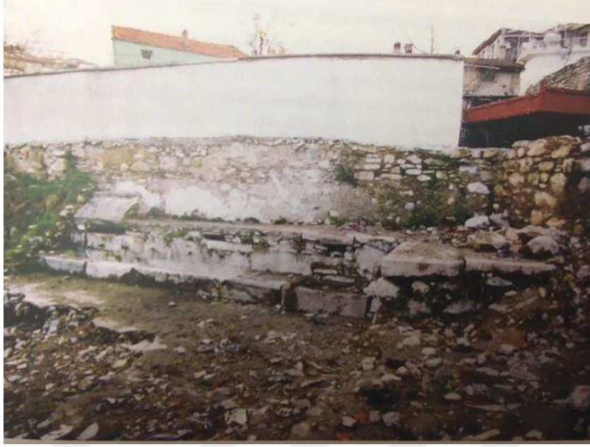
Resim 148: Dokuz Oluklu Çeşme, eski görünüşü (Acun 2013)
