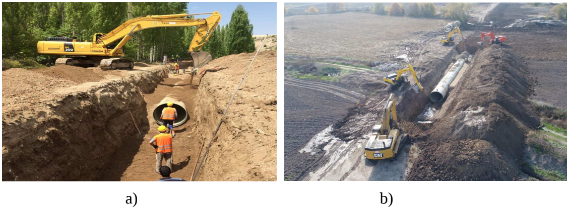
Şekil 1.7. Sulama hatları a) Sulama boru hattı döşemesi b) Genel görünüm.
