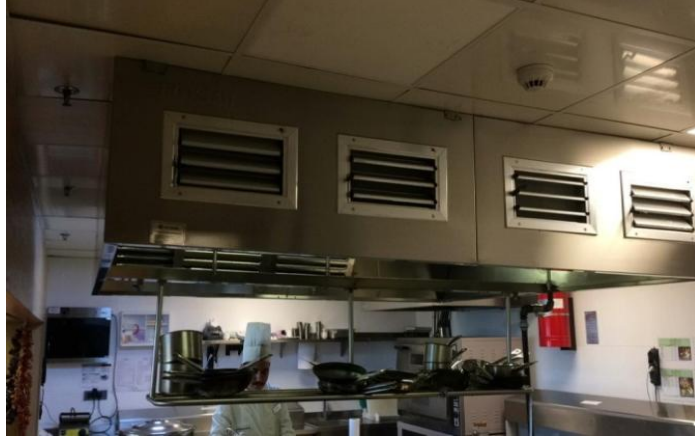
Şekil 1.3. Mutfak Bölümü Havalandırma Sistemi
