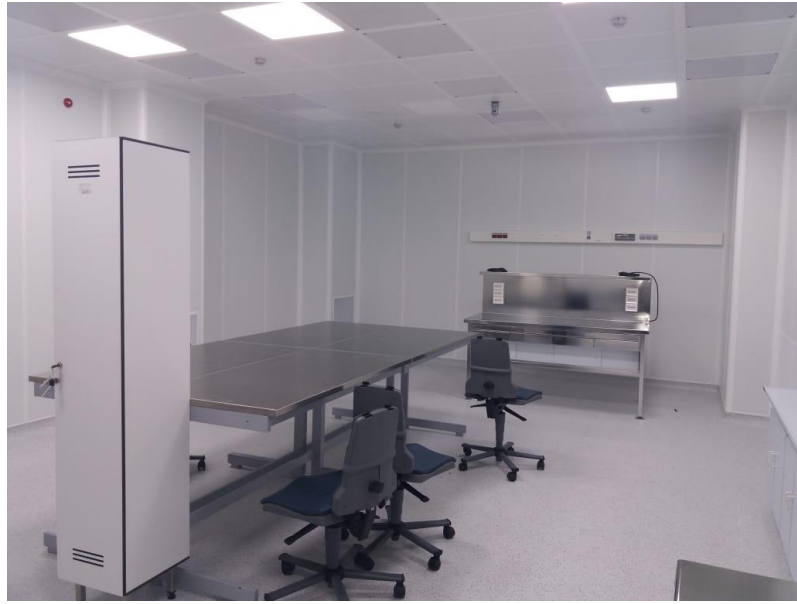
Şekil 5.14 NU Temiz Odalarında Kullanılan HPL Kaplama Örneği (Ümit KALENDEROĞLU, 10.04.2018)
