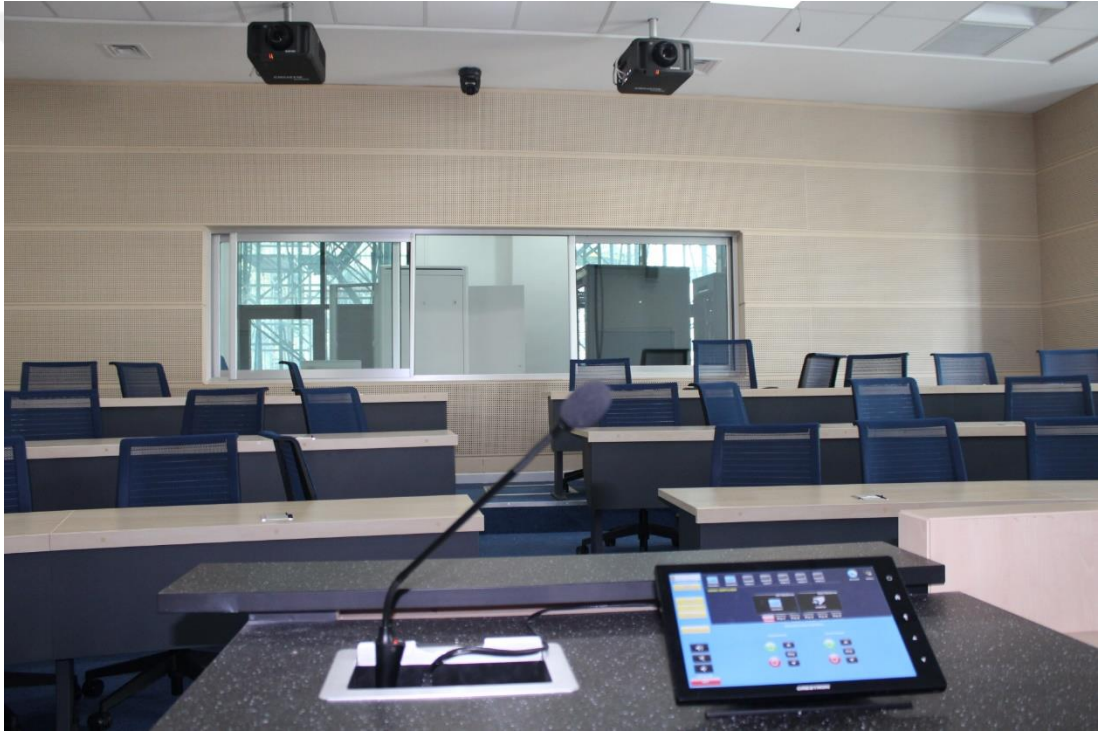
Şekil 4.38 NU E3_Dershane İç Mekan Görünümü – 1 (Muhammet AKDERE, 28.04.2016)
