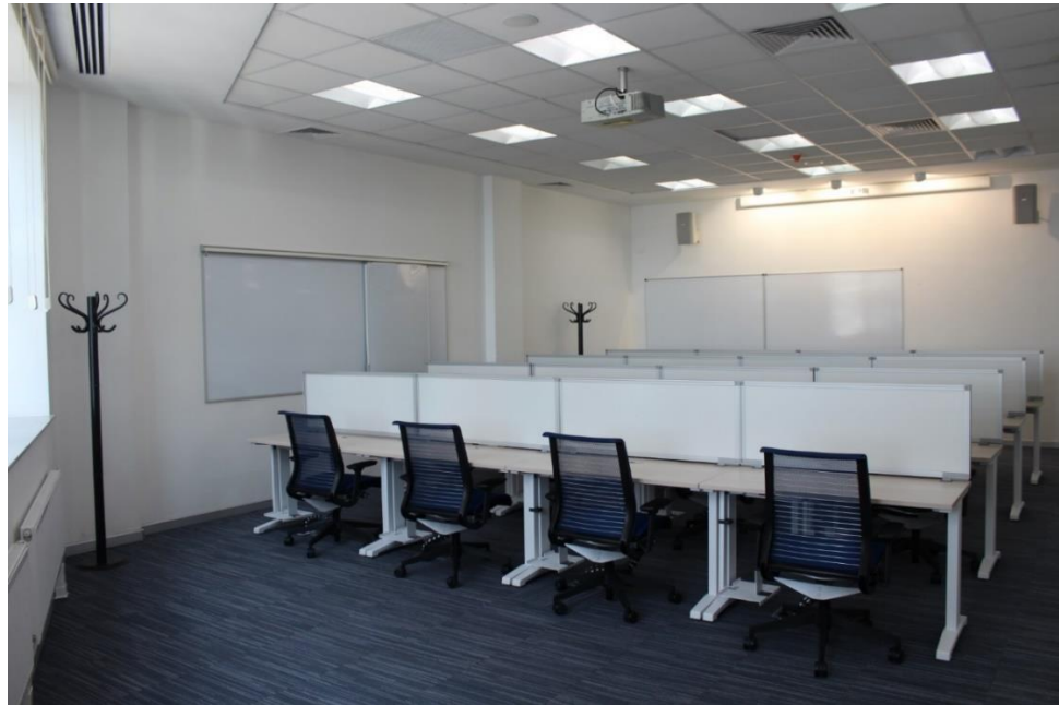
Şekil 4.7 NU Örnek Dersliğinde Modüler Taşyünü Asma Tavan Uygulaması (Muhammet AKDERE, 23.03.2018)
