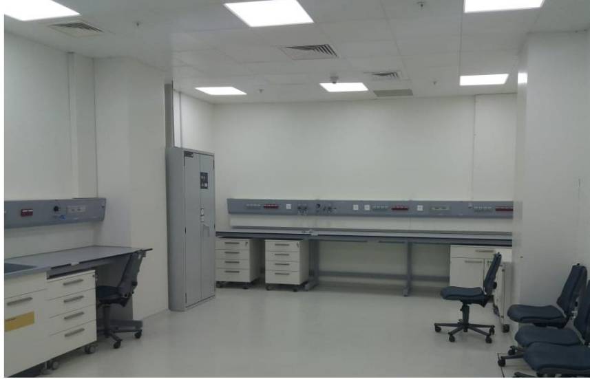
Şekil 5.6 NU Malzeme Mühendisliği Metal Asma Tavan Uygulaması (Muhammet AKDERE, 05.04.2018)
