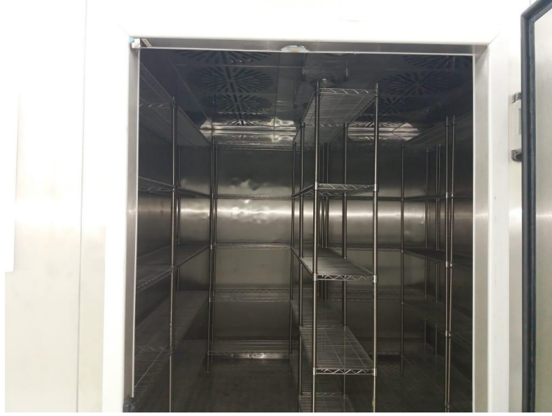
Şekil 5.58 NU Sıcak Oda İç Mekan Görünümü-2 (Bayan DAULKHANOVA, 05.04.2018)
