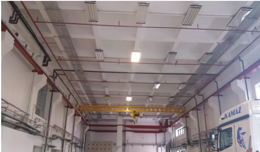
Şekil 5.7 NU İnşaat Mühendisliği Su Bazlı Tavan -Duvar Boyası Uygulaması (Muhammet AKDERE, 05.04.2018)
