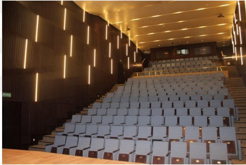
Şekil 4.10 NU 250 Kişilik Konferans Salonu Akustik Ahşap Tavan Uygulaması (Ahmet Özgür UĞUR, 16.06.2016)
