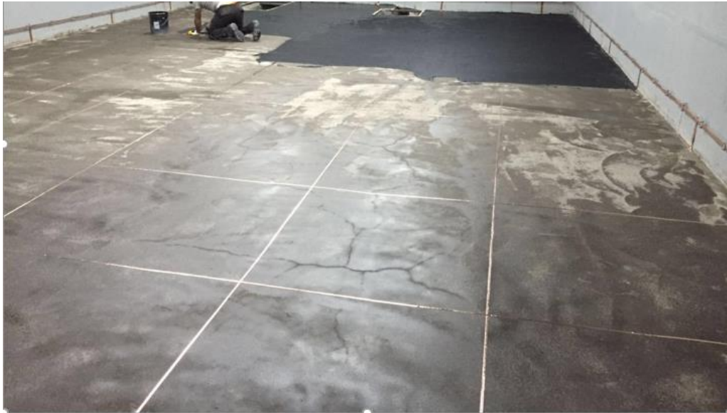
Şekil 5.2 Antistatik PVC Alt katmanı Bakır Bara Uygulaması
