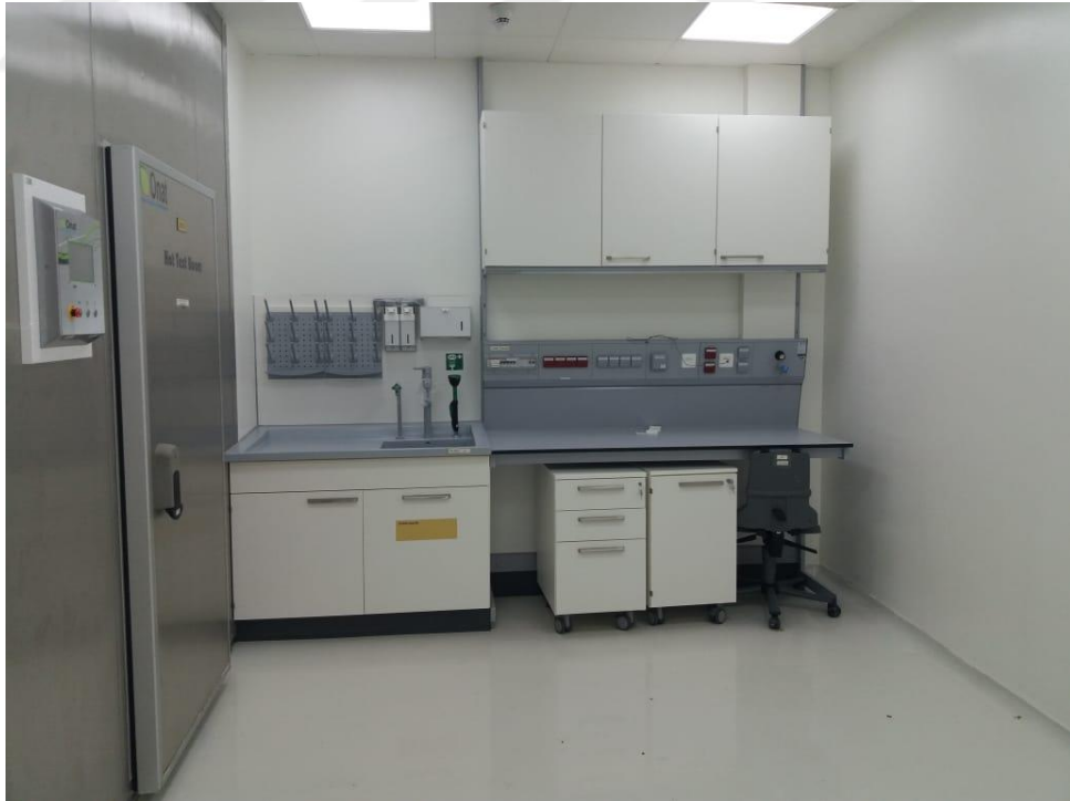
Şekil 5.57 NU Sıcak Oda İç Mekan Görünümü-1 (Bayan DAULKHANOVA, 16.05.2018)
