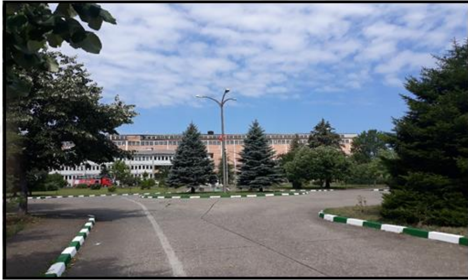
Şekil 50: Çarşamba Şeker Fabrikası Ön Cepheden Görünüm.
