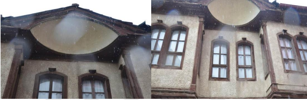
Şekil 4. 55 Kantoğlu Sokak (247 Ada 44-45 Parsel) evin saçak görünüşü.
