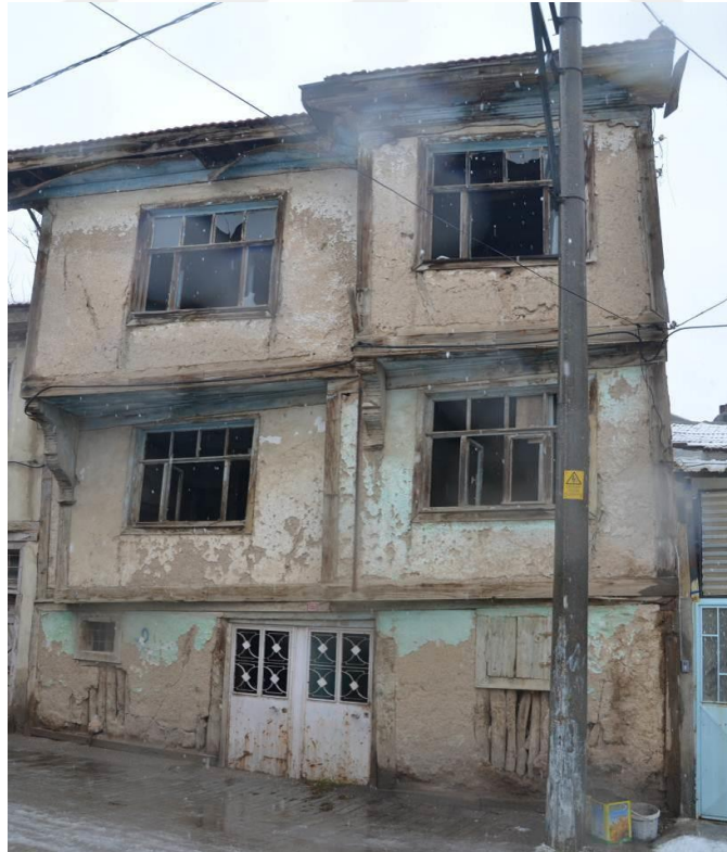
Şekil 4. 132 Palta Sokak (237 Ada 112 Parsel) evin genel görünüşü.
