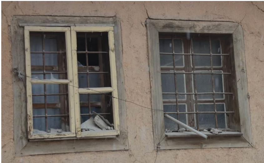
Şekil 4. 18 Yapının özgün zemin kat pencerelerinin görünüşü.
