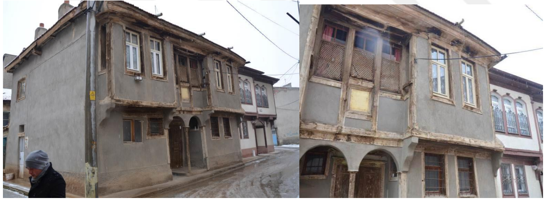
Şekil 4. 138 Palta Sokak (236 Ada 18 Parsel) evin genel görünüşü.
