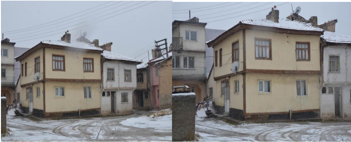
Şekil 4. 50 Cilalioğlu Sokak (247 Ada 2 Parsel) evin genel görünüşü.
