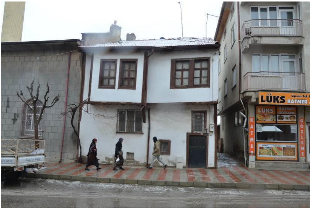
Şekil 4. 186 Emirdağ Caddesi (264 Ada 67 Parsel) evin genel görünüşü.
