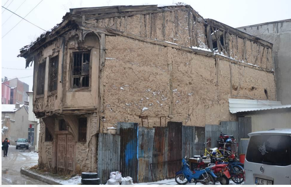
Şekil 4. 34 Şazi Cılkoğlu Sokak 247 Ada 28 Parseldeki yapının genel görünüşü.
