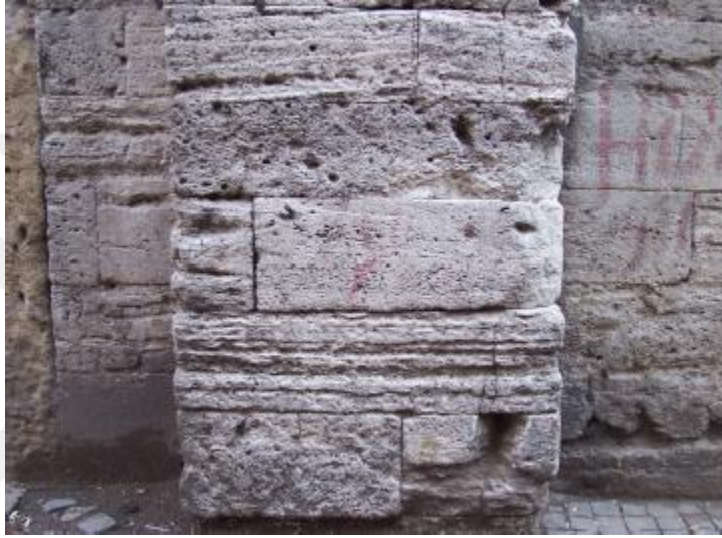
Şekil 2. 3 Sıfır derz taş duvar (Kara 2009).
