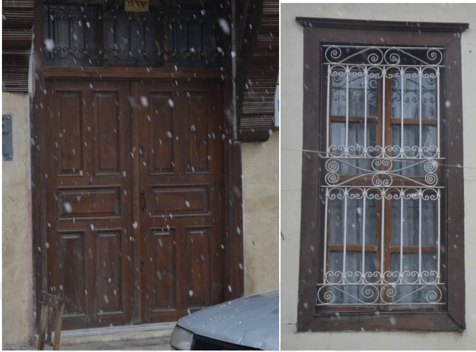
Şekil 4. 60 Sazi Cılkoğlu Sokak (247 Ada 36 Parsel) yapının kapı ve pencere detayının görünüşü.
