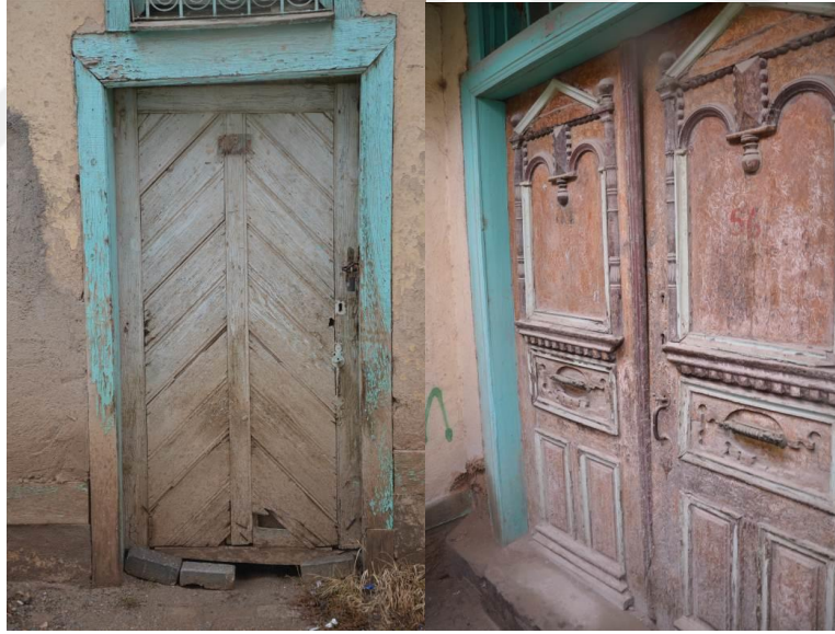
Şekil 4. 32 Yapının kapı kanatlarının görünüşü.
