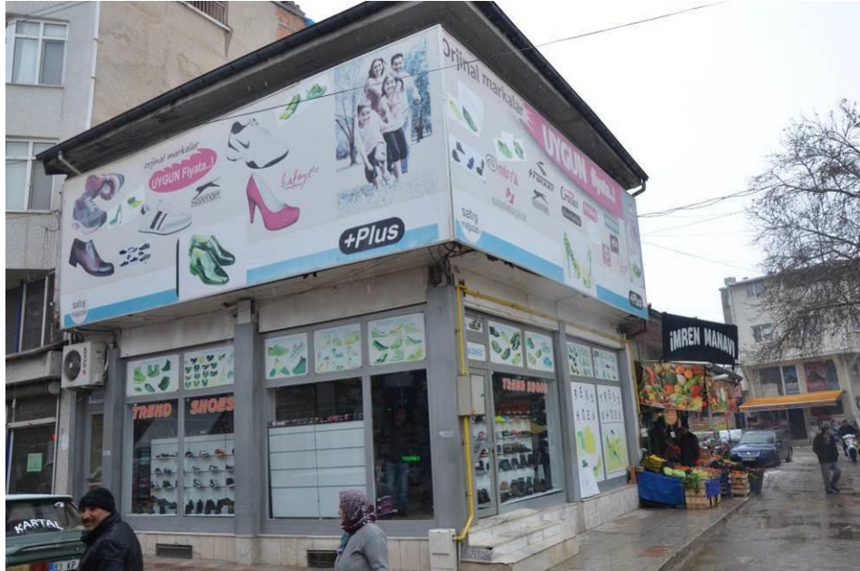
Şekil 4. 170 Emirdağ Caddesi (265 Ada 2 Parsel) yapının genel görünüşü.
