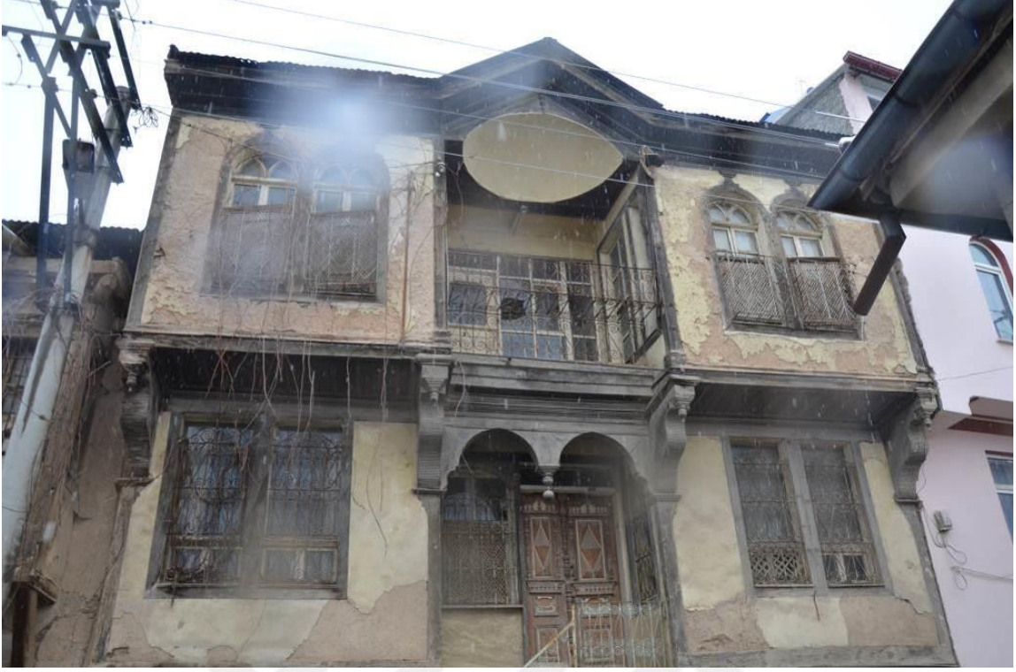
Şekil 4. 108 Tahtalı Sokak (243 Ada 13 Parsel) evin dış cephesinin görünüşü.
