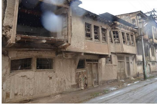
Şekil 4. 102 Tahtalı Sokak (243 Ada 15 Parsel) evin genel görünüşü.
