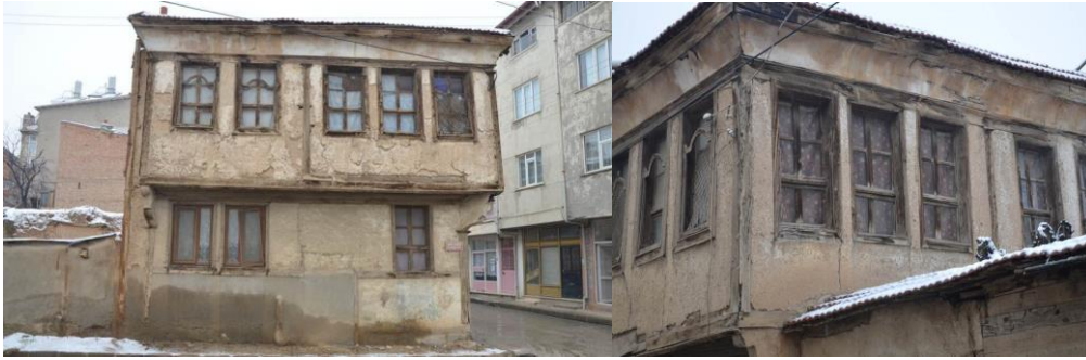
Şekil 4. 9 Yapının teneke kaplı saçağının görünüşü.
