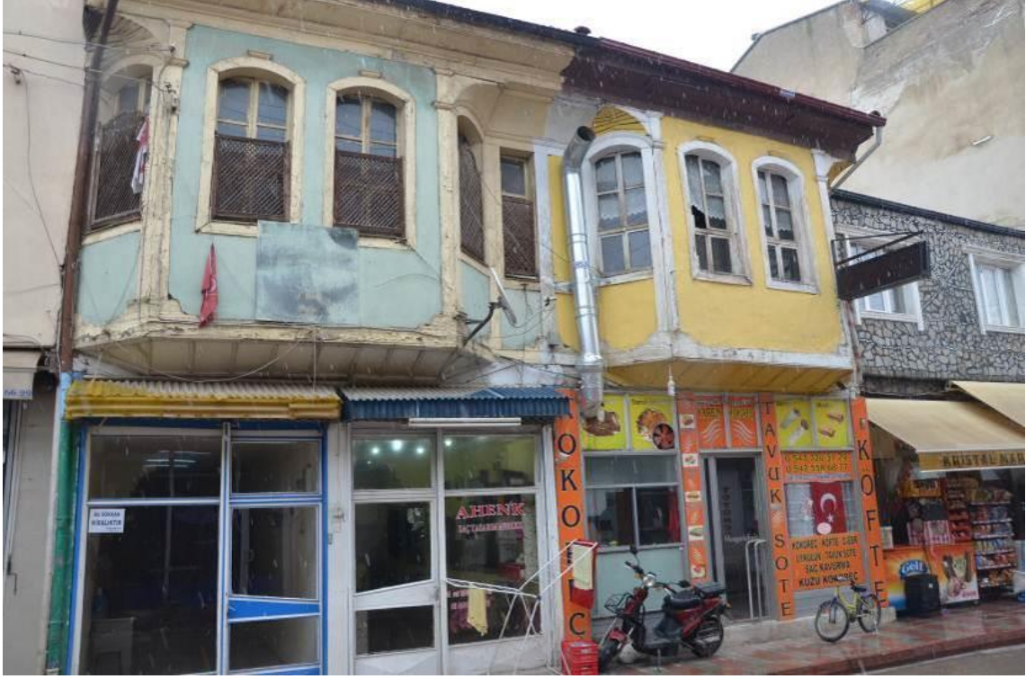
Şekil 4. 168 Emirdağ Caddesi (265 Ada 2-3 Parsel) yapının genel görünüşü.
