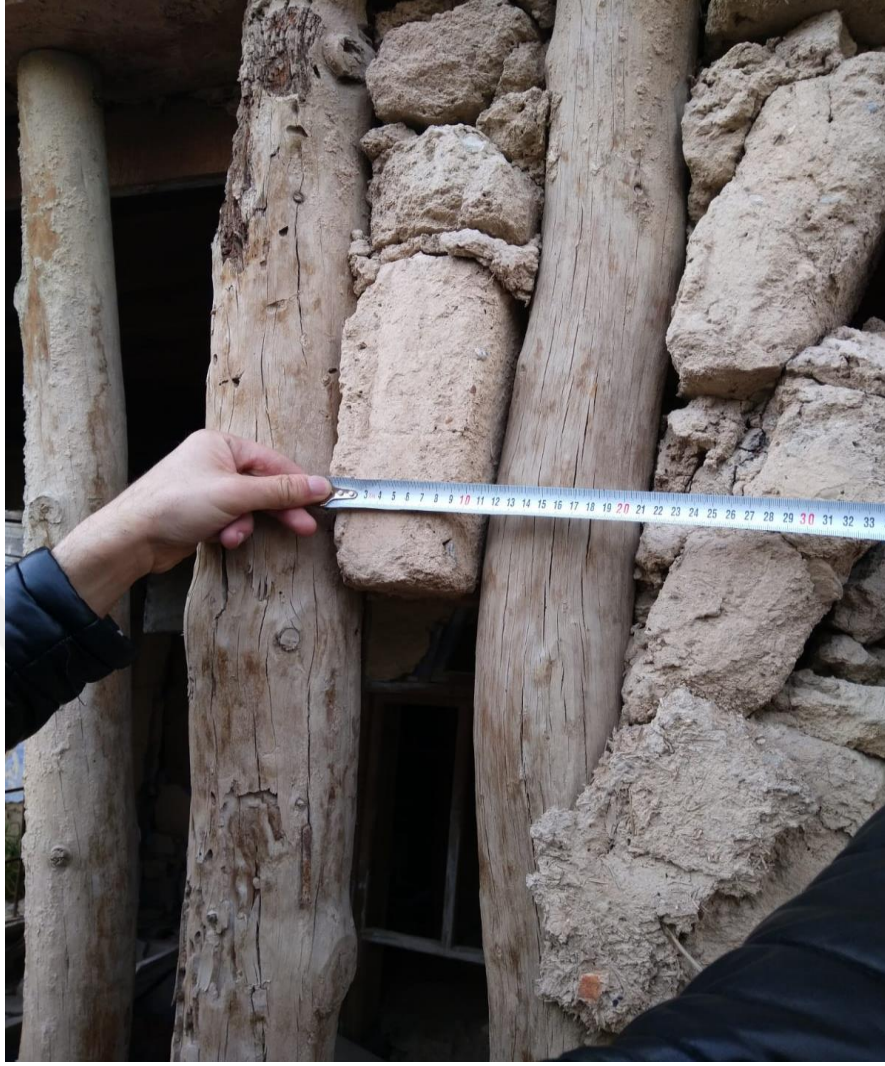
Şekil 3. 10 Ahşap Karkas ev ana kerpiç boyutları.
