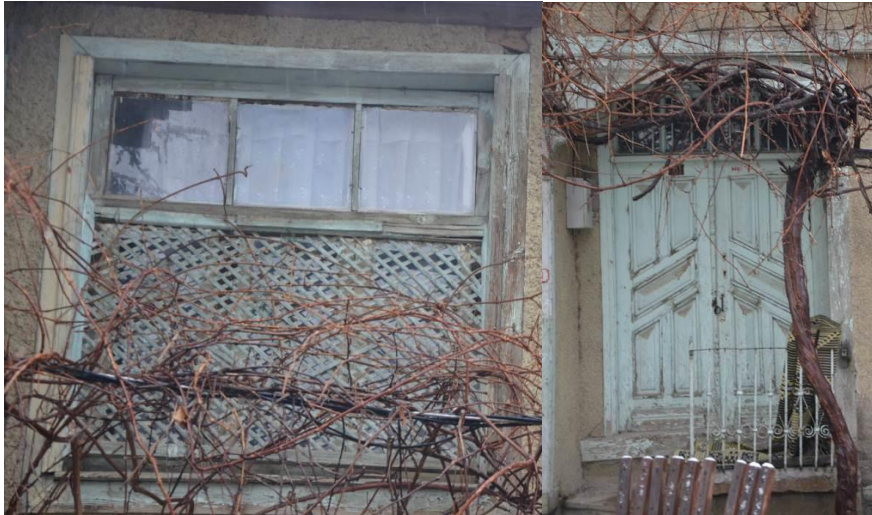
Şekil 4. 3 273 Ada 90 parseldeki yapının kapı ve pencere fotoğrafları.
