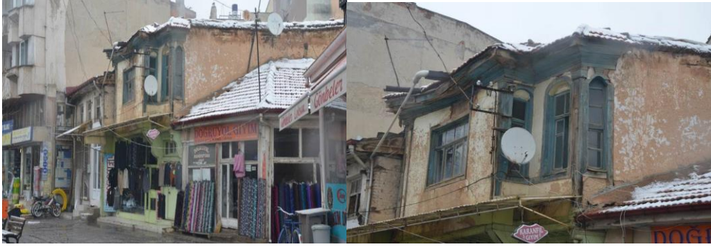
Şekil 4. 67 Hisar Yolu (237 Ada 56-57 Parsel) evin genel görünüşü.
