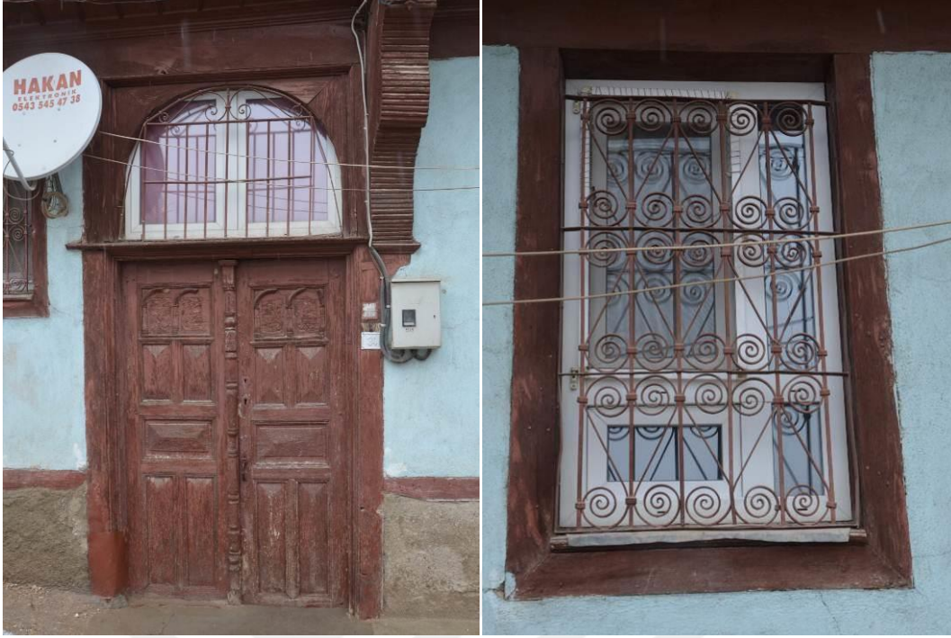
Şekil 4. 22 Yapının özgün kapı ve pencerelerinin görünüşü.
