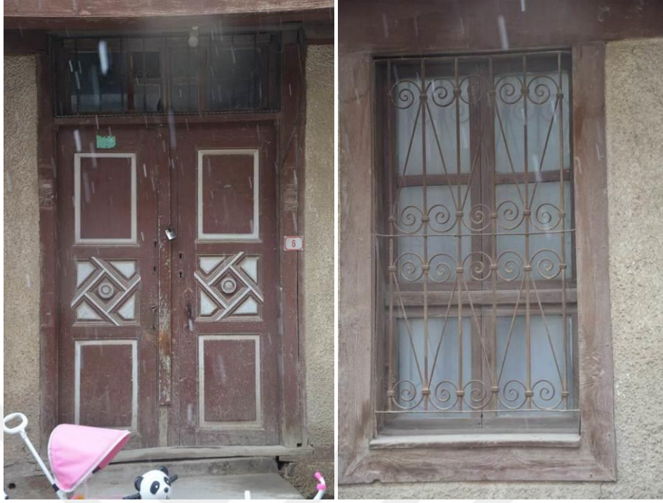
Şekil 4. 57 Kantaroğlu Sokak (247 Ada 44-45 Parsel) evin kapı ve pencere detayının görünüşü.
