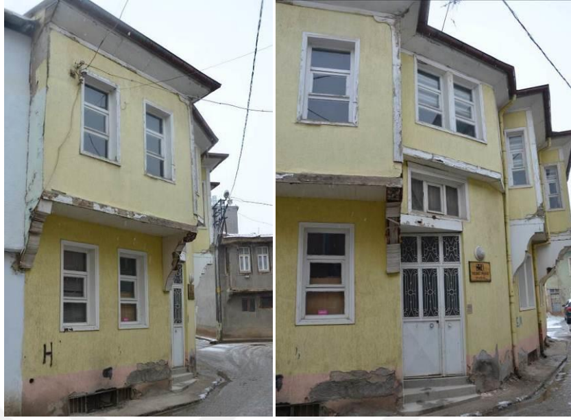
Şekil 4. 136 Palta Sokak (236 Ada 25 Parsel) evin genel görünüşü.
