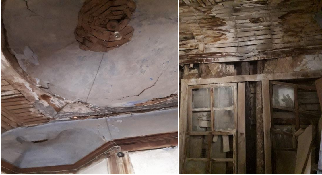
Şekil 3. 7 Bağdadi yapım tekniği uygulanan Bolvadin evi.
