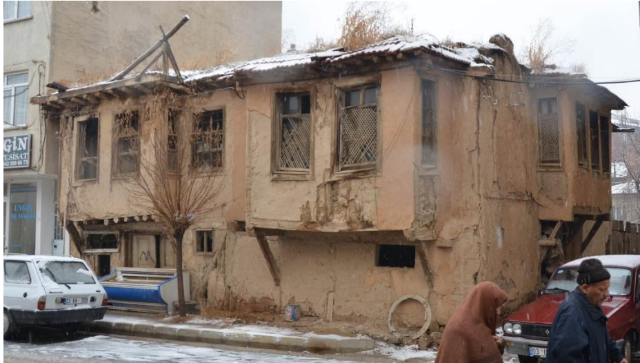
Şekil 4. 15 Yapının ana caddeye bakan cephesinin genel görünüşü.
