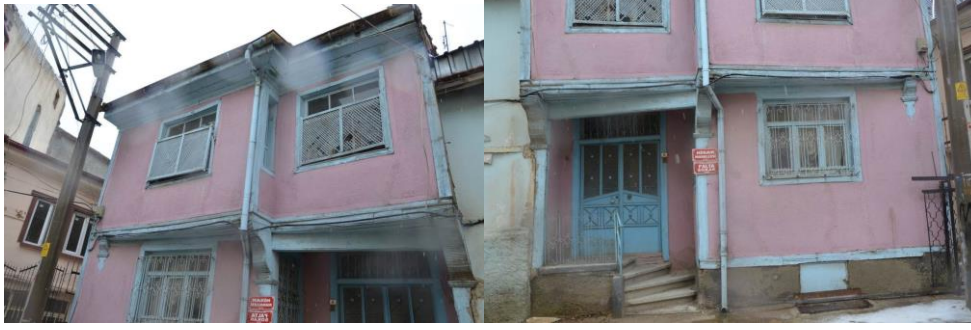
Şekil 4. 134 Palta Sokak (237 Ada 103 Parsel) evin genel görünüşü.
