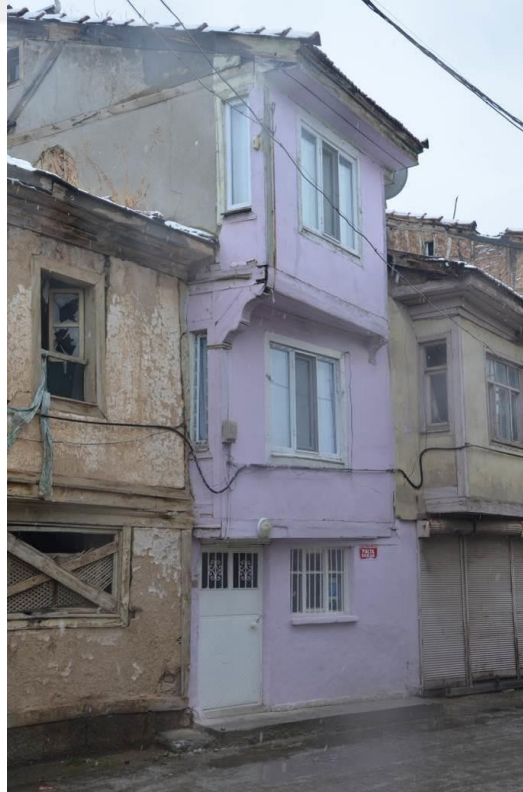
Şekil 4. 128 Palta Sokak (237 Ada 114 Parsel)evin genel görünüşü.
