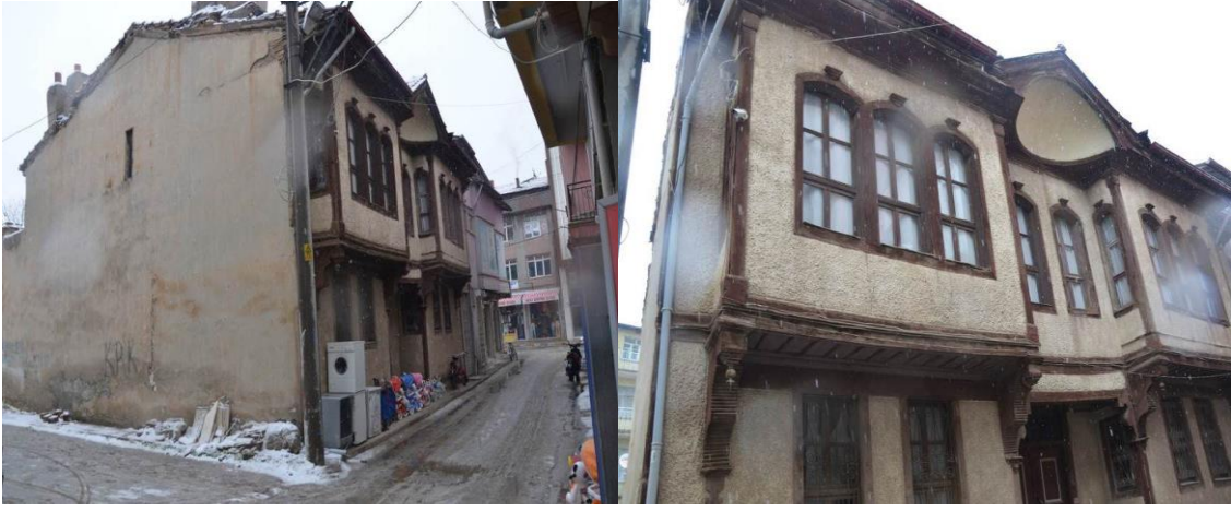
Şekil 4. 54 Kantoğlu Sokak (247 Ada 44-45 Parsel) Evin Genel Görünüşü
