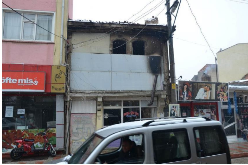
Şekil 4. 166 Emirdağ Caddesi (266 Ada 26 Parsel) yapının genel görünüşü.
