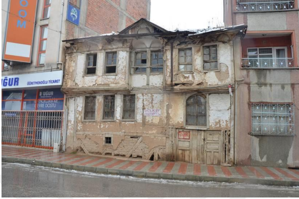
Şekil 4. 184 Emirdağ Caddesi (264 Ada 3 Parsel) evin genel görünüşü.
