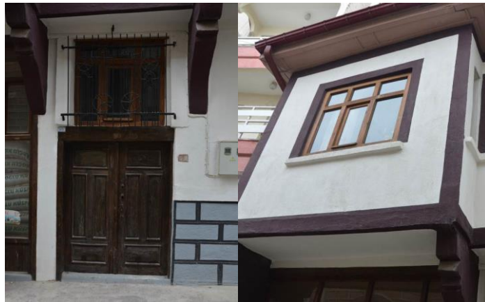
Şekil 4. 74 Kırklar Sokak (199 Ada 39 Parsel) evin kapı ve pencere görünüşü.
