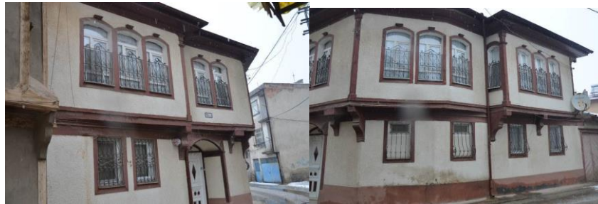
Şekil 4. 140 Palta Sokak (236 Ada 17 Parsel) evin genel görünüşü.
