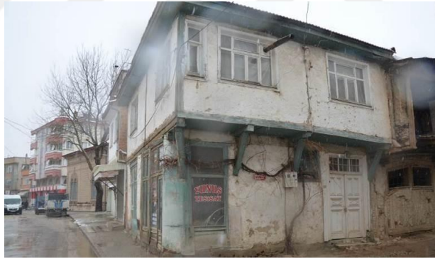
Şekil 4. 99 Tahtalı Sokak (243 Ada 16 Parsel) evin genel görünüşü.
