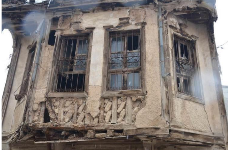
Şekil 4. 36 Şazi Cılkoğlu Sokak 247 Ada 28 Parseldeki yapının üst kat cumbasının görünüşü.
