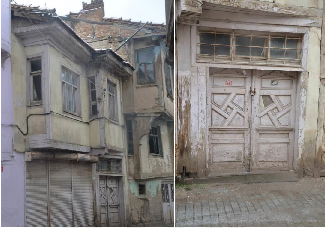
Şekil 4. 130 Palta Sokak (237 Ada 113 Parsel) evin genel görünüşü.
