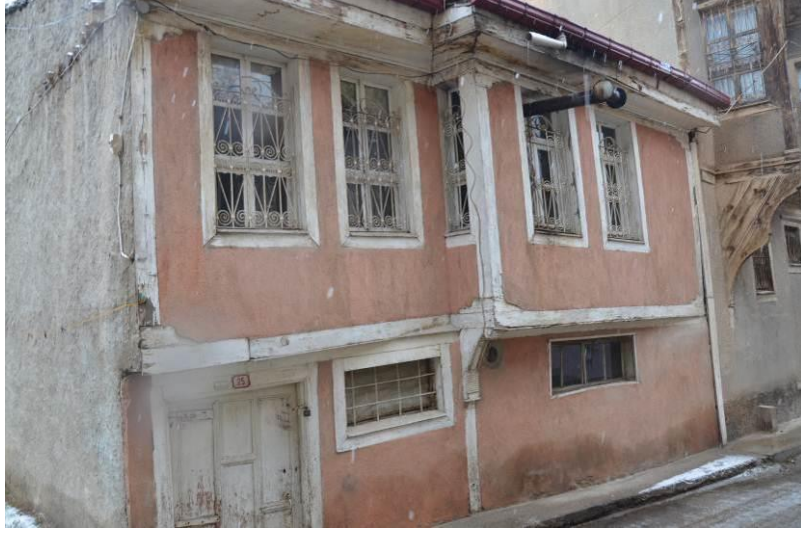
Şekil 4. 142 Palta Sokak (236 Ada 13 Parsel) evin genel görünüşü.
