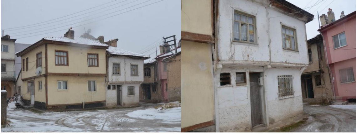
Şekil 4. 48 Cilalioğlu Sokak (247 Ada 1 Parsel) evin genel görünüşü.
