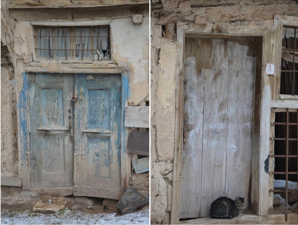
Şekil 4. 77 Kırklar Sokak (199 Ada 42 Parsel) evin kapı kanatlarının görünüşü.
