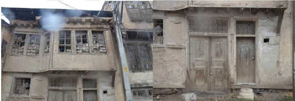
Şekil 4. 105 Tahtalı Sokak (243 Ada 14 Parsel) evin genel görünüşü ve kapı görünüşü.
