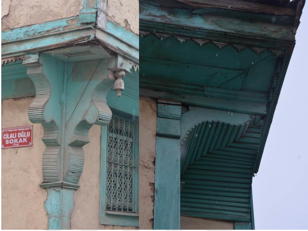
Şekil 4. 31 Yapının payanda ve saçak detaylarının görünüşü.
