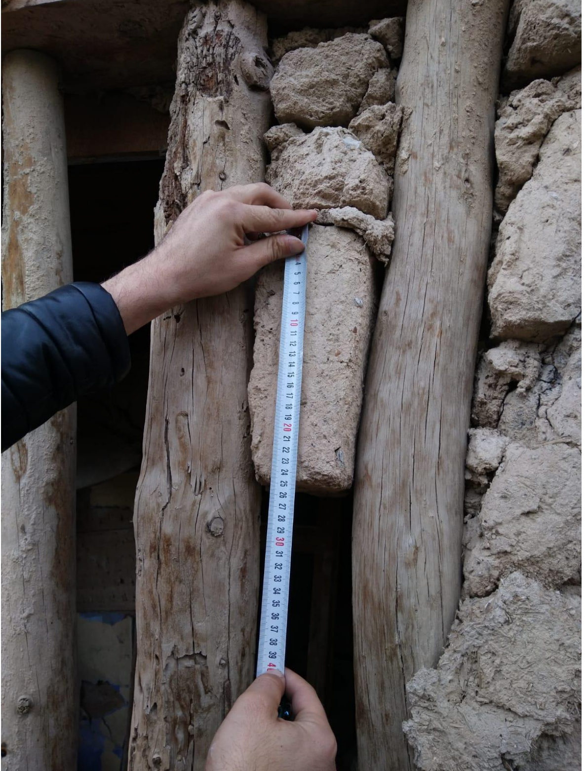
Şekil 3. 8 Ahşap Karkas ev ana kerpiç boyutları.
