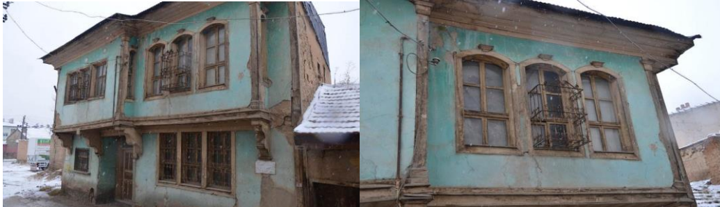
Şekil 4. 44 Cilalıoğlu sokak 247 Ada 15 Parseldeki evin üst kat pencere görünüşü.
