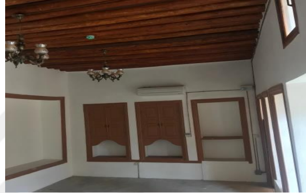
Şekil 4.108: Ahşap çatı detayları.
