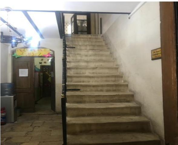
Şekil 4.169: Yenilenmiş merdiven. (Tuba Fazlıağaoğlu Arşivi)
