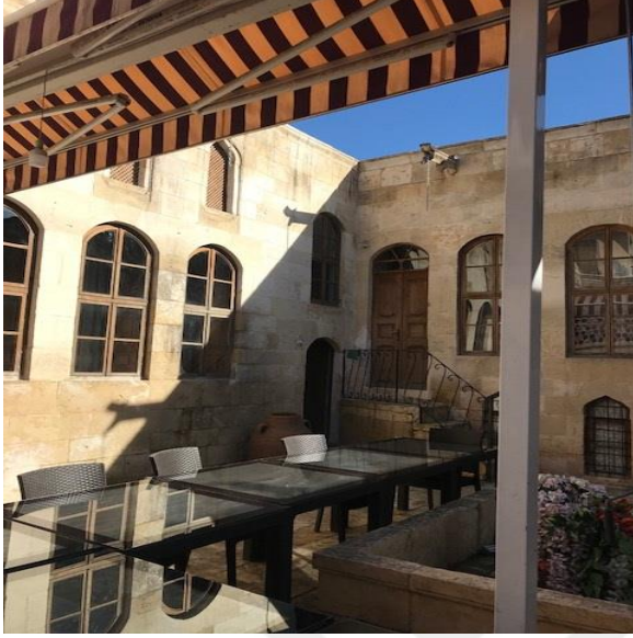
Şekil 4.160: Yenilenmiş avlu cepheleri.
