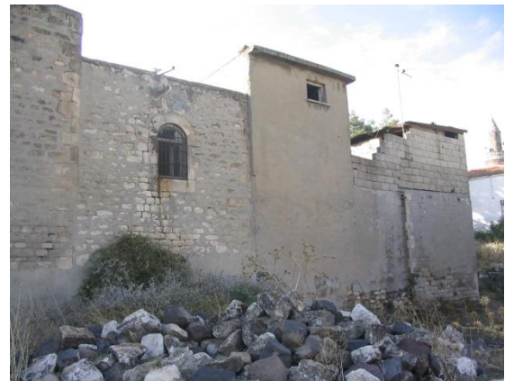
Şekil 4.222: Hamamın batı cephesi.
