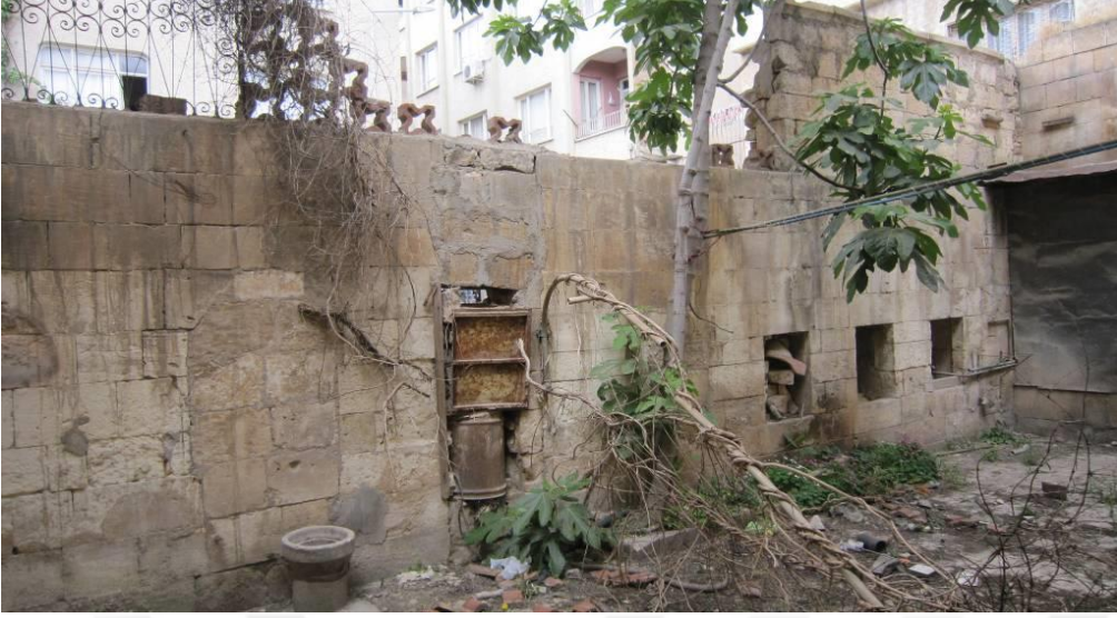
Şekil 4.149 :Avlunun batı duvarındaki kapatılan kapı ve pencerelerin görünüşü.
