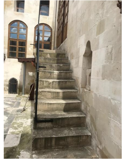
Şekil 4.101: Yeni merdivenler. (Tuba Fazlağaoğlu Arşivi)
