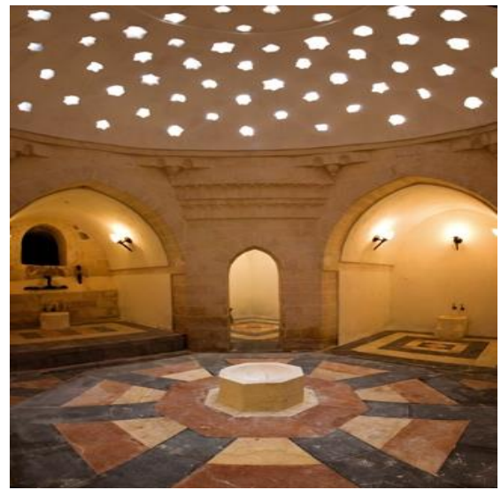
Şekil 4.206: Ilıklık orta kubbe figözleri. (Bebekoğlu,Tektuna,2008)
