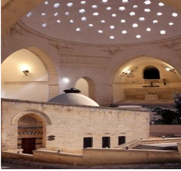
Şekil 4.241: Eski hamamın yenilenmiş çatısı.
