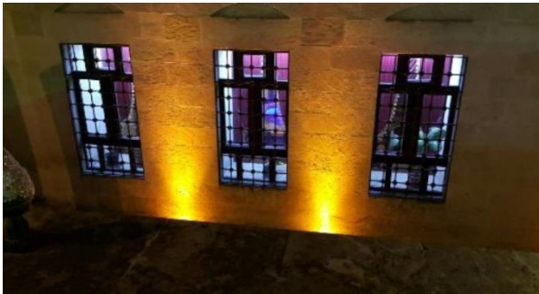
Şekil 4.230: Yenilenmiş pencereler (Tuba Fazlıağaoğlu Arşivi).
