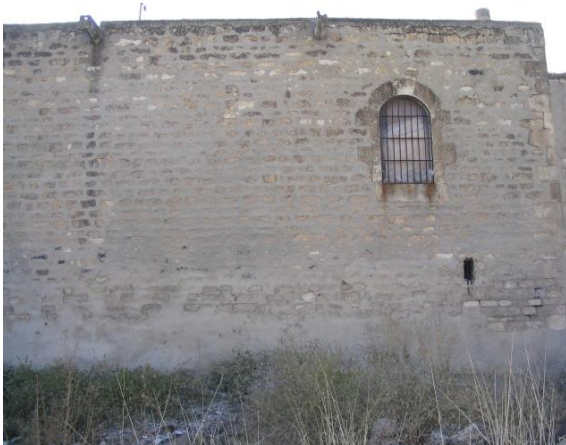
Şekil 4.221: Hamamın batı cephesi.
