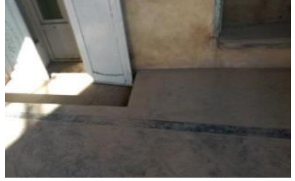
Şekil 4.87: Teras kat zemin döşemesi. (Onur Belgin Arşivi)
