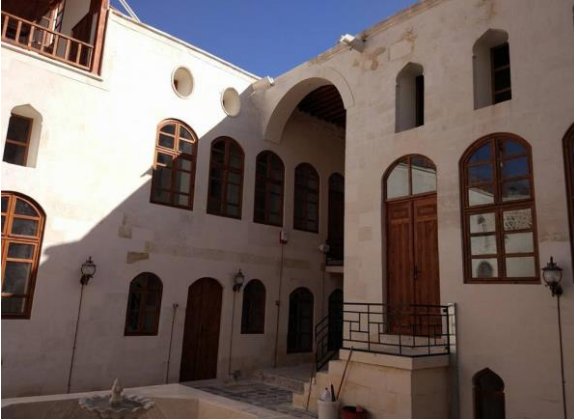
Şekil 4.95: Yenilenmiş avlu cepheleri.
