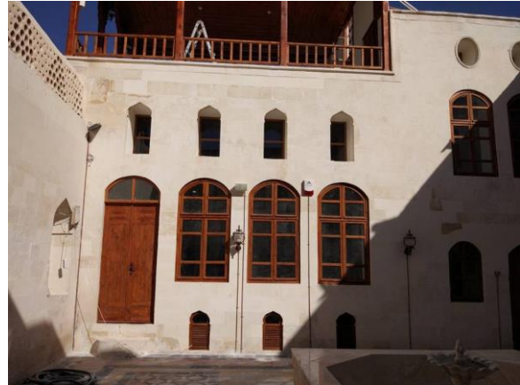
Şekil 4.92: Yenilenmiş avlu cephesi.
