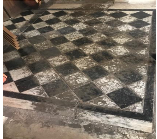
Şekil 4.170: Zemin döşemesi. (Tuba Fazlıağaoğlu Arşivi)
