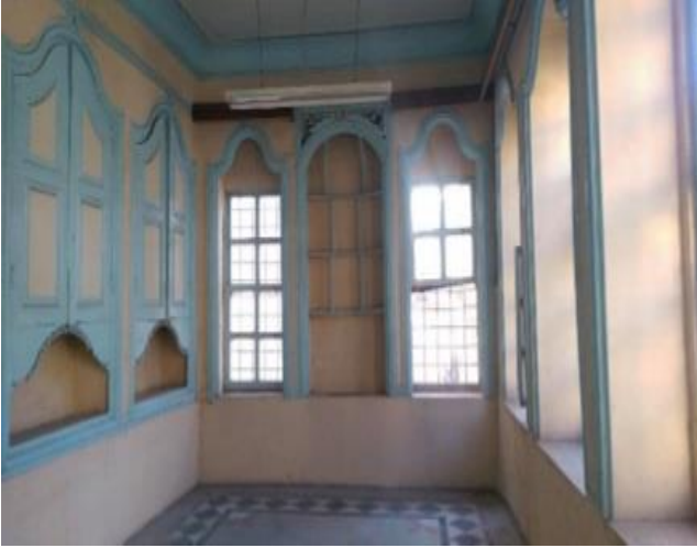
Şekil 4.72: Zemin kattaki odanın içten görünümü.
