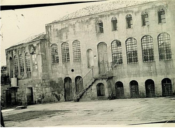
Şekil 4.115: Çatomun eski hali. (Şehit Sakıp İlkokulu Tarihçesi,1965)
