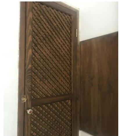
Şekil 4.166: Yenilenmiş ahşap pencereler (Tuba Fazlıağaoğlu Arşivi)
