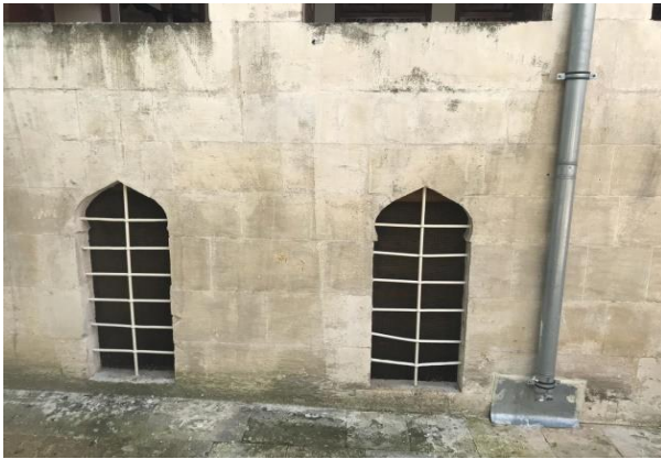
Şekil 4.51: Yenilenmiş dış cephe. (Tuba Fazlıağaoğlu Arşivi)
