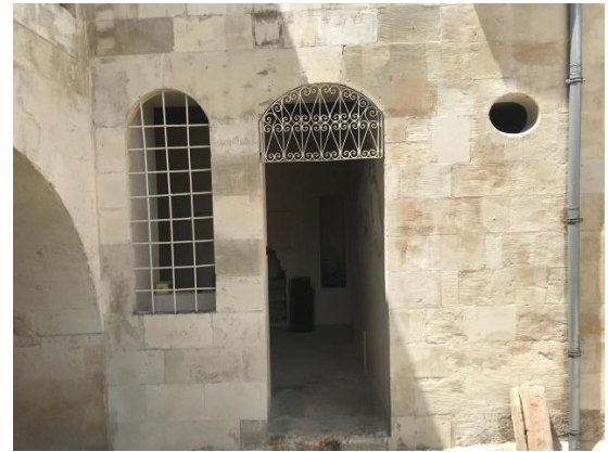
Şekil 4.52: Yenilenmiş dış cephe. (Tuba Fazlıağaoğlu Arşivi)
