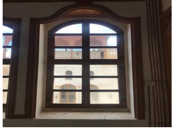
Şekil 4.110: Yenilenmiş ahşap doğramalar. (Tuba Fazlıağaoğlu Arşivi)
