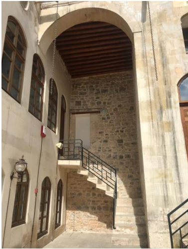
Şekil 4.99: Yeni merdivenler. (Tuba Fazlağaoğlu Arşivi)
