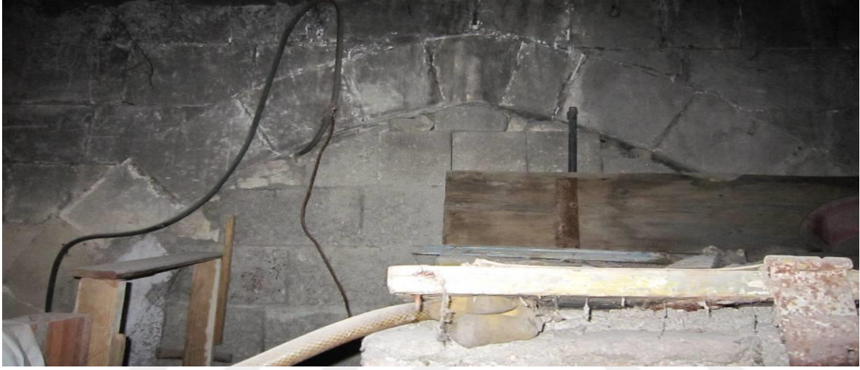
Şekil 4.152: Zemin katta kapatılan eyvanın görünüşü.
