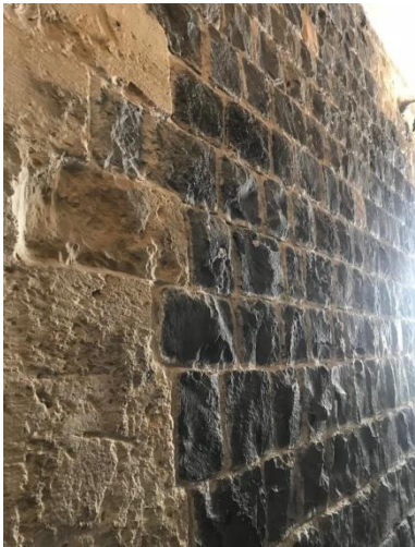
Şekil 4.240: Yenilenmiş duvar detayları.
