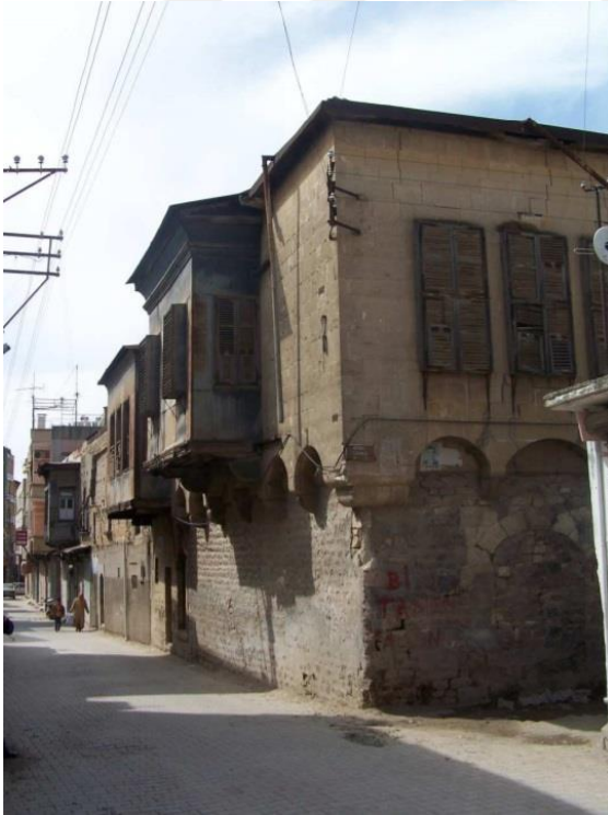
Şekil 3.17 : Çıkma örneği, Kilis. (Savaşçioğlu, 2008)
