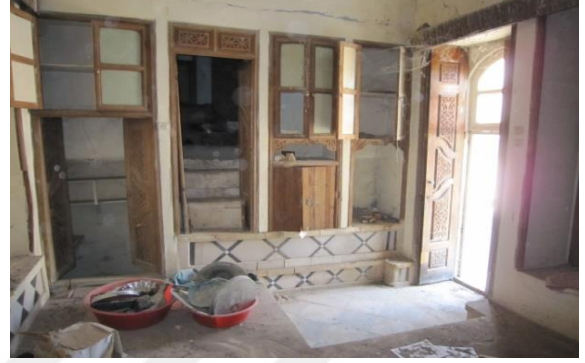
Şekil 4.33: Oda haznası, çıkması ve tazarı.
