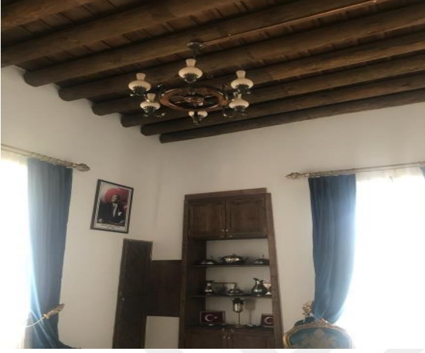
Şekil 4.167: Yenilenmiş tavan ve aydınlatmalar. (Tuba Fazlıağaoğlu Arşivi)
