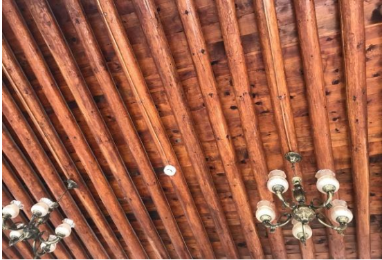
Şekil 4.107: Ahşap çatı detayları.
