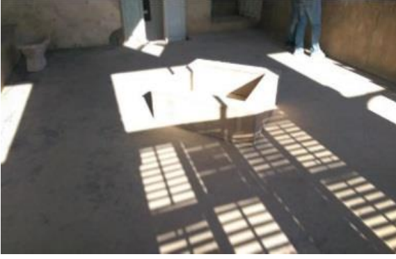
Şekil 4.86: Teras kat zemin döşemesi. (Onur Belgin Arşivi)
