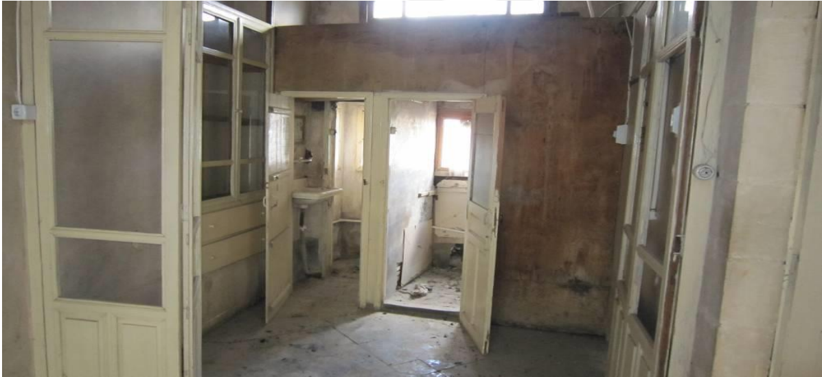
Şekil 4.153: Yapının birinci kat sofasının doğu kanadına yapılan salamanje, lavabo ve WC mekânlarının görünüşü.
