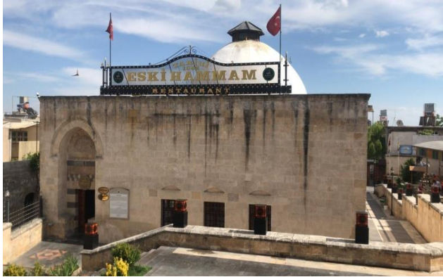
Şekil 4.223: Yenilenmiş hamam dış cephesi.
