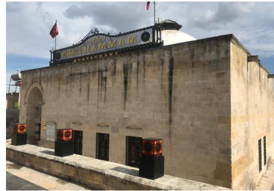
Şekil 4.224: Yenilenmiş hamam dış cephesi.
