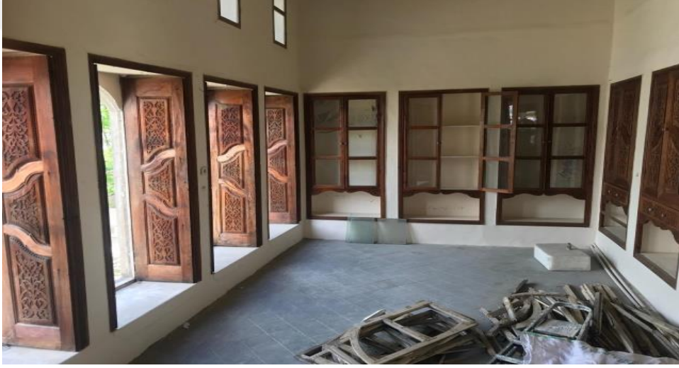
Şekil 4.53: Yenilenmiş ahşap pencere, kapı, dolap kapakları.
