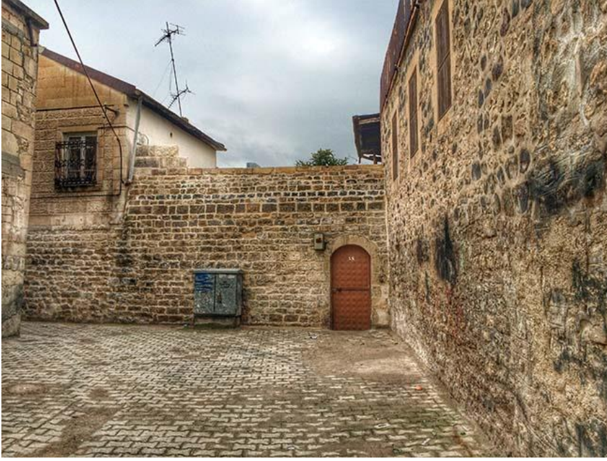
Şekil 3.14: Çıkmaz sokak örneği, Kilis.
