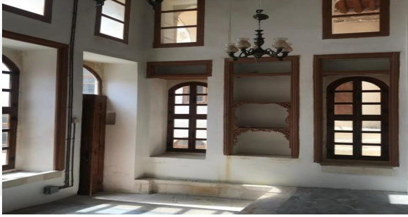
Şekil 4.111: Yenilenmiş ahşap doğramalar. (Tuba Fazlıağaoğlu Arşivi)
