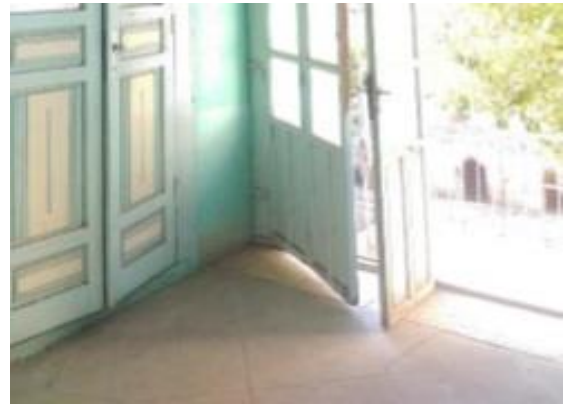
Şekil 4.81: Üst kat zemin döşemeleri. (Onur Belgin Arşivi)
