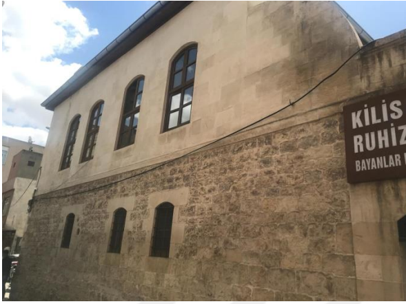
Şekil 4.157: Yenilenmiş dış cephe görünüşü.
