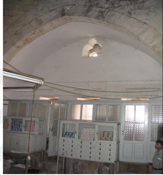
Şekil 4.182: Kilis Paşa hamamı soğukluk.
