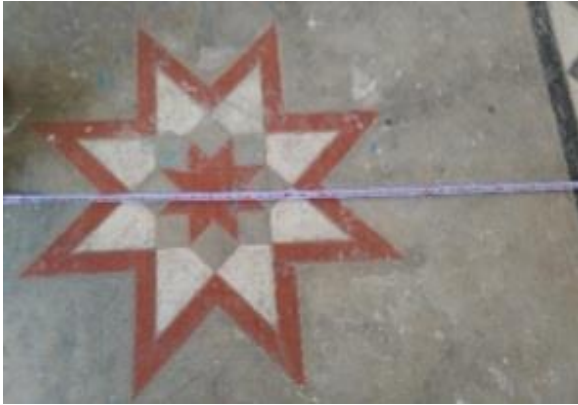
Şekil 4.80: Üst kat zemin döşemeleri. (Onur Belgin Arşivi)
