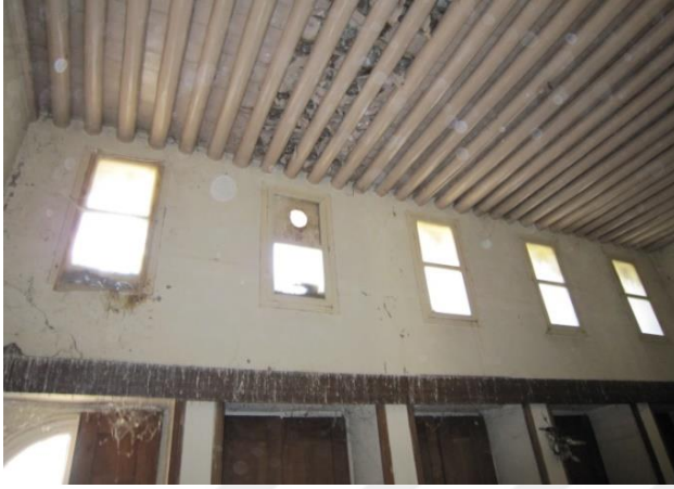
Şekil 4.36: Yaşam odası kirişleri ve kuş pencereleri. (Ahmet Yavuzylmaz Arşivi)
