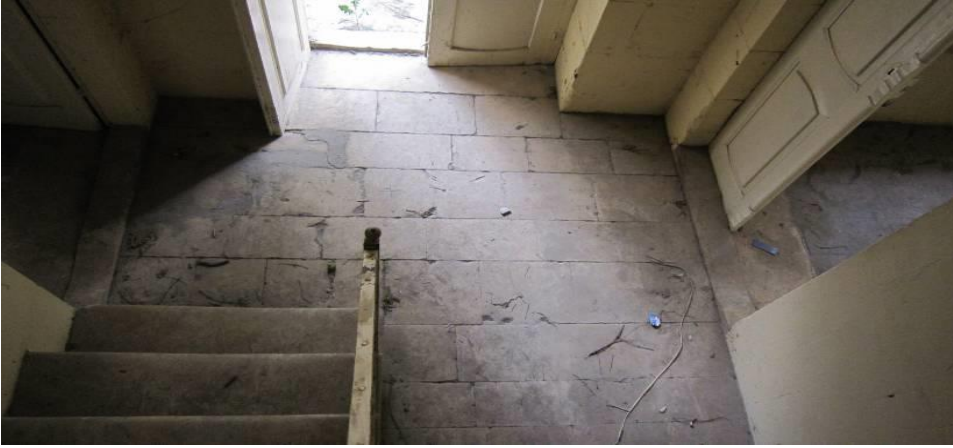
Şekil 4.151: Yapının zemin kat sofa yer döşemesinin görünüşü.
