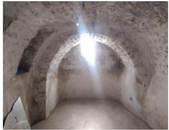
Şekil 4.66: Bodrum kat görünüşleri.
