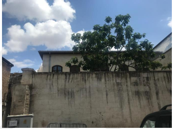
Şekil 4.158: Yenilenmiş dış cephe görünüşü.
