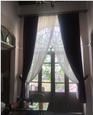
Şekil 4.164: Yenilenmiş ahşap doğramalar (Tuba Fazlıağaoğlu Arşivi)
