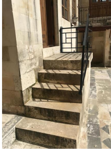
Şekil 4.100: Yeni merdivenler. (Tuba Fazlağaoğlu Arşivi)
