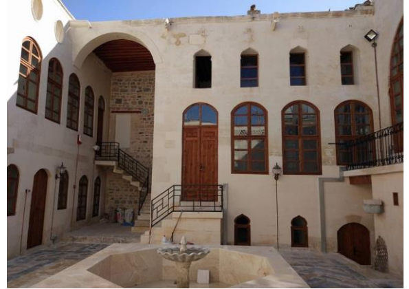
Şekil 4.96: Yenilenmiş avlu cepheleri.
