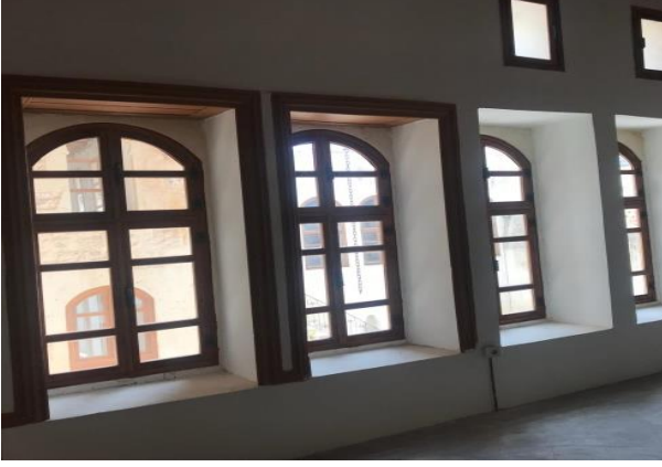
Şekil 4.109: Yenilenmiş ahşap doğramalar. (Tuba Fazlıağaoğlu Arşivi)
