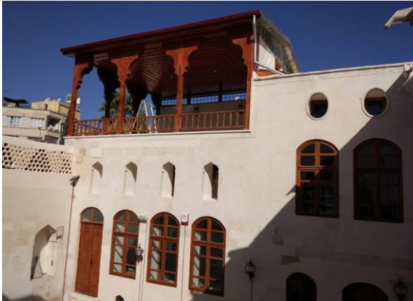
Şekil 4.91: Yenilenmiş avlu cephesi.
