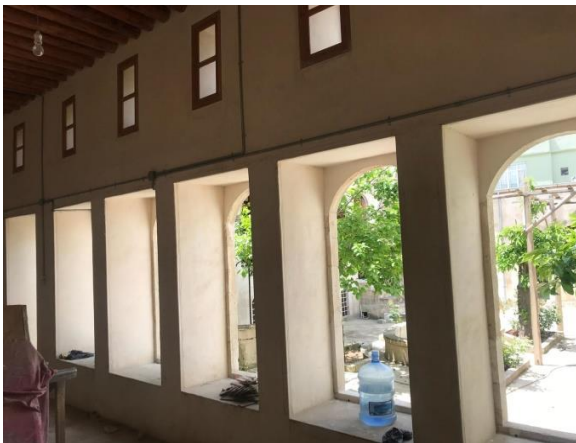
Şekil 4.58: Yenilenmiş pencereler. (Tuba Fazlıağaoğlu Arşivi)
