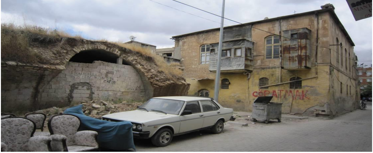
Şekil 4.148: Ruhizade Konağı'nın doğu cephesindeki zeytinyağı imalathanesi.
