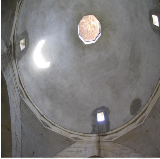
Şekil 4.198: Kubbenin içten görünüşü.
