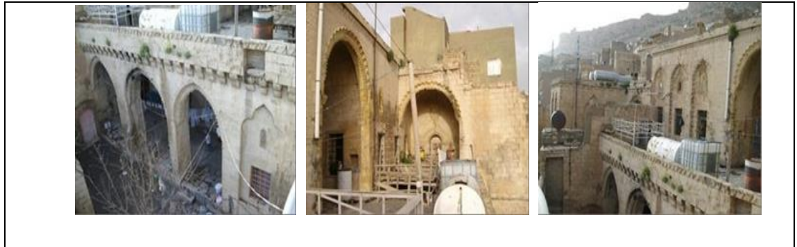
Şekil 4.108. Yapı’ya Ait Avludan Fotoğraf (Karagülle,2008)
