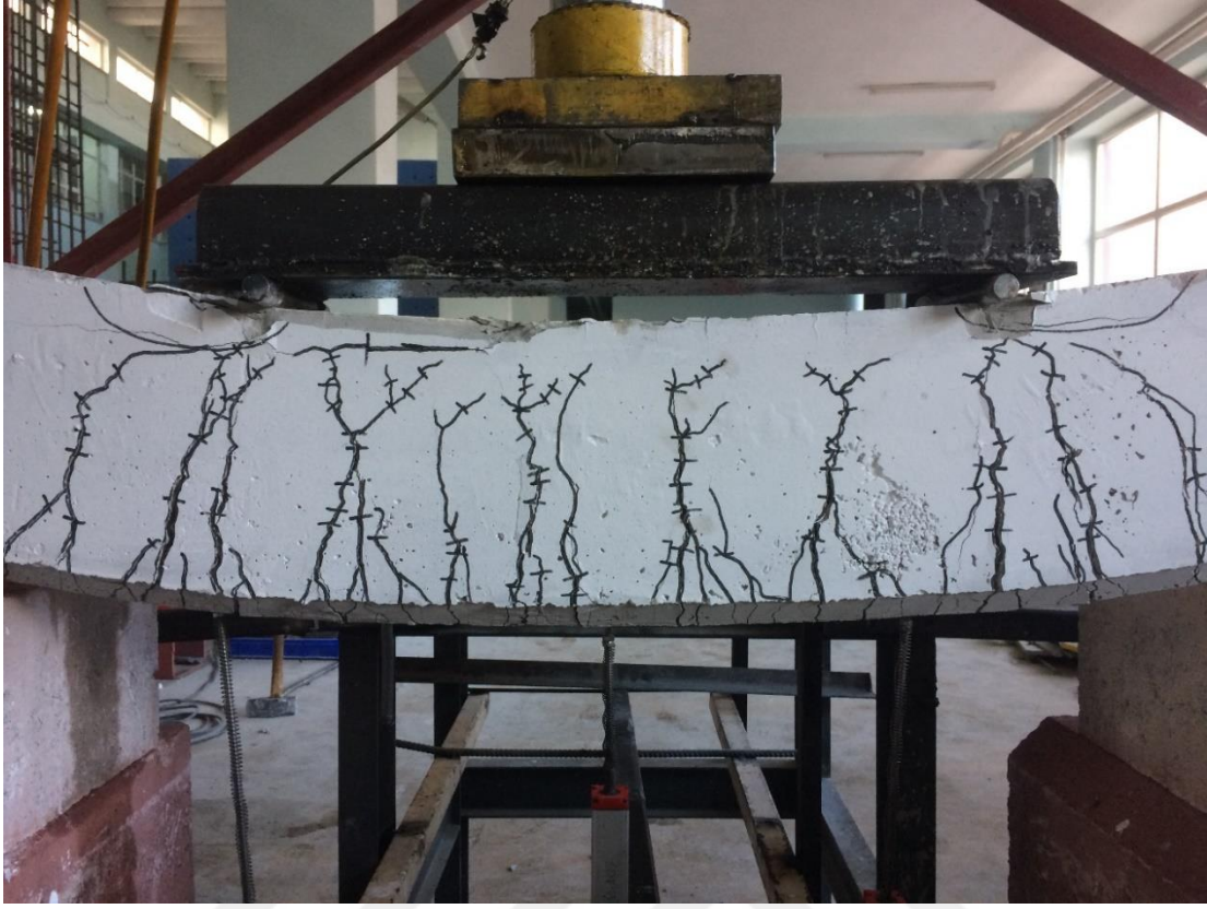
Şekil 4.31. NOR-C30-10 deney elemanının deney sonundaki çatlak dağılımı
