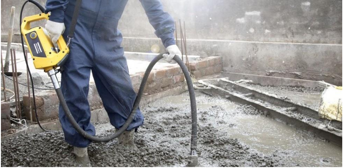
Şekil 1.1. Betonda vibrasyon uygulaması (Anonim, 2018a)
