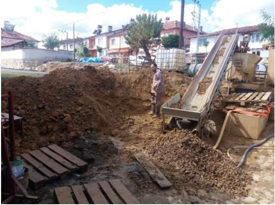
Fotoğraf 32 : Kınık Toprağının Titreşimli Elekten Geçirilmesi (Saadet MEKE 2018)
