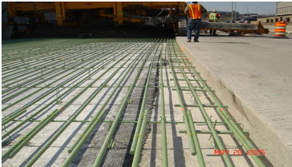
Şekil 2.27. Sürekli Donatılı Beton Kaplama uygulaması. (Illinois 2005) [39].
