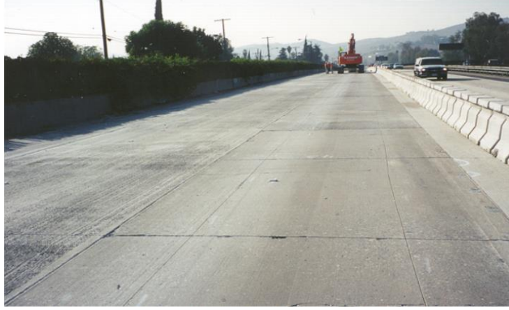
Şekil 2.23. Derzli Donatısız Beton Kaplama imalatı (JPCP) [36].
