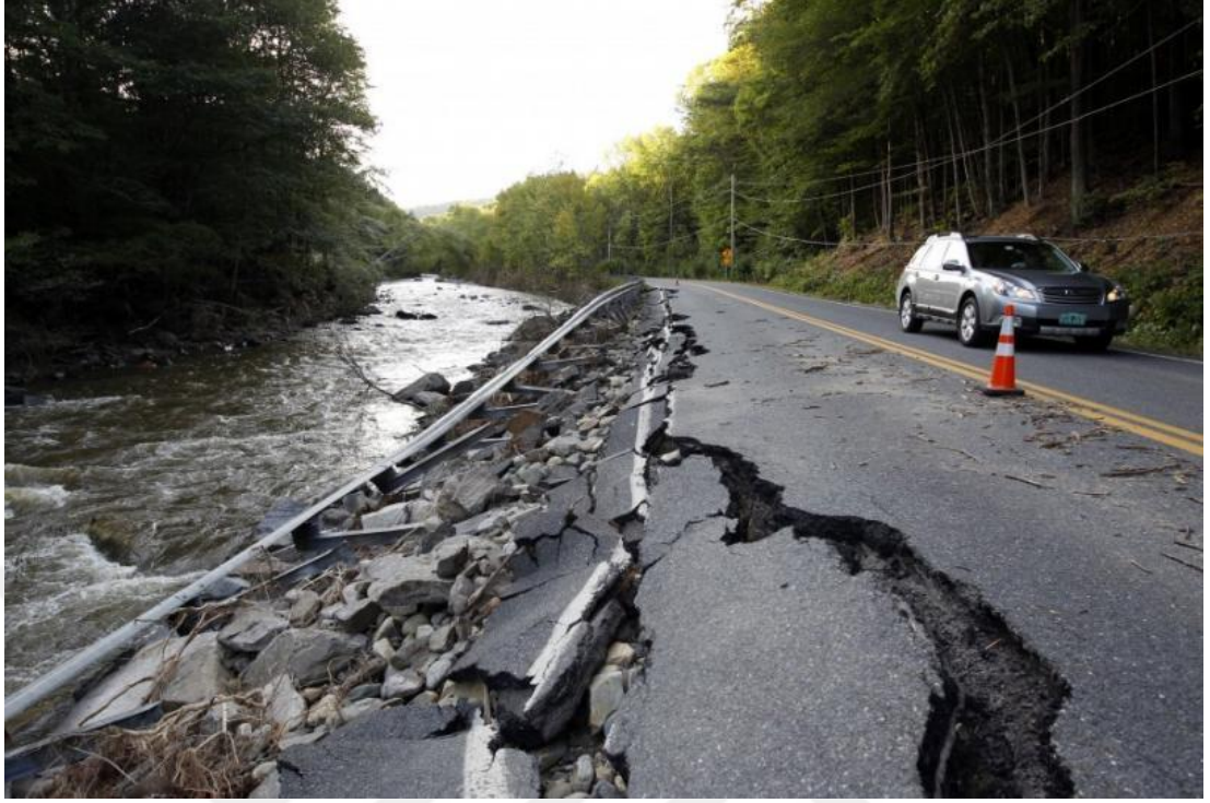
Şekil 4.1. Çevresel faktörler sebebiyle ortaya çıkan deformasyon [68].
