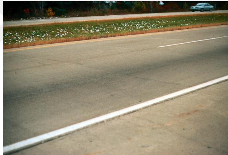
Şekil 2.25. Derzli Donatılı Beton Kaplama Uygulaması [37].
