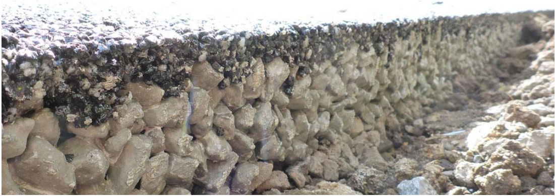
Şekil 2.30. Geçirimli (poroz) Beton Yol [47].
