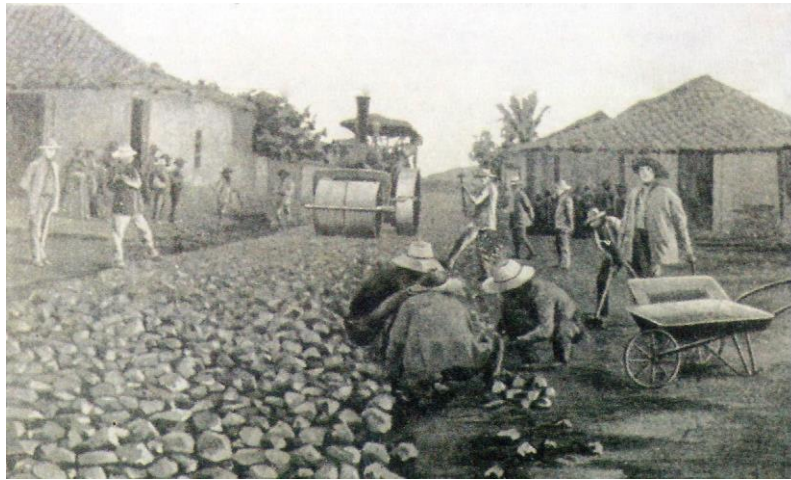
Şekil 2.3. İlk Makadam tipi üstyapı kaplama uygulamaları [11].
