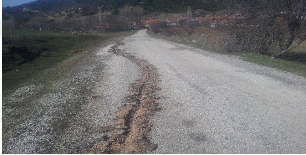
Şekil 5.7. Toprak işleme aletinin yola teması sonrası meydana gelen deformasyon.
