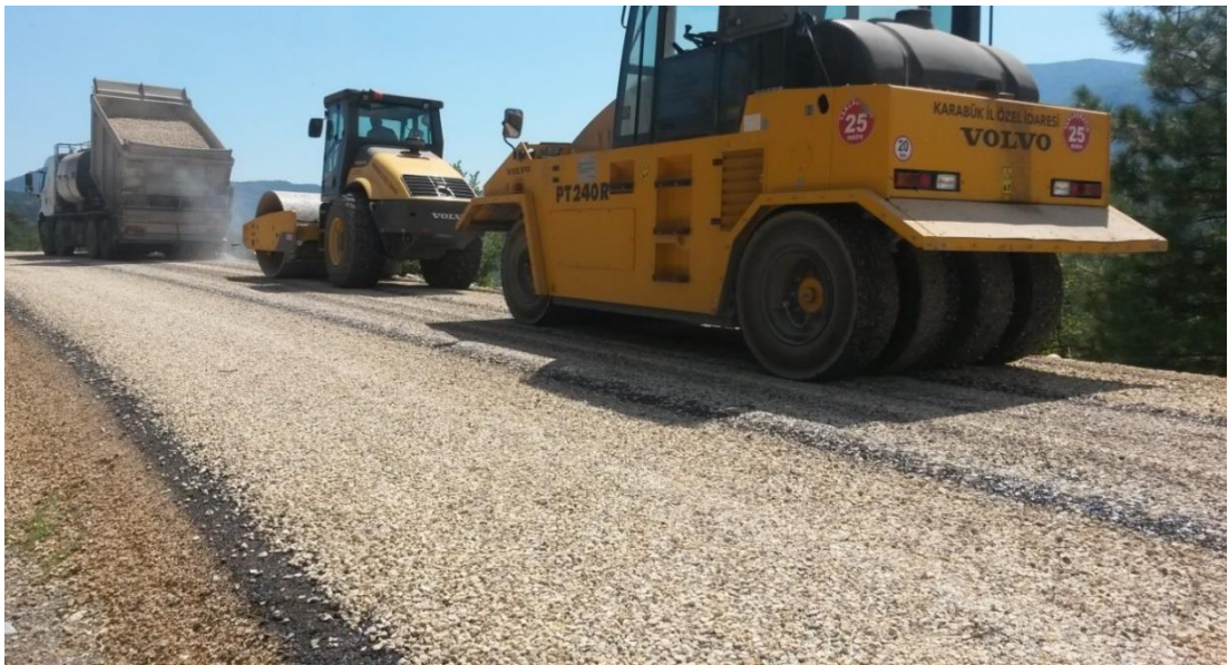
Şekil 2.4. Satih Kaplama uygulaması (Yirmibeşoğlu Köyü, Yenice)
