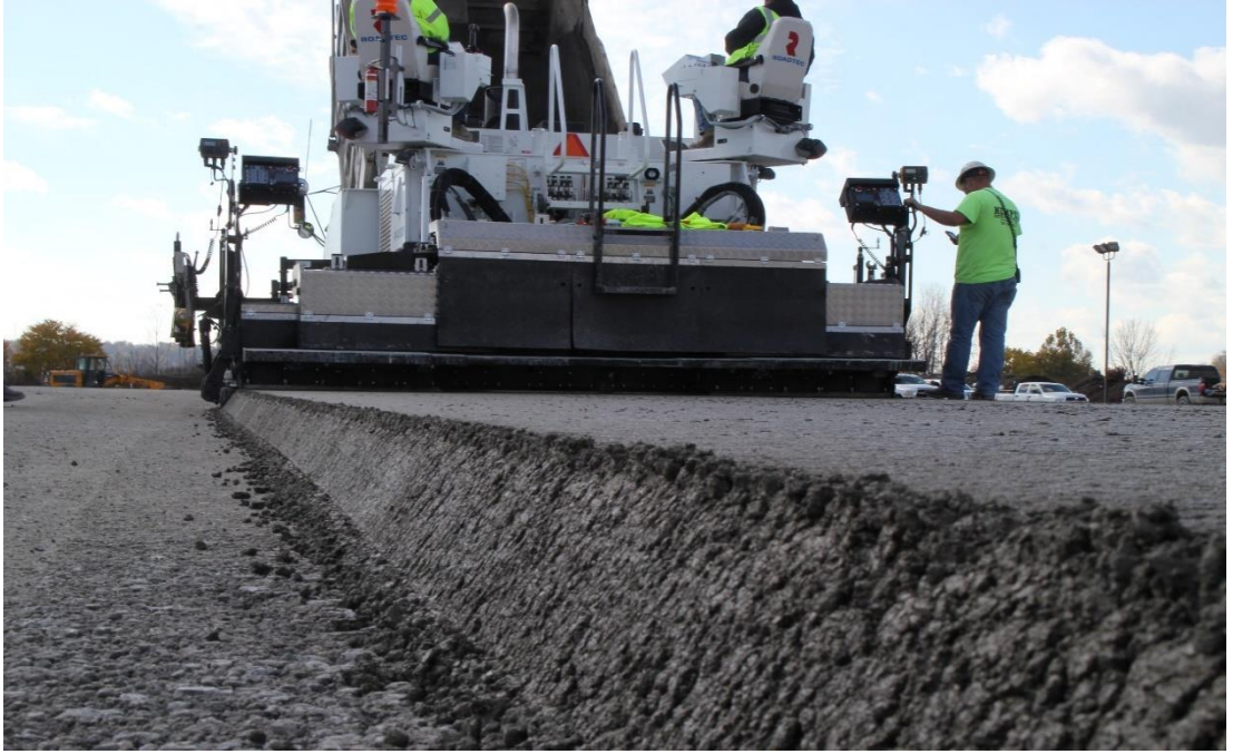
Şekil 2.29. Finişerle sıkıştırılması yapılan SSB yol uygulaması [44].
