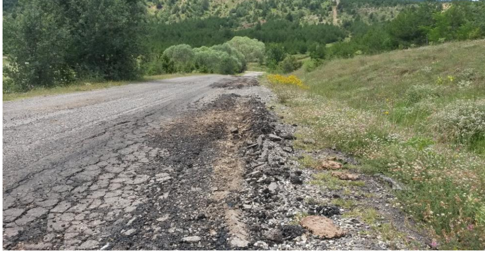
Şekil| 5.9. Eskipazar köy yollarının muhtelif yerlerinde oluşan kabarmalar.
