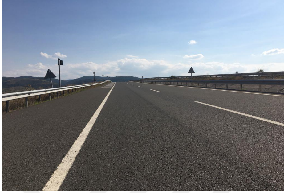
Şekil 2.7. Bitümlü sıcak karışım (BSK) üstyapı uygulaması. (Karabük- Gere de yol ayrımı)
