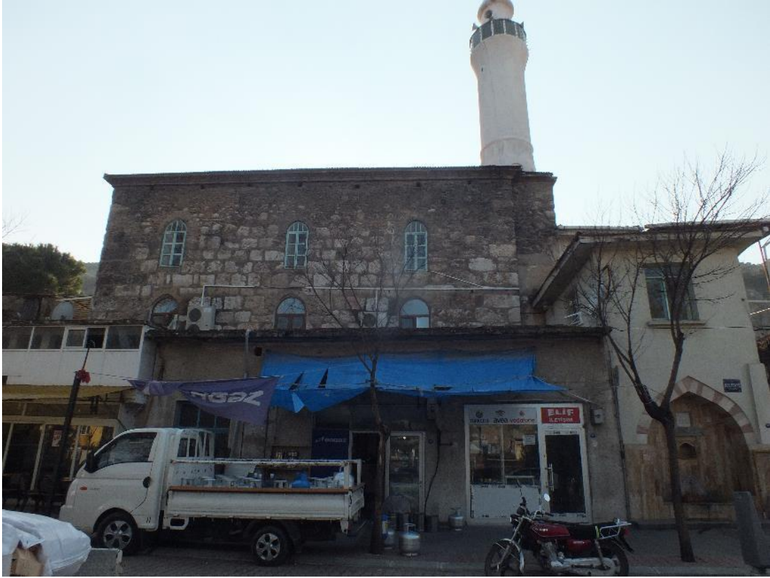
Resim 39 : Kemalpaşa Emet Bey Cami kuzeydoğu cephe.
