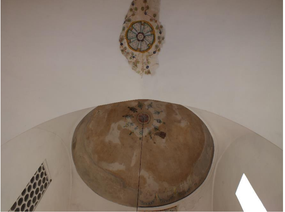
Resim 18 : İshak Çelebi Türbesi kubbesi.
