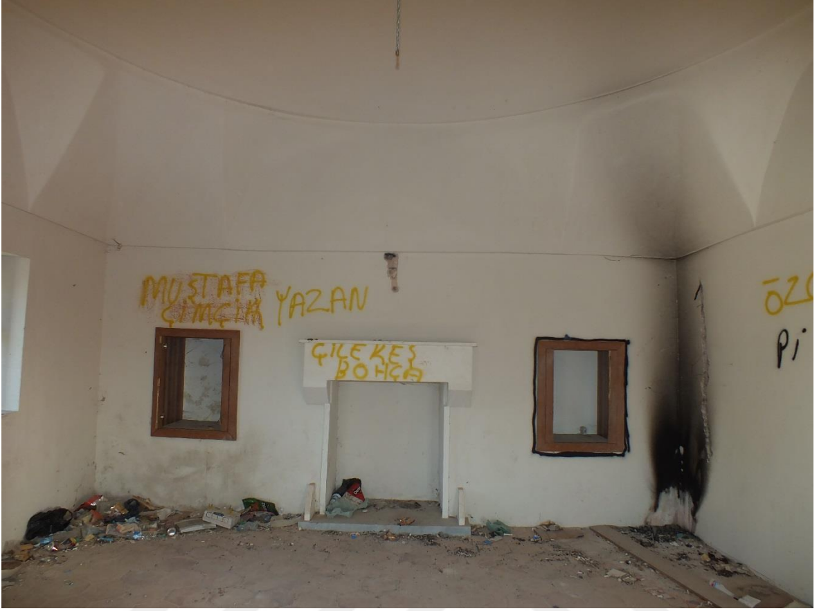
Resim 93 : Darphane içeriden genel görünüm.
