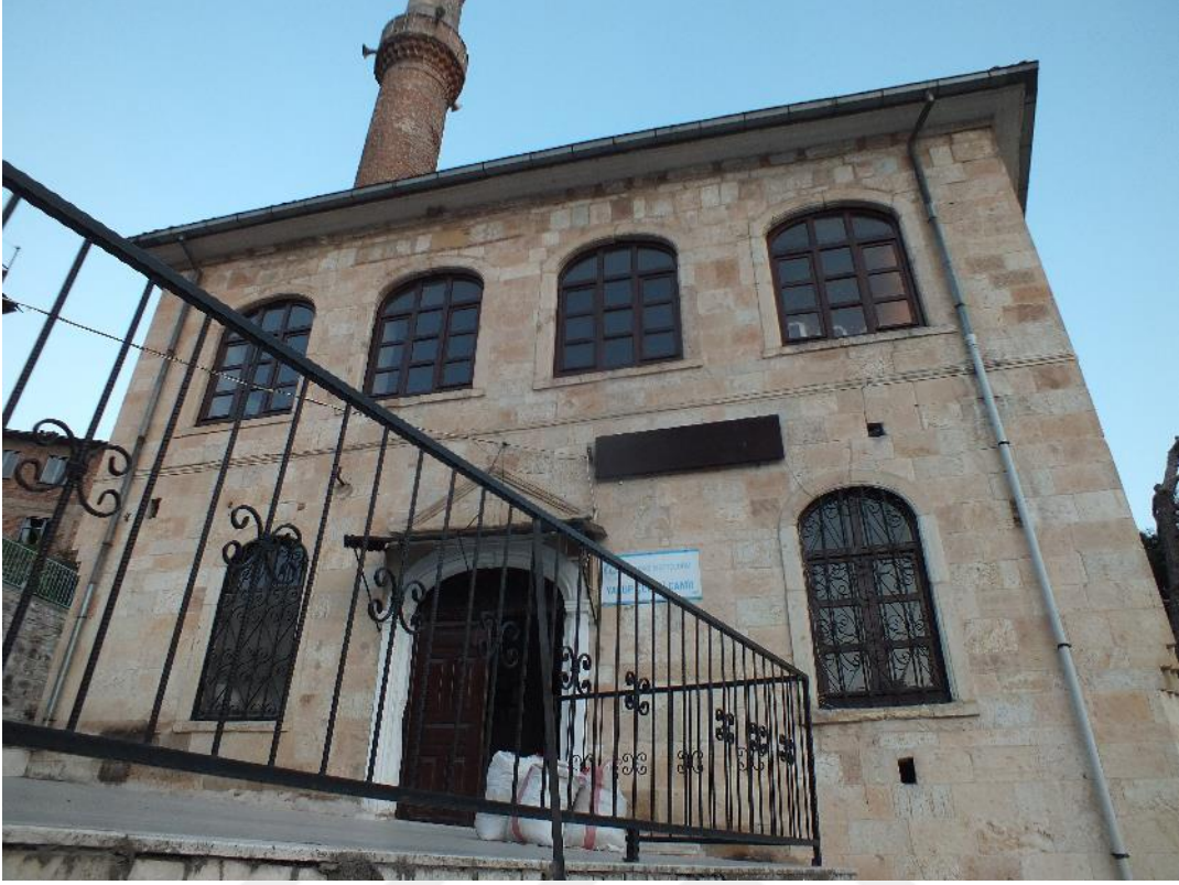
Resim 43 : Demirci Yakup Çelebi Cami kuzeybatı cephe
