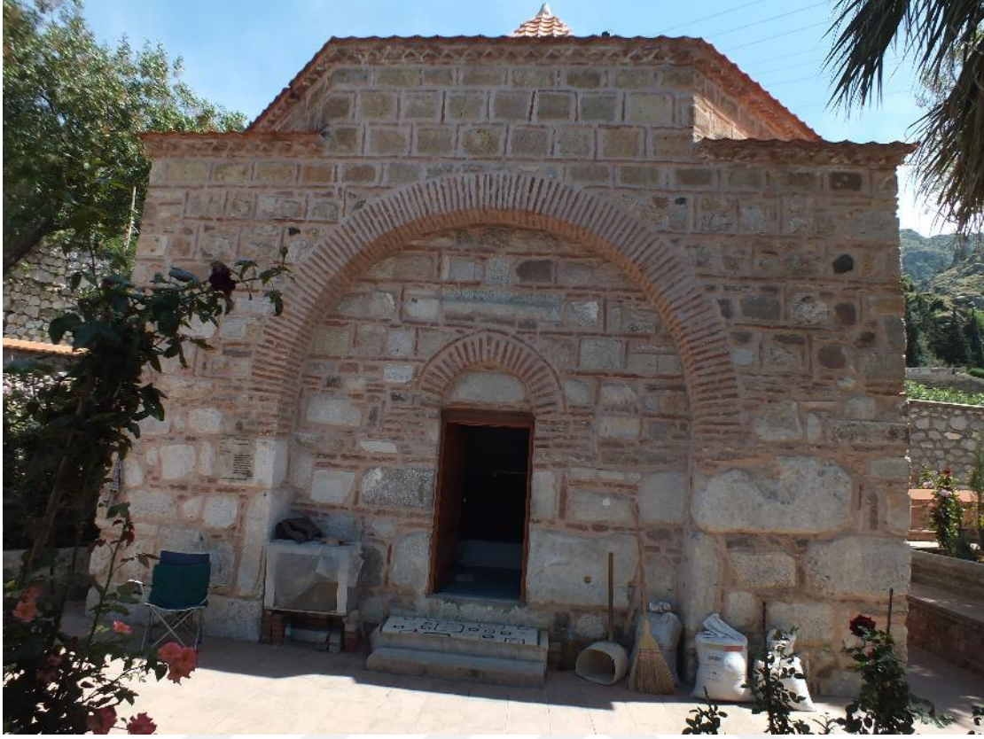
Resim 83 : Revak Sultan Türbesi kuzey cephe.
