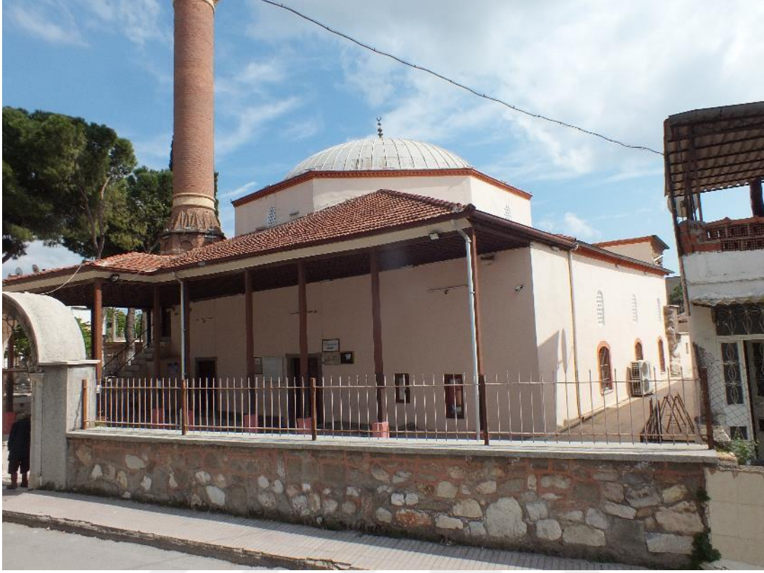
Resim 47 : Akhisar Ulu Cami kuzeybatı cephe.
