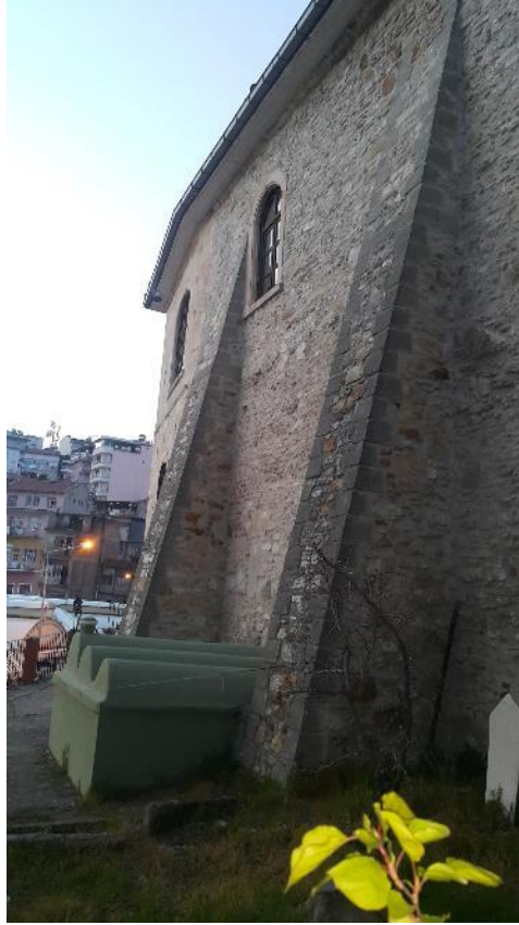
Resim 42 : Demirci Yakup Çelebi Cami güneybatı cephe.
