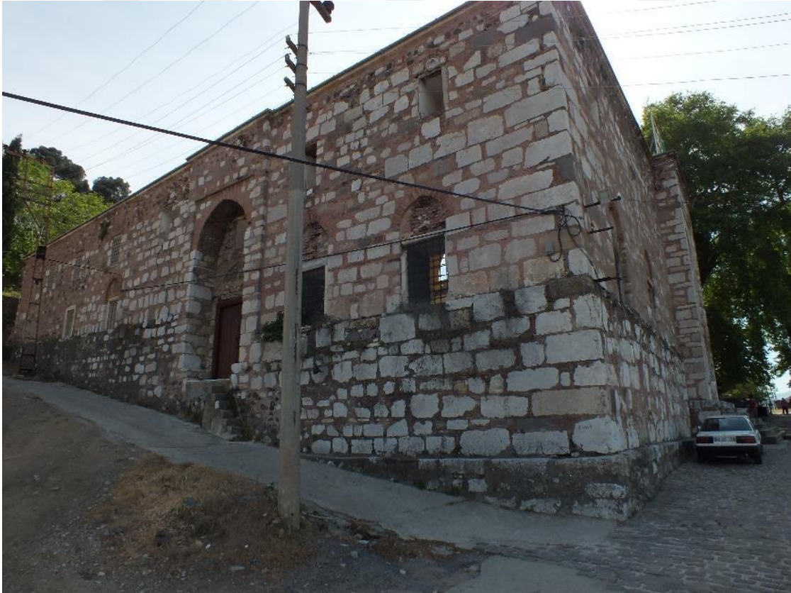
Resim 6 : Manisa Ulu Cami kuzeydoğu cephe.
