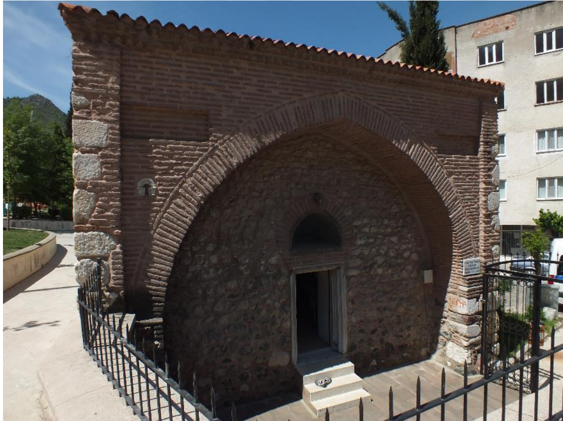
Resim 28 : Yedikızlar Türbesi doğu cephe.
