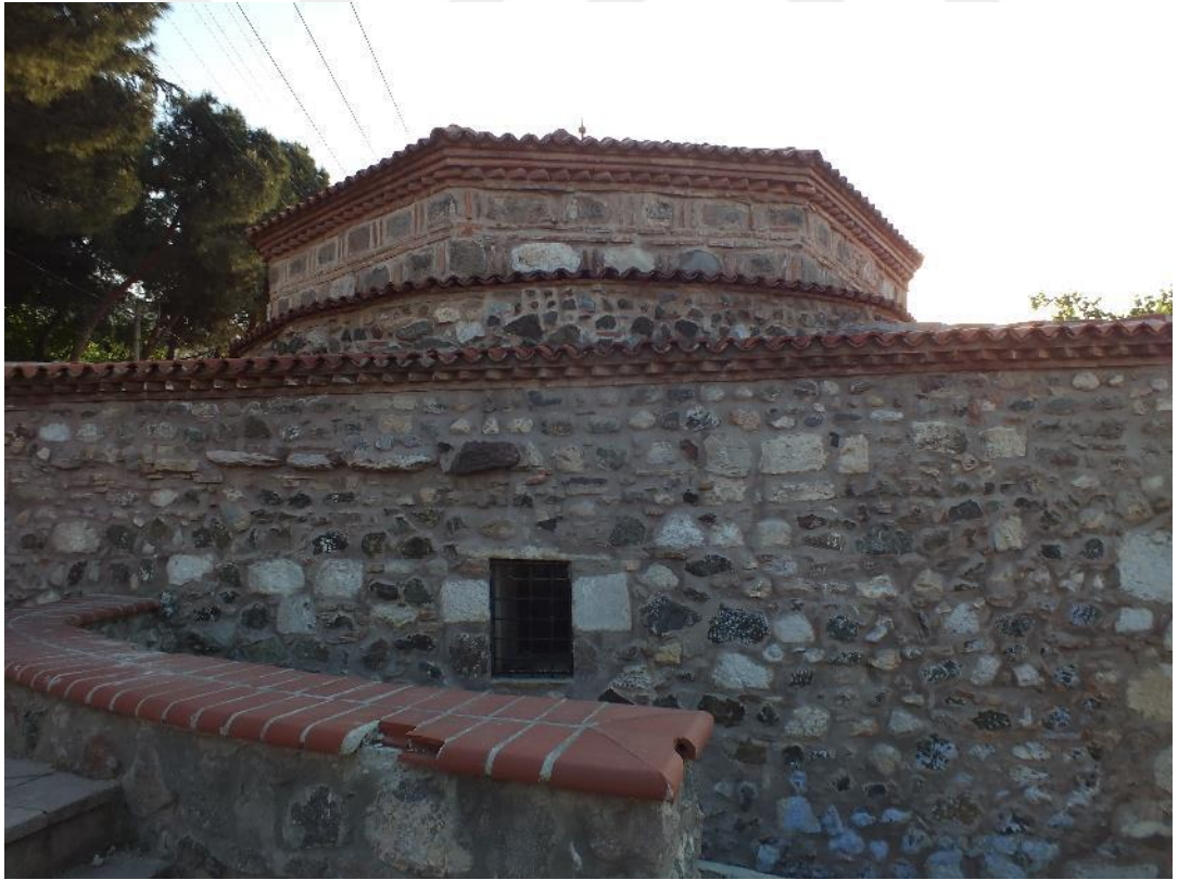
Resim 74 : Seyyit Hoca Tekkesi kuzeydoğu cephe.
