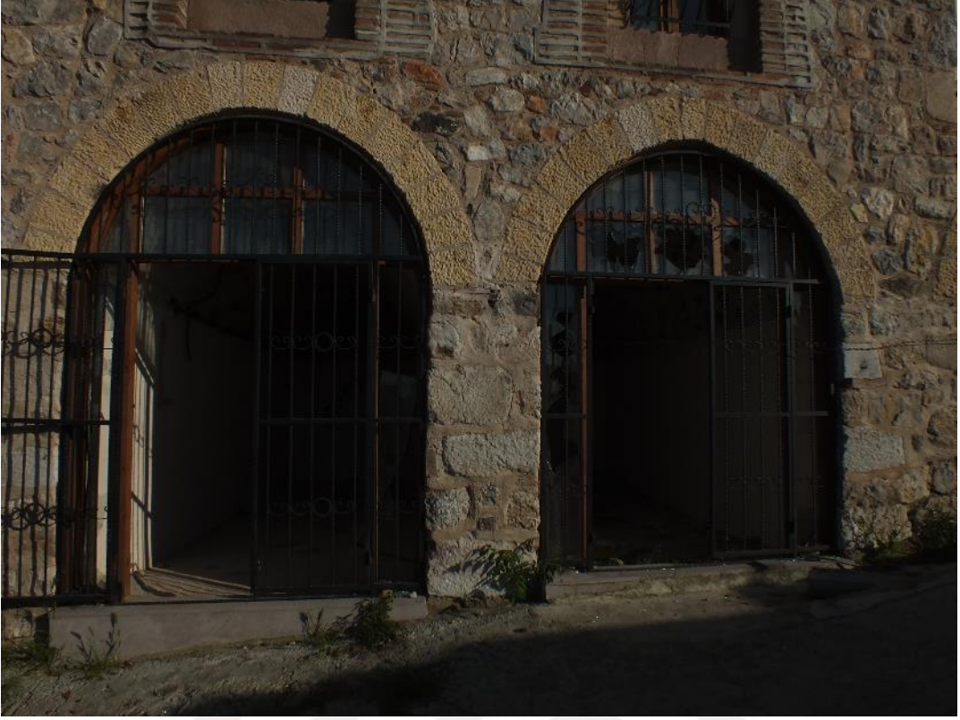
Resim 91 : Darphane kuzey cephe.
