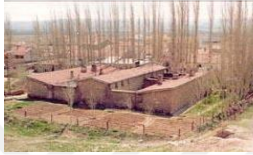
Şekil 3. 44. Şarkışla A2 tipi kapalı ceza infaz kurumu (CTE, 2007)
