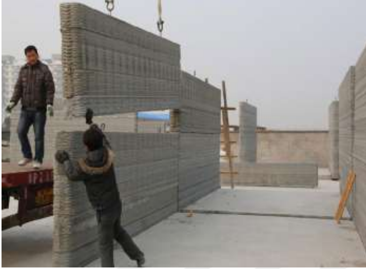
Resim 0.9. Binanın yapım aşamaları ve şantiyeden görünüşler ve 3B yazıcılarla üretilen duvarların yerinde monte edilmesi (URL-28)
