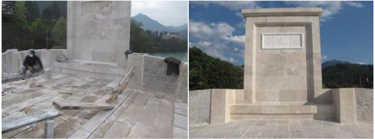
Şekil 3.31 a) Taş yüzeylerde yüz açma çalışması, b) Taş ızgaralar (Sert vd. 2009).
