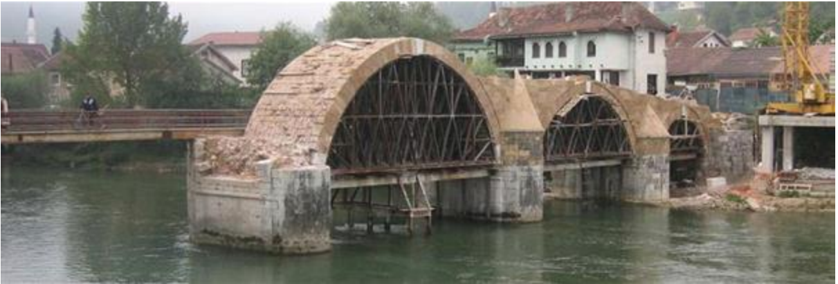
Şekil 3.24 İskele üzerinde tamamlanmış köprü kimeri (Sert vd. 2009).
