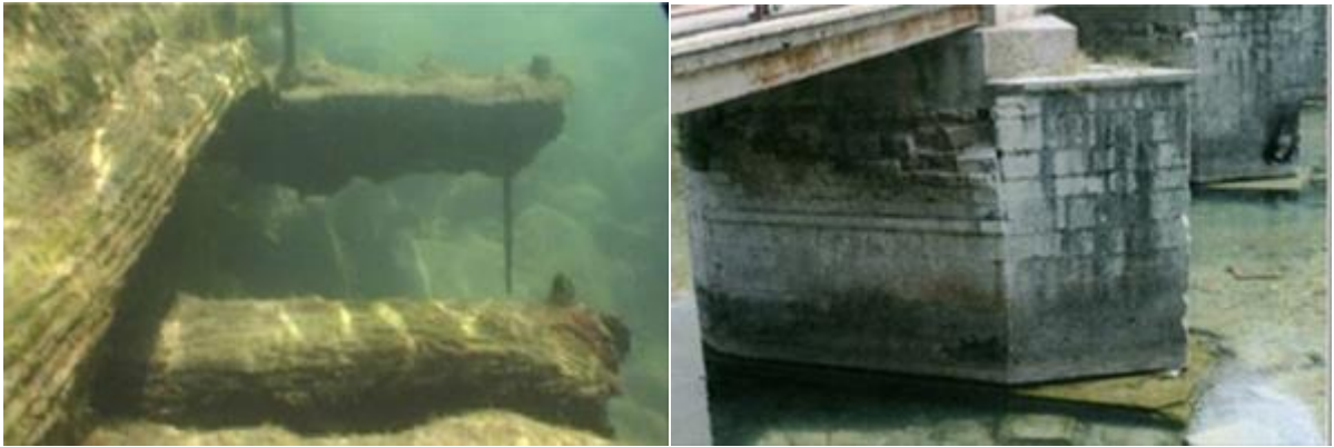
Şekil 3.13 a) Köprü ve kum-çakıl ocağı, b) Zarar görmüş köprü kısımları (Sert vd. 2009).
