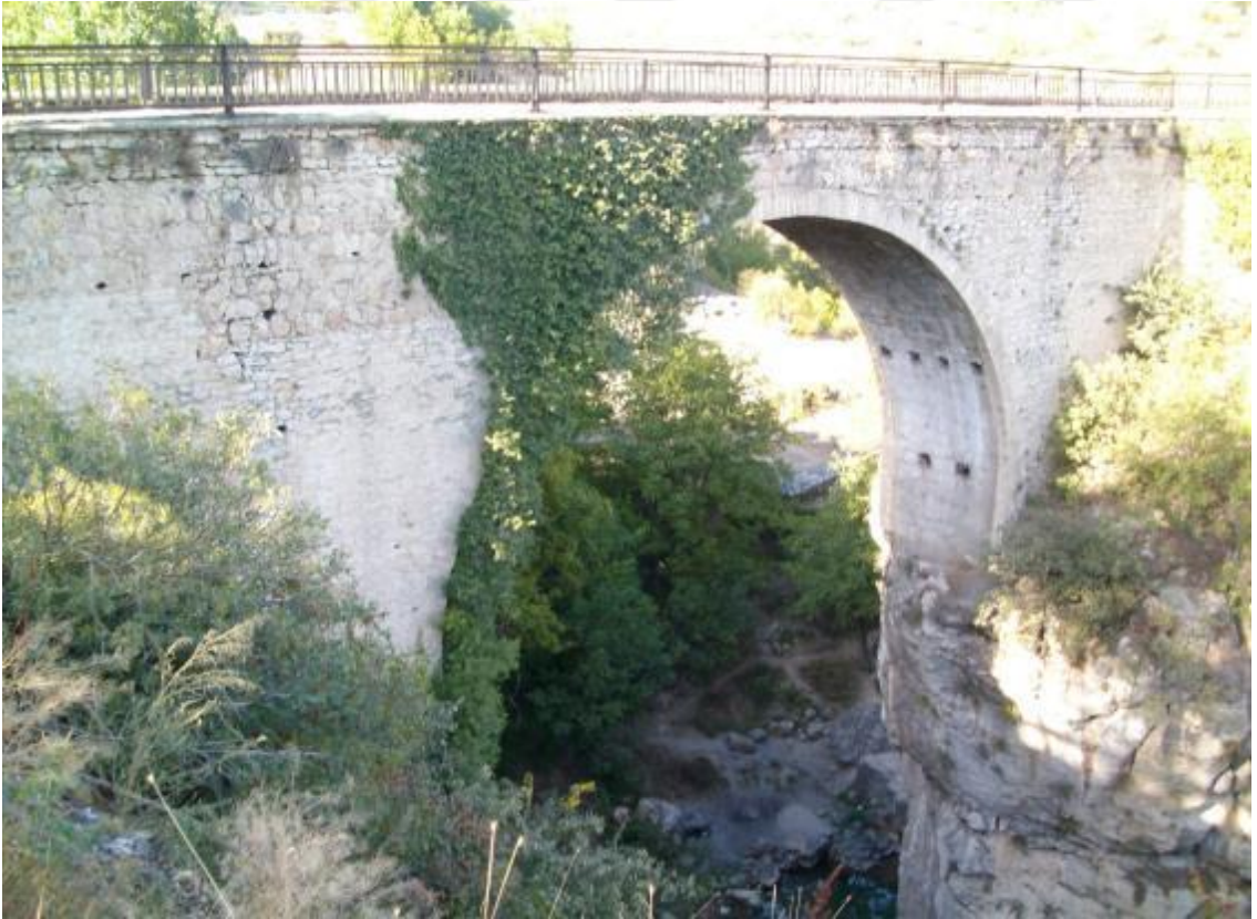
Şekil 4.6 Tarihi Aşağı Tokatlı Köprüsü mansabdan görünüş (Emek 2012).
