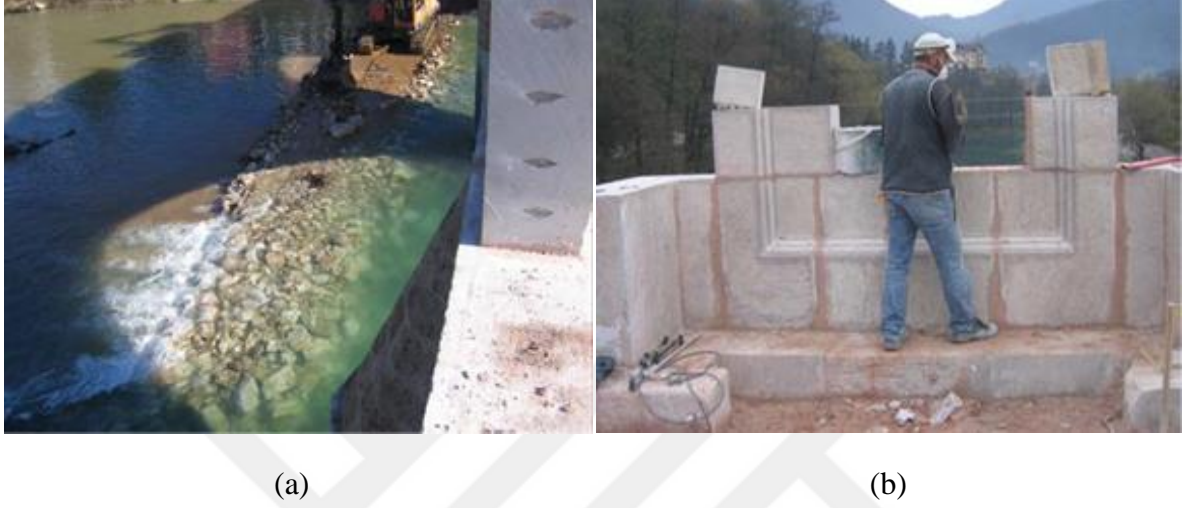
Şekil 3.28 a) Taş tahkimat yapılıması, b) Kitabe köşkünün yapılıması (Sert vd. 2009).
