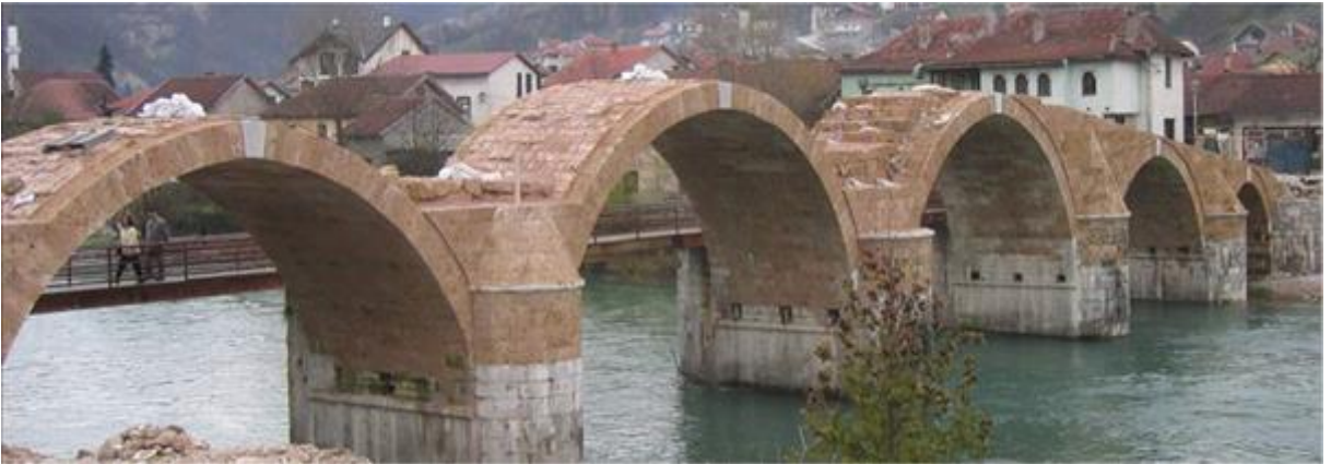
Şekil 3.27 Tamamlanmış köprü kemerleri (Sert vd. 2009).
