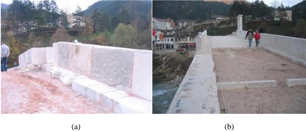
Şekil 3.29 a) Korniş ve korkuluklar, b) Köprü döşemesi (Sert vd. 2009).
