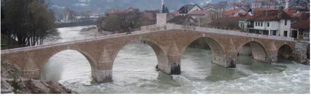
Şekil 3.30 Tamamlanmış korniş, korkuluk ve döşeme (Sert vd. 2009).
