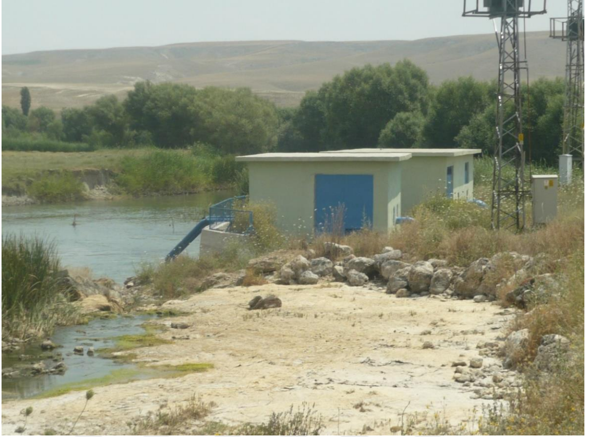
Şekil 4.23 Karabent Köprüsü yanında Sakarya Nehri üzerine kurulmuş motopomp istasyonu
