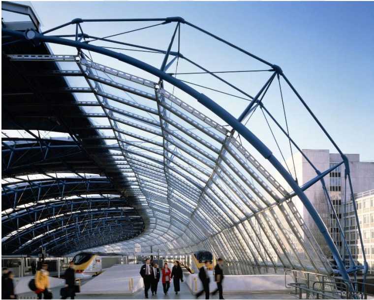
Resim 3.1. Waterloo Uluslararası Terminali çatı örtüsü (URL-27)
