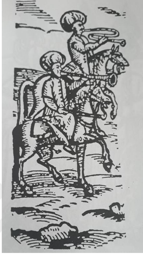
Resim 51. Eski Burmalı Osmanlı Boruları 51
