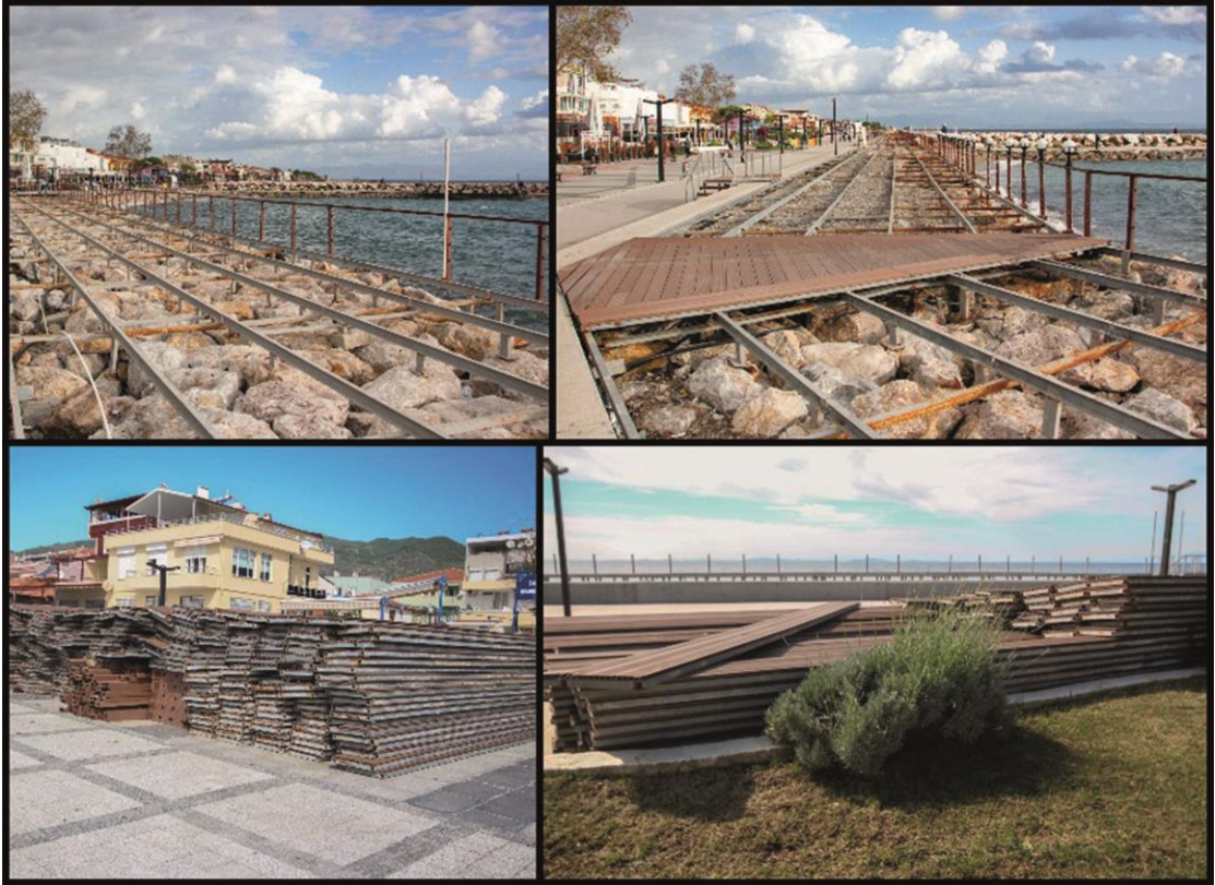
Şekil 20. Platformdaki ahşap kompozit decklerin sökülüş hali (Özgün)
