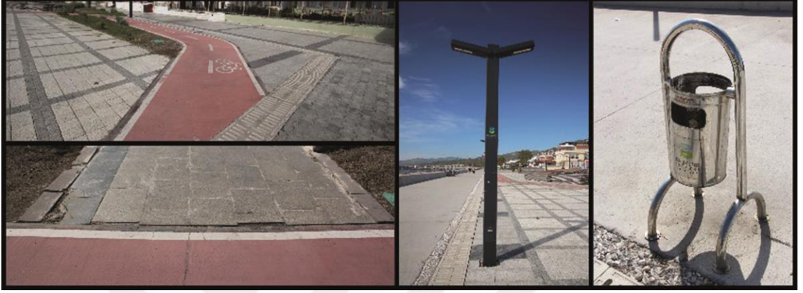
Şekil 27. Donatı elemanlarının mevcut durumu (Özgün)
