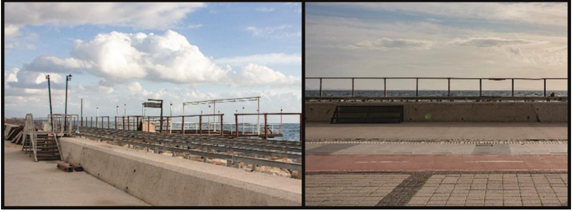
Şekil 17. Manzara değerini kapatan beton bloklar (Özgün)
