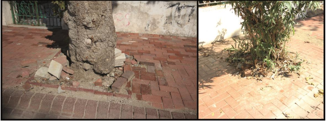
Şekil 57. Döşeme, ağaç dibi ve rögar kapaklarındaki hatalar (Özgün)
