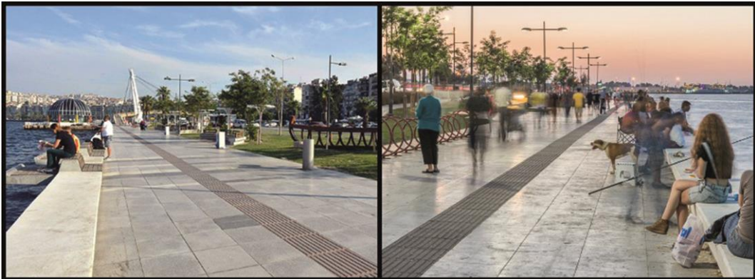
Şekil 65. Kıyı şeridinde hissedilebilir yüzey uygulaması örneği (‘İzmir Büyükşehir Belediyesi’, 2019)
