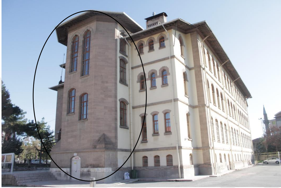
Şekil 4.1.3 : Binada İki Tarafda Bulunan Simetrik Merdiven Boşlukları.
