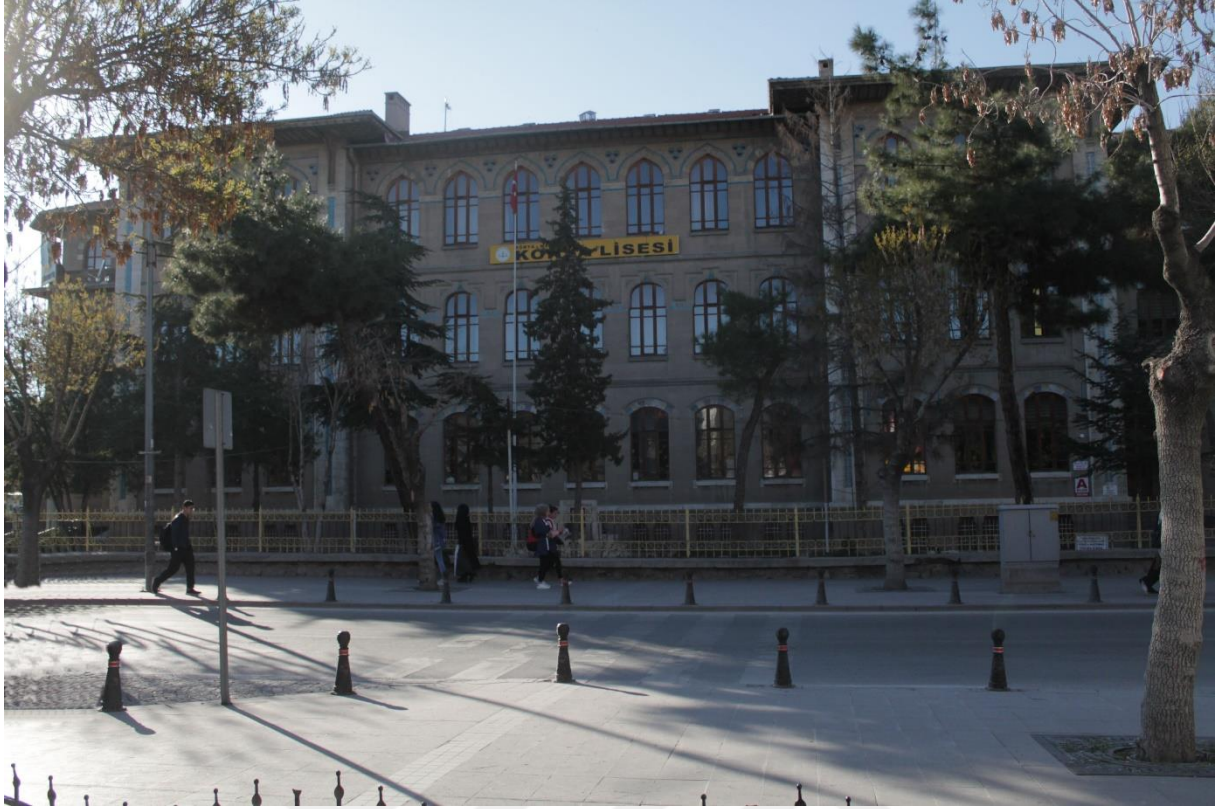
Şekil 3.5.2 : Konya Lisesi Ön Cephesi.
