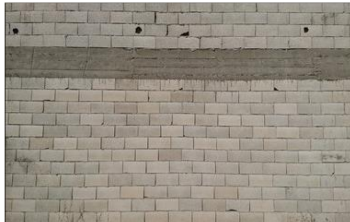
Şekil 3.5: Yatay hatıl eklenerek, briket ile örülmüş duvar. (Web iletisi 2)
