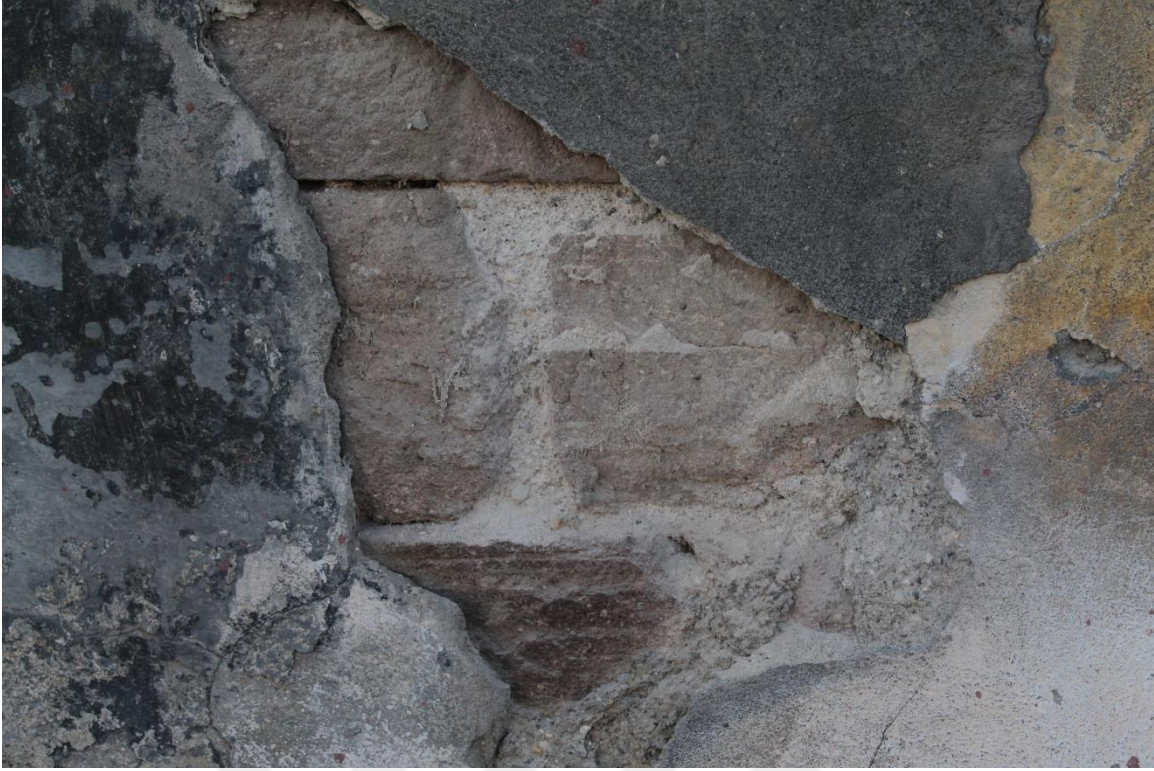
Şekil 4.1.8 : Dış Cephe Duvarında Malzeme Tespiti.
