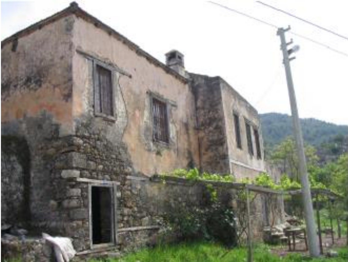
Şekil 3.7: Doğal taş yığma yapı örneği. (Korkmaz, 2007)
