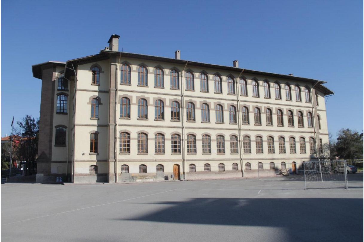
Şekil 3.5.3 : Konya Lisesi Arka Cephesi.
