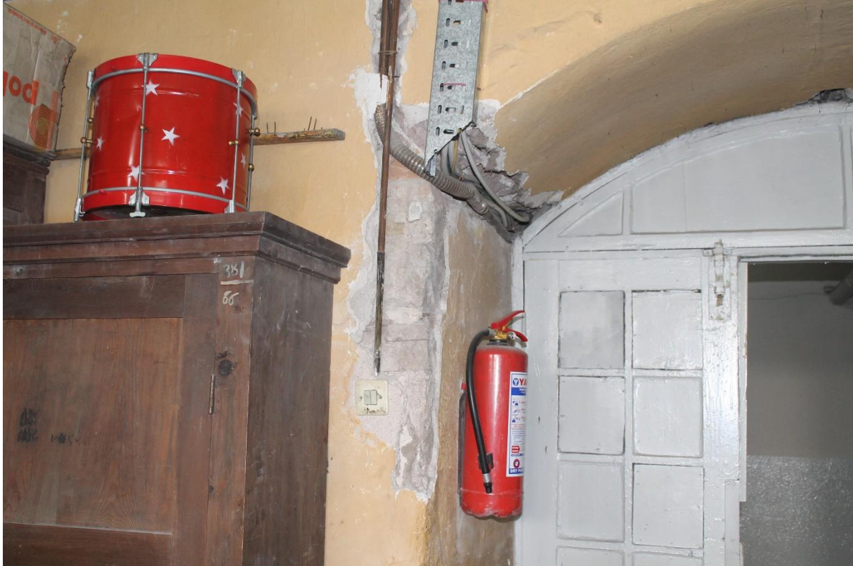
Şekil 4.1.6 : Bodrum Katta Kapı Kemerini Taşıyan Duvarı Malzeme Tespiti.
