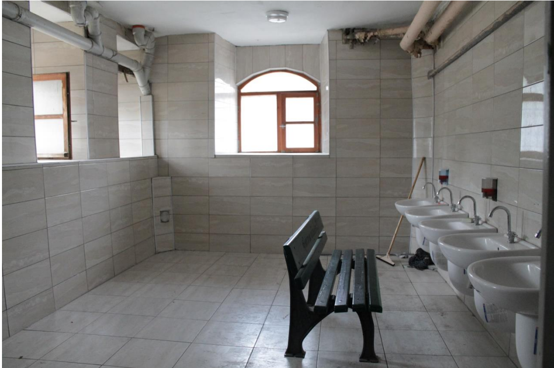
Şekil 4.1.2 : Tadilatı Yapılan Bodrum Kattaki Tuvalet.
