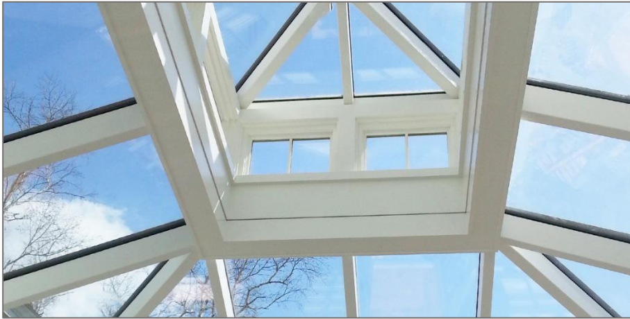
Şekil 3.46: Doğal havalandırma düzeneğine bir örnek
