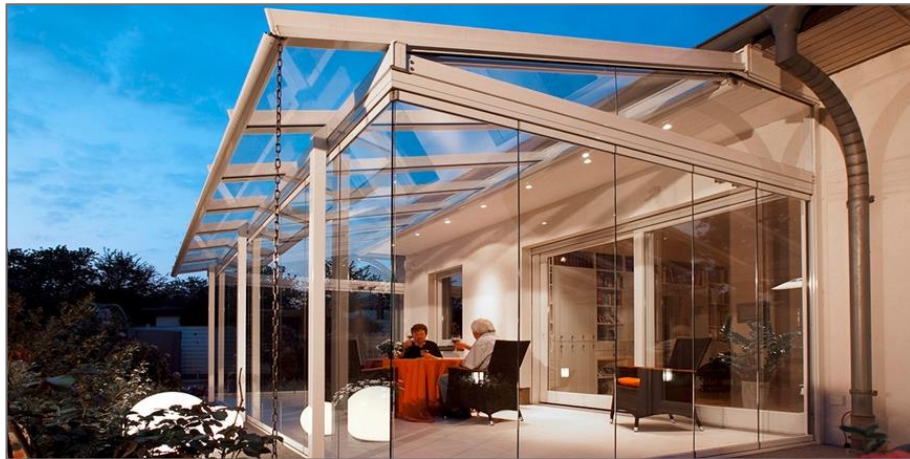
Şekil 3.44: Polikarbonat levha ile kış bahçesi örneği
