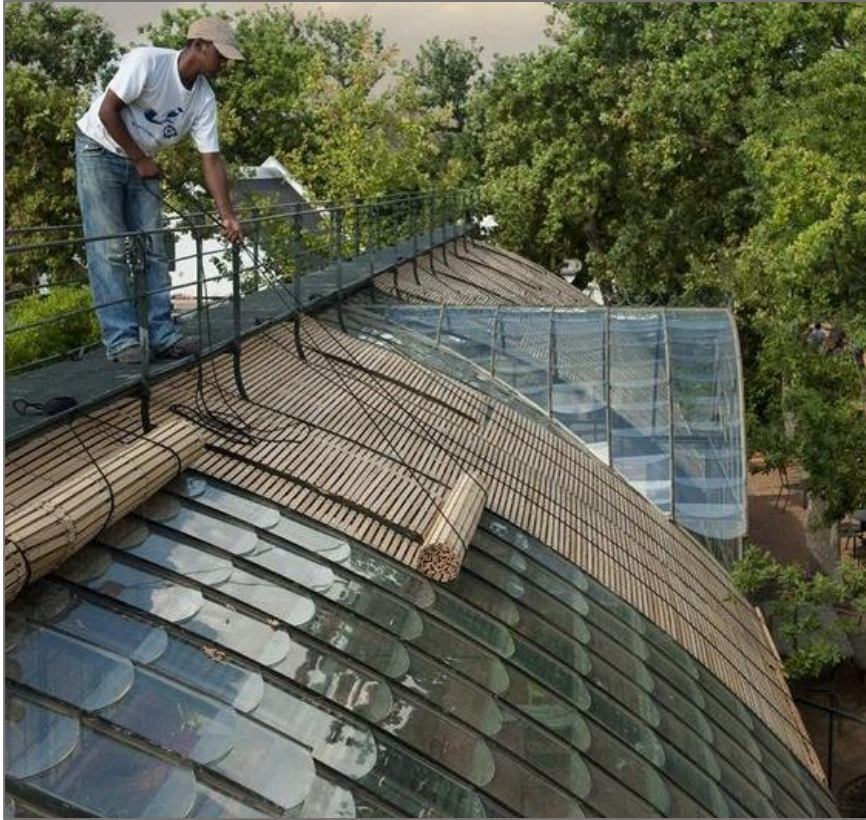
Şekil 3.55: Bambu çatı dış perdeleme sistemi örneği
