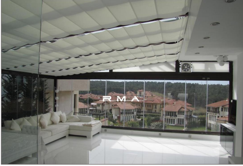
Şekil 3.54: Kumaş çatı iç perdeleme sistemi örneği
