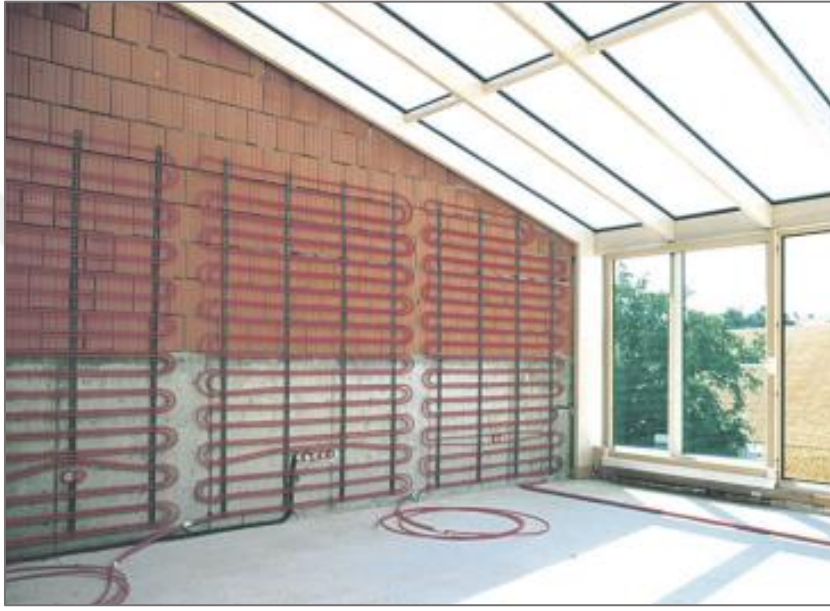
Şekil 3.50: Duvardan ısıtma detayı
