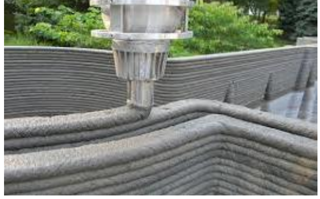
Resim 8 FDM teknolojisi ile ürün prototipleme 13 ve büyük ölçekte beton dökümü 14
