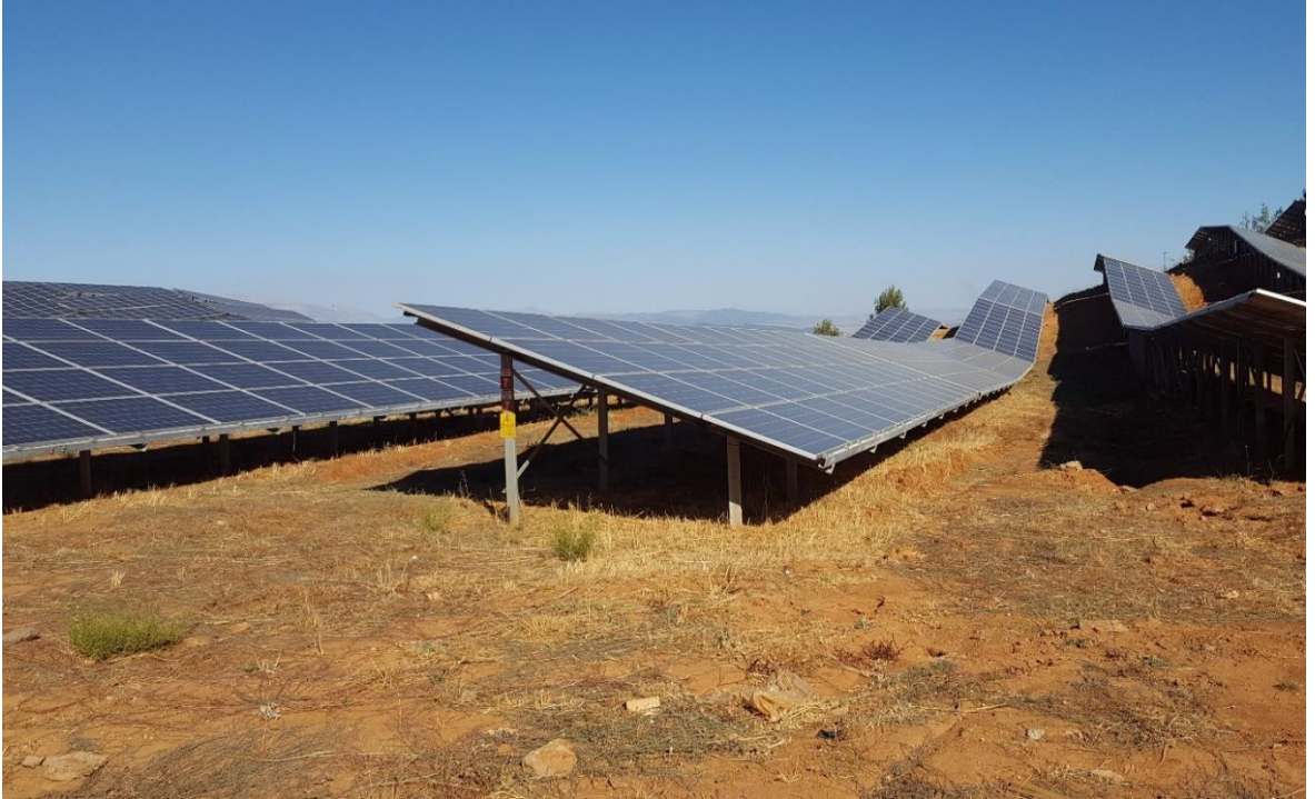
Şekil 4.59. İncelenen Güneş Enerjisi Santralinden Görüntüler-2
