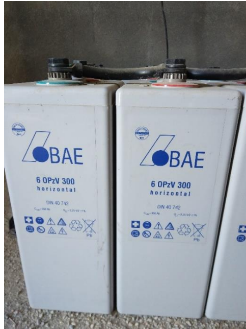
Şekil 6.3. Kullanılan OPzV Jel akü
