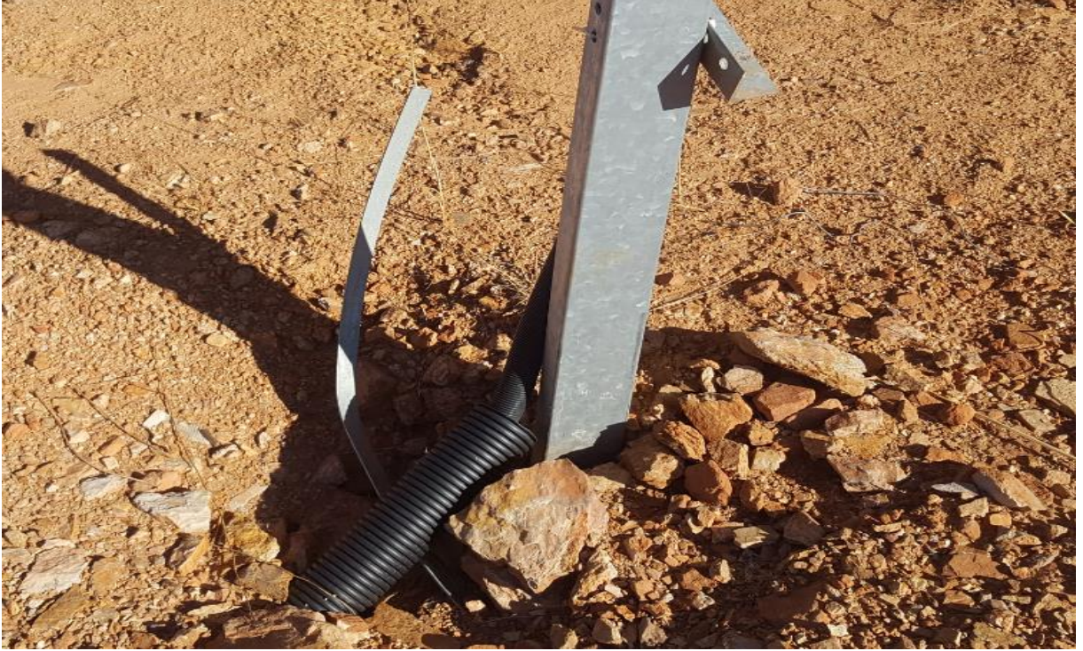
Şekil 4.50. Topraklama Hatası Örneği-1
