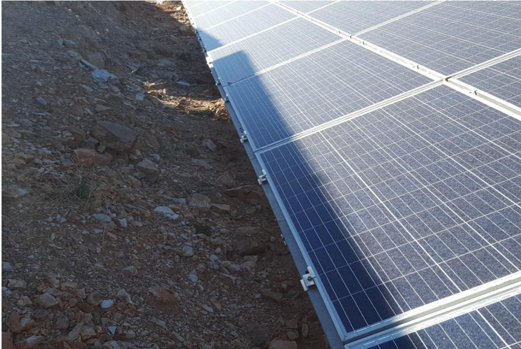
Şekil 4.53. Gölgeleme Sorunu Örneği-2
