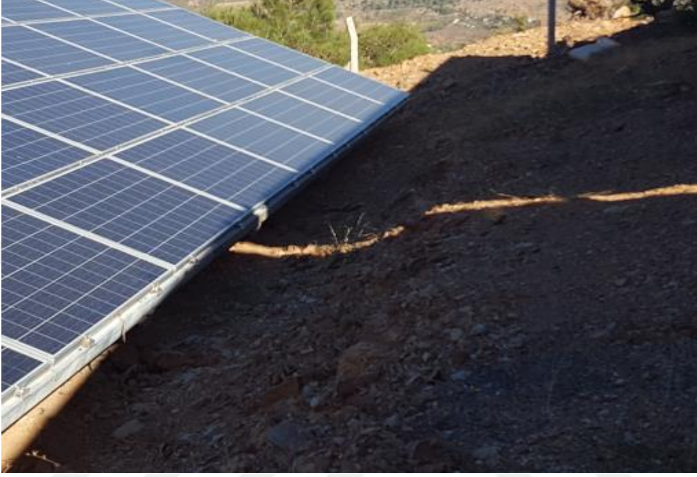
Şekil 4.52. Gölgeleme Sorunu Örneği-1
