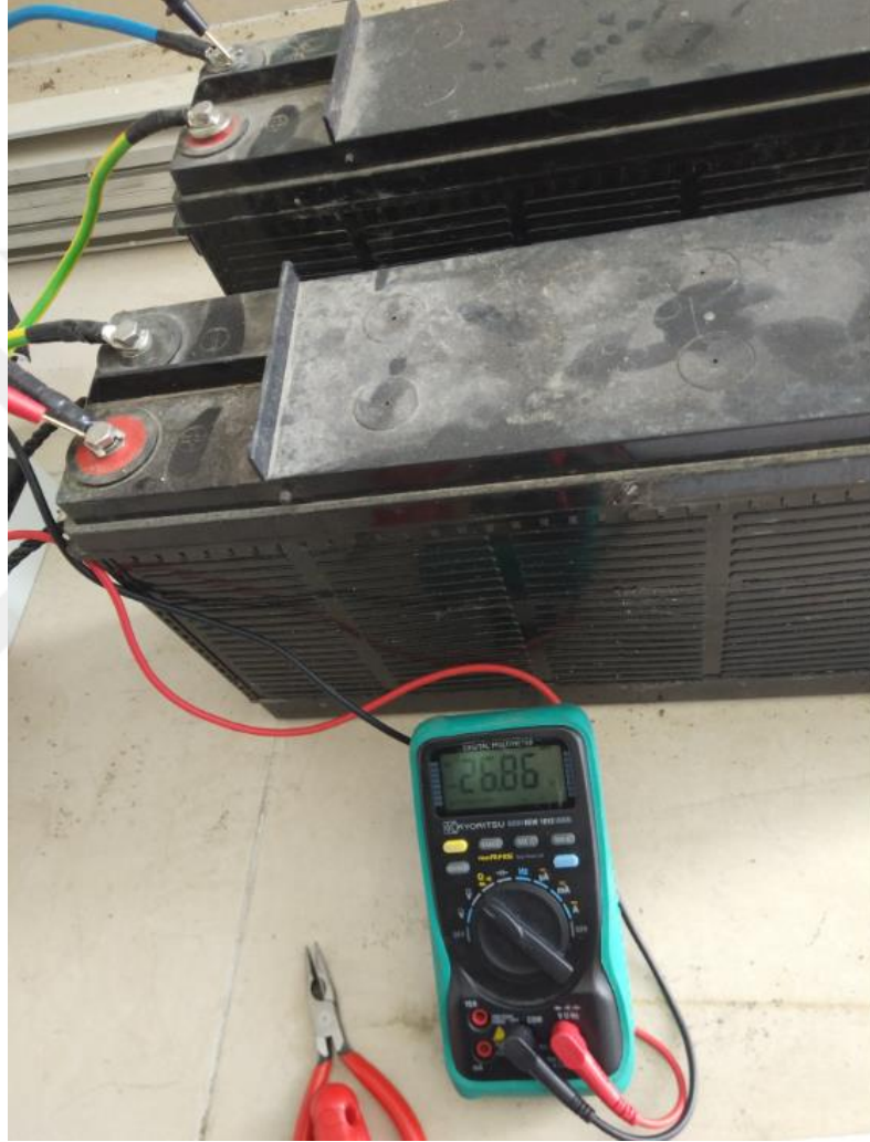
Şekil 3.5.Akülerle yapılan çalışmalar
