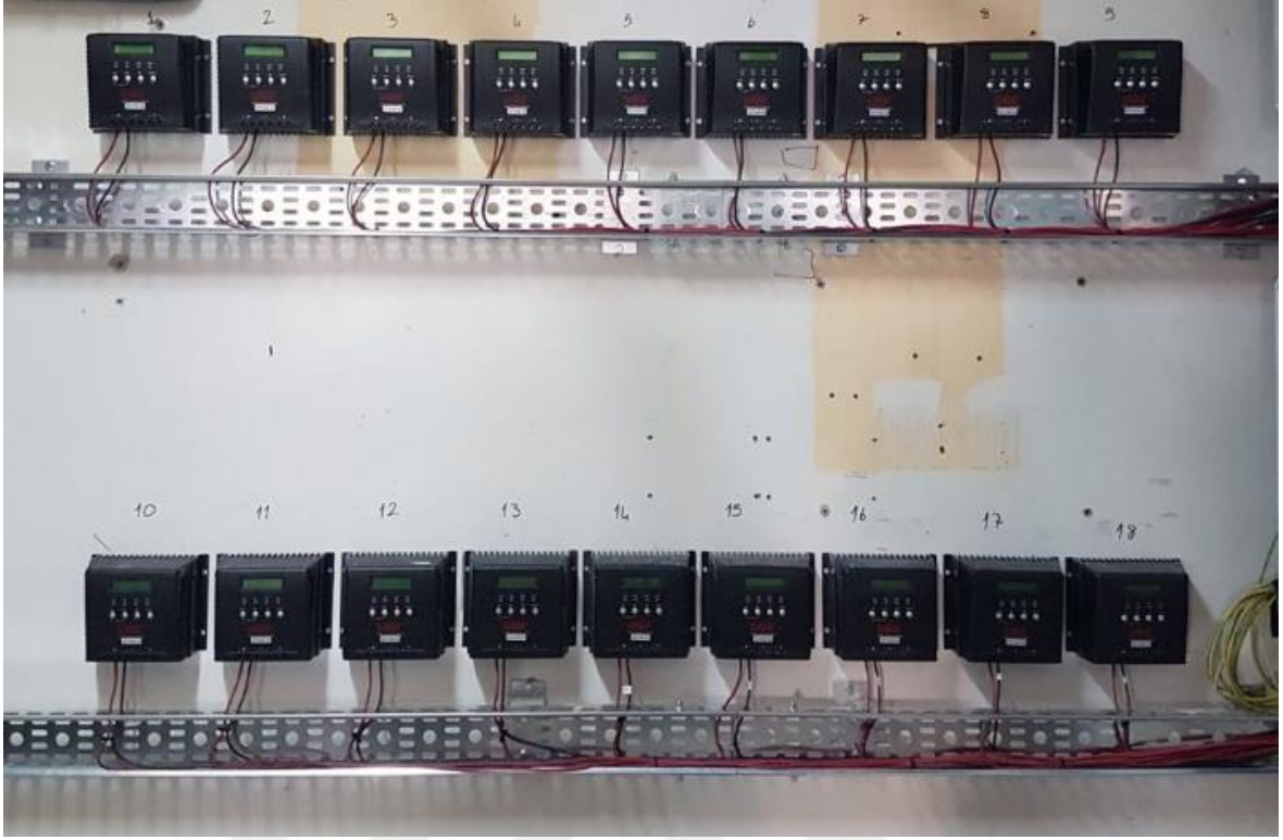
Şekil 6.11. Türk Telekom Güneş Santrali Şarj Regülatörleri-2
