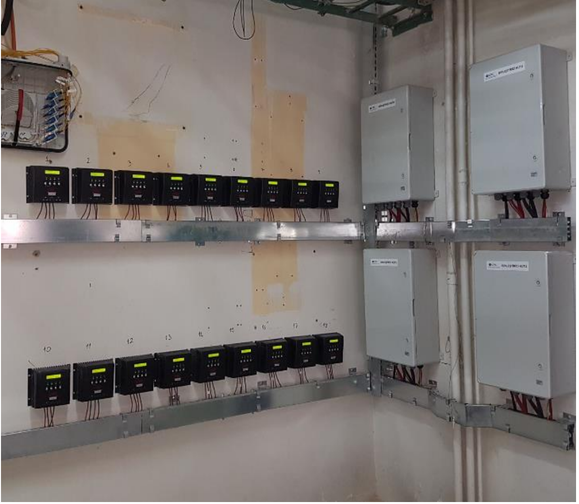
Şekil 6.10. Türk Telekom Güneş Santrali Şarj Regülatörleri-1
