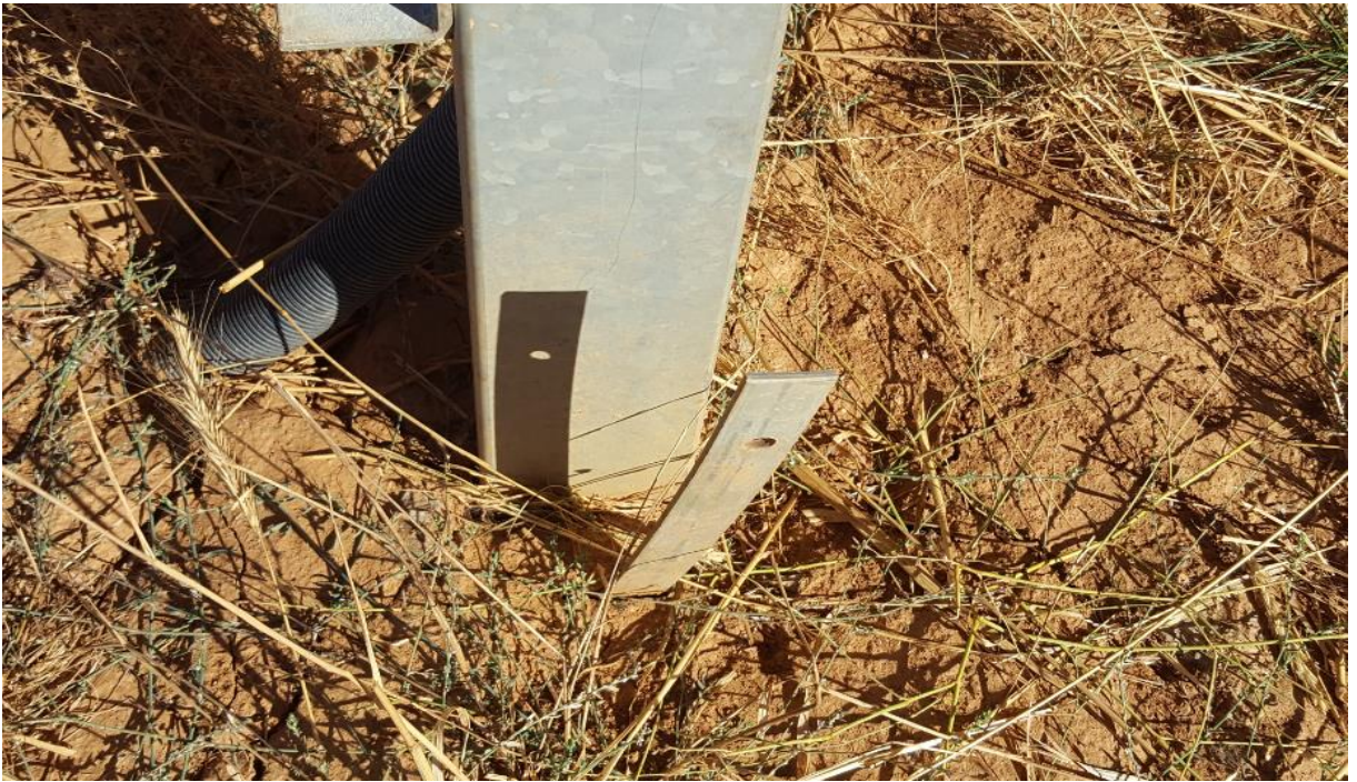
Şekil 4.51. Topraklama Hatası Örneği-2
