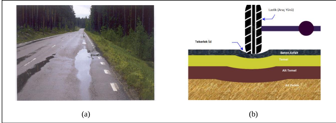
Şekil 4.3. a) Yolda oluşan tekerlek izi ve b) Tekerlek izi modellemesi [68]
