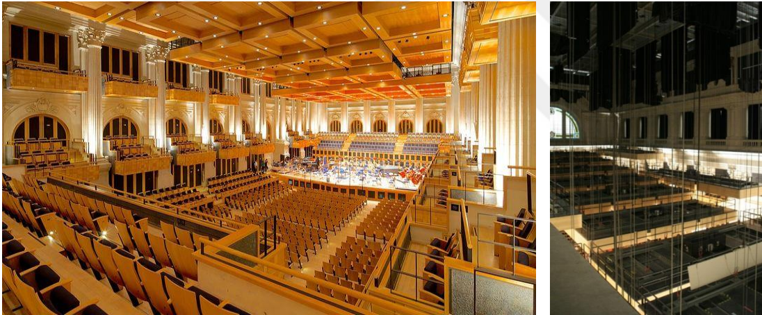
Görsel 33. Sala-Sao-Paulo konser salonu’nun hareketli tavan sistemi ( https://bit.ly/30DaCtT )
