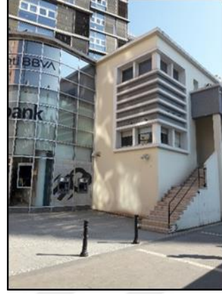
Şekil 4.36. Sait Bey Evi yol cephesi, (Yazarın arşivi)
