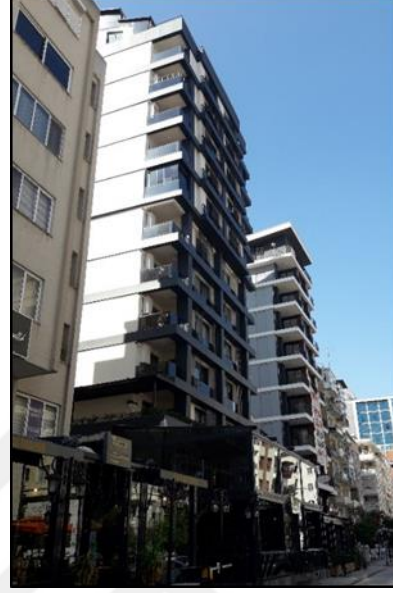
Şekil 4.32. 2020 yapı örneği, Adana (Yazarın arşivi)
