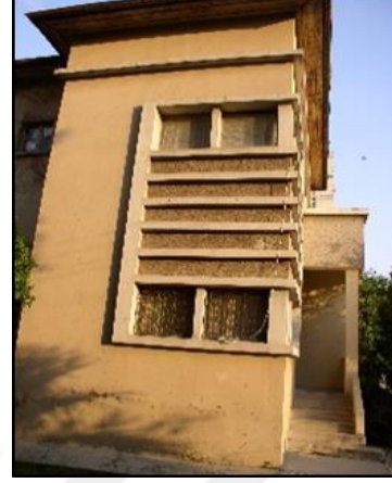
Şekil 4.34. Giriş cephesi, Sait Bey Evi (O. Erman arşivi)
