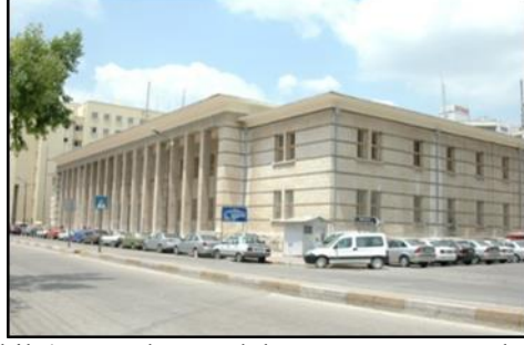
Şekil 4.22. Adana Adalet Sarayı, yan cephe (Saban arşivi)
