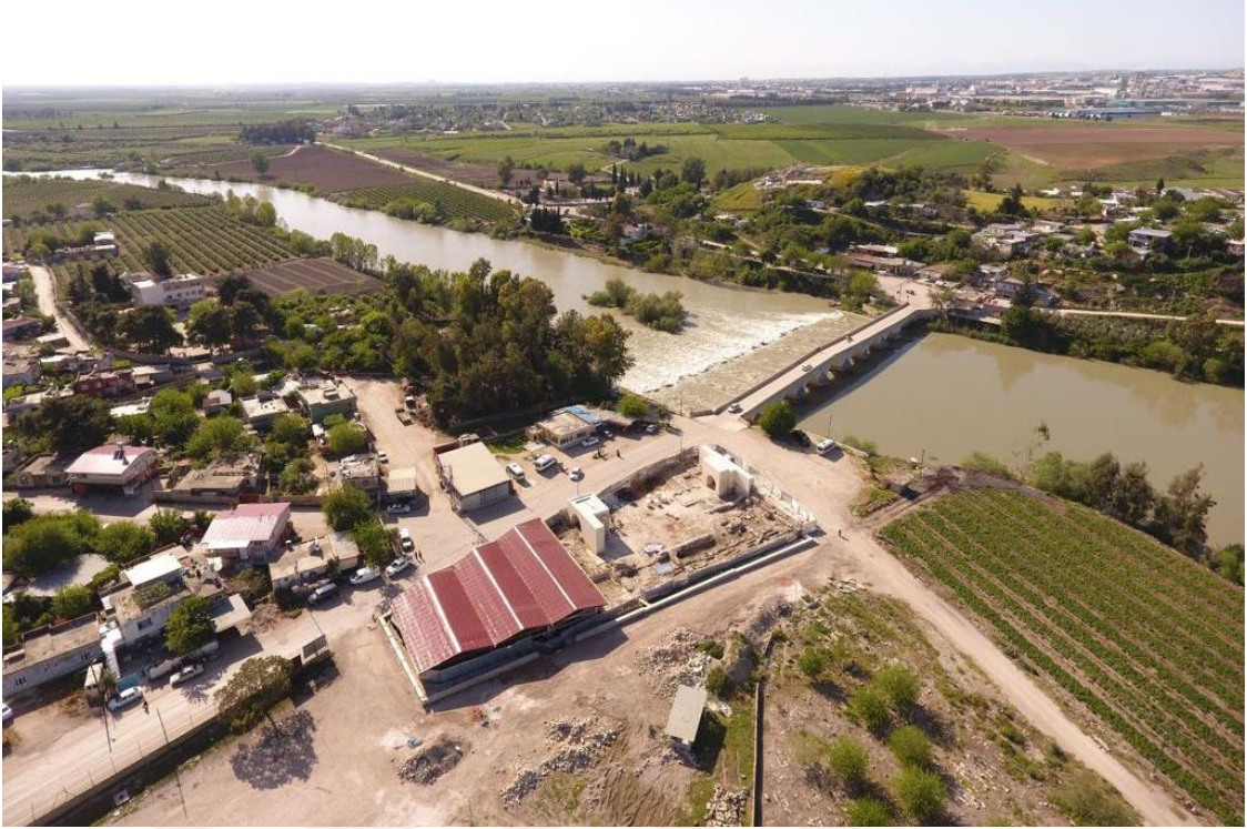
Şekil 114. Kervansaray restorasyon uygulamasının bitmiş hali
