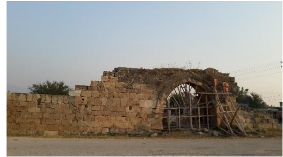
Şekil 113. Restorasyon öncesi kervansaray kuzey görünüşü
