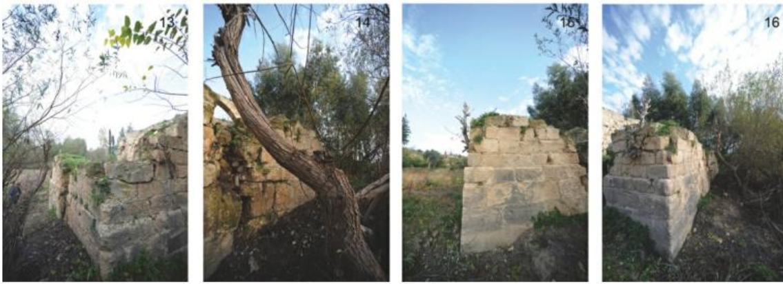
Şekil 140. Farklı açılardan Doğu cephesinden görüntüler
