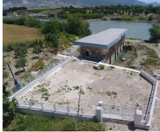
Şekil 148. Doğu Değirmeni Restorasyon Restorasyon Aşaması
