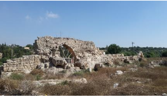
Şekil 112 . Restorasyon öncesi kervansaray görünüşü,
