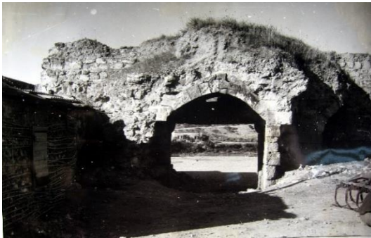
Şekil 100. Kervansaray'ın güney cephesindeki giriş kapısı
