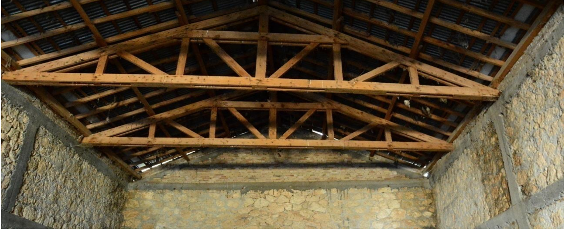
Şekil 171. Depolar iç mekan görünüşü
