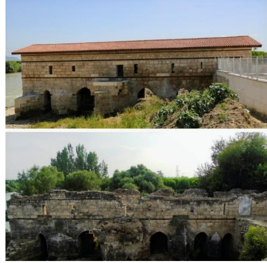
Şekil 158. Batı Değirmeni doğu cephesi restorasyon öncesi ve sonrası
