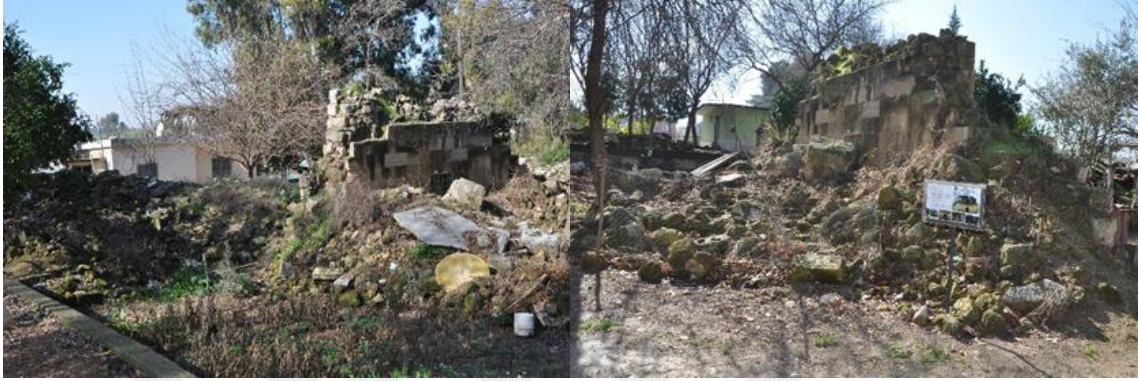
Şekil 123. Restorasyon öncesi Lokman Hekim Camii kalıntıları
