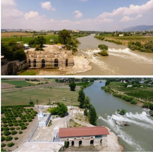
Şekil 157. Batı Değirmeni batı cephesi restorasyon öncesi ve sonrası
