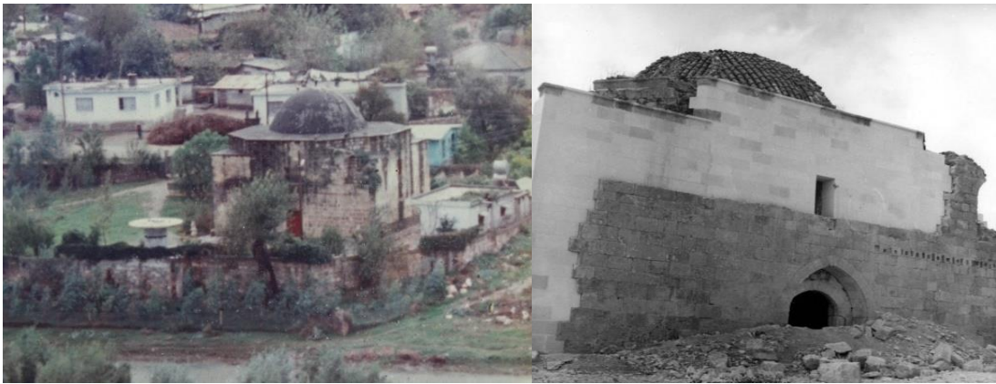
Şekil 119. Lokman Hekim Camii'nin yıkılmadan önceki hali ve tadilat gördüğü bir dönem
