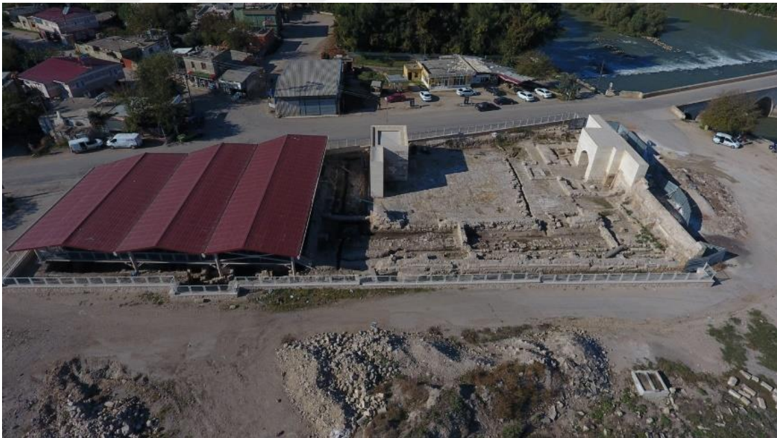
Şekil 115. Kervansaray restorasyon uygulamasının bitmiş hali
