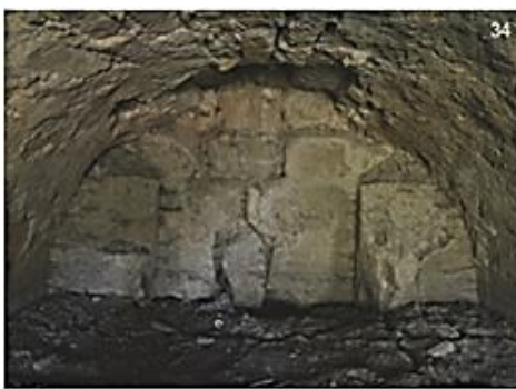
Şekil 137. Bodrum kat dolgu malzemesi
