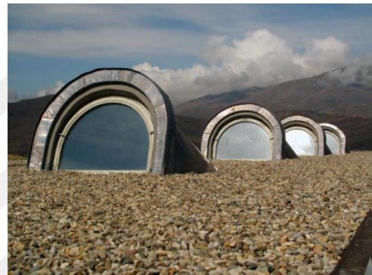
Şekil 48. Atölye yapısının çatısı
