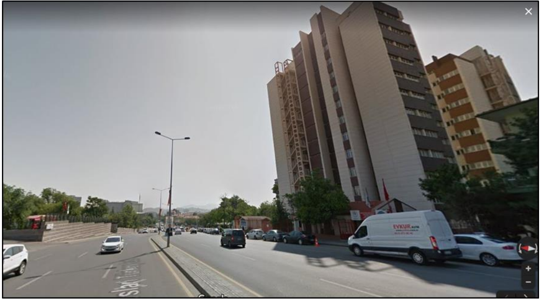
Şekil 4.27. 1 Numaralı alanda bulunan yurt binası
