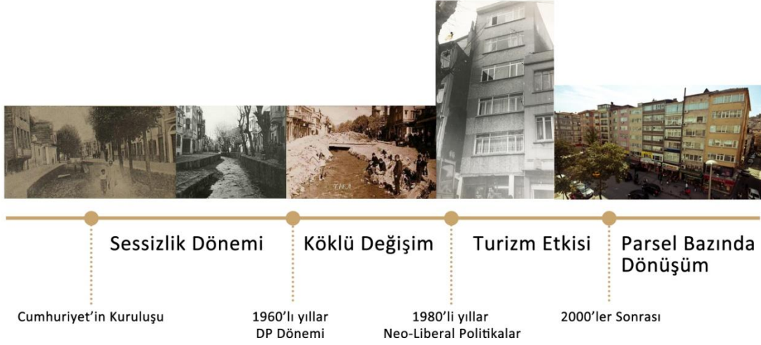
Şekil 4.30. Dereboyu Caddesi Cephe Dönüşümleri Kırılma Noktaları
