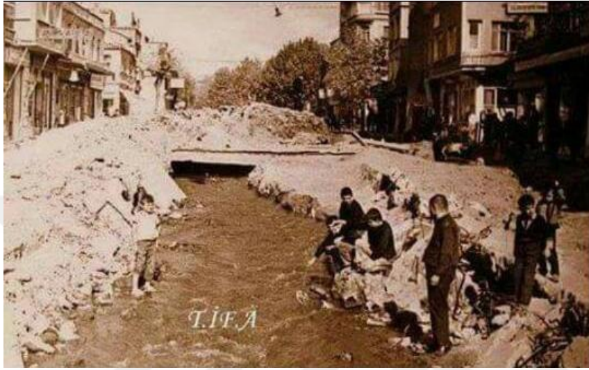
Şekil 4.23. Dereboyu Yol Genişletme Çalışması, 1950-1960 Yılları Arası
