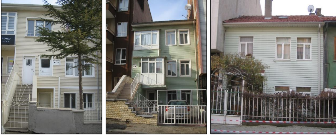
Resim 5.18. Yalı baskı cephe kaplaması yapılan konut örnekleri
