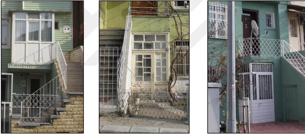
Resim 5.17. Giriş saçaklarının ve merdiven sahanlıklarının kapatılarak iç mekana katıldığı konut örnekleri
