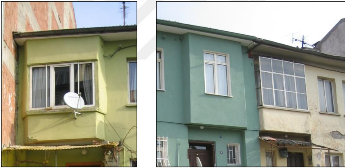
Resim 5.19. Balkonun kapatılarak iç mekana katıldığı konutlara örnekler
