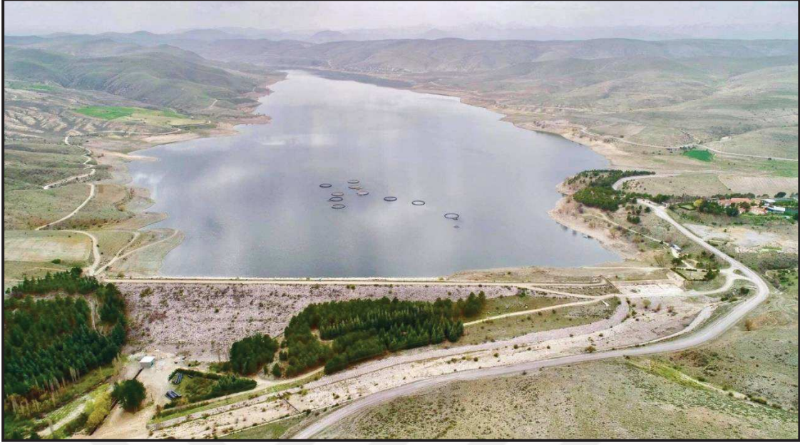
Fotoğraf 3. Sevir barajından bir görünüm (DSİ, 2019).
