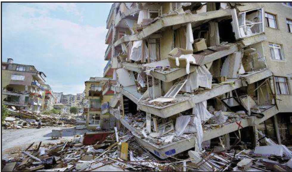
Fotoğraf 16. Çay-Sultandağı Depremleri Sonucu Meydana Gelen Yıkım (AFAD, 2023).
