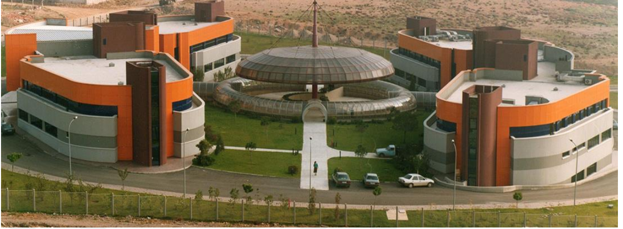
Şekil 36. Türkiye Spastik Çocuklar Vakfı Rehabilitasyon Merkezi
