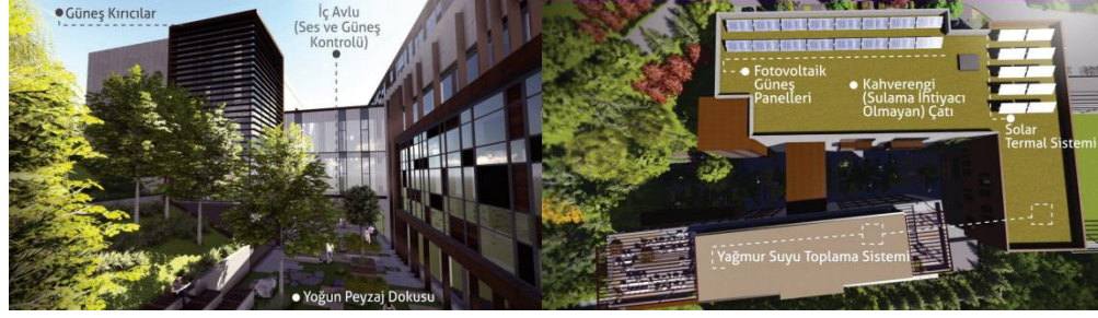
Şekil 2.6. Hacettepe Üniversitesi Sıhhiye Kampüsü sağlık bilimleri kütüphanesi cephe özellikleri ve çatı sistemleri (Yöntem, 2016)
