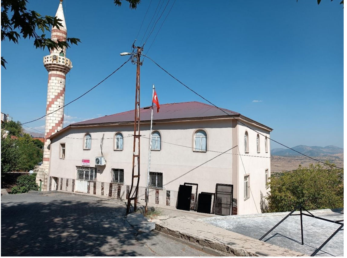
Foto 11. Alacakaya Merkez Eski Camii Görünümü
