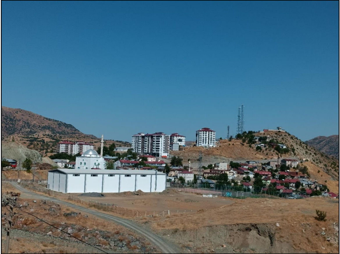
Foto 6. Alacakaya Site Mahallesinin Yamaca Kurulmuş Görüntüsü
