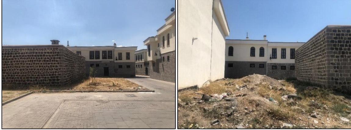
Resim 4.11. 9 ve 3 numaralı parselde yer alan tescilli yapıların boşaltılmış yan parselleri
