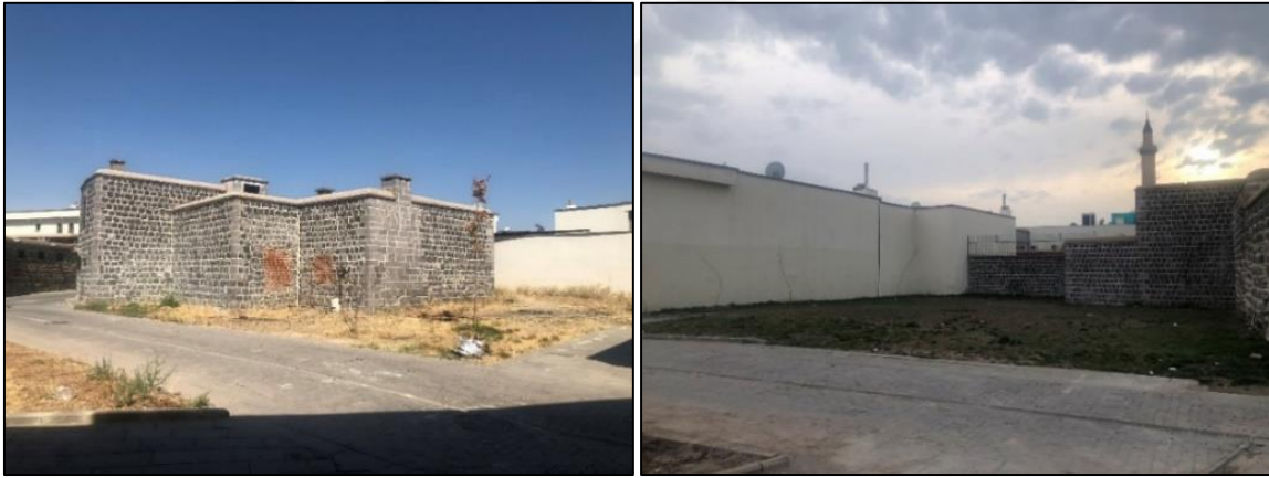
Resim 4.4. 286 numaralı yapı adası Kentsel Yenileme Projesi sonucunda boşaltılan parseller
