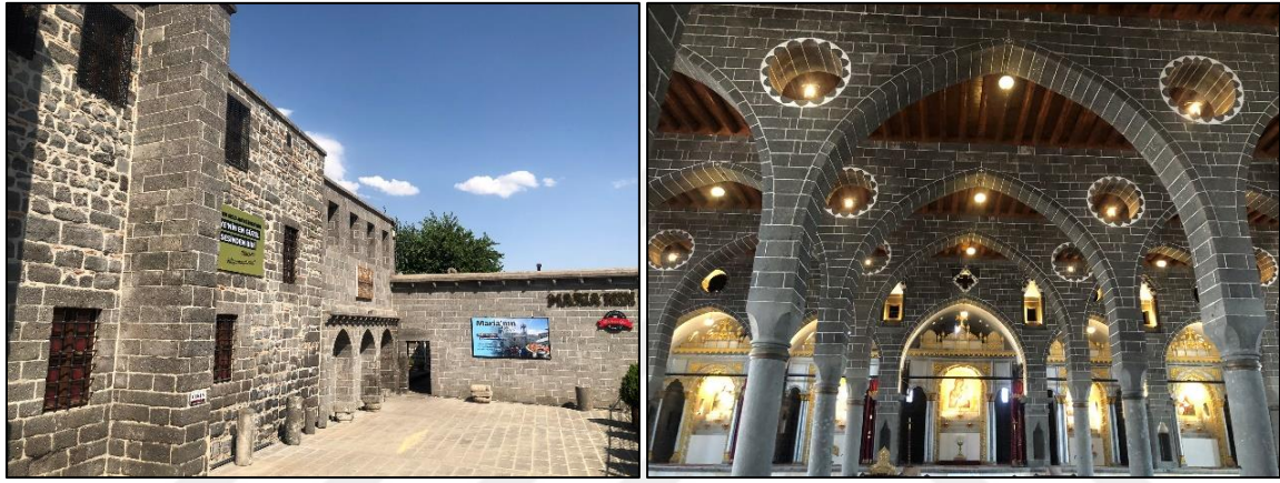
Resim 2.17. Mor Petyum ve Surp Giragos Kiliseleri restorasyon sonrasına ait görseller (yazar arşivinden)
