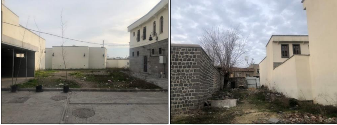
Resim 4.3. 286 numaralı yapı adası Kentsel Yenileme Projesi sonucunda boşaltılan parseller
