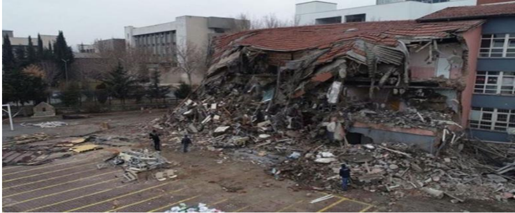
Şekil 1.2: Bingöl Depremi-Çeltik suyu Yatılı İlköğretim Bölge Ortaokulu
