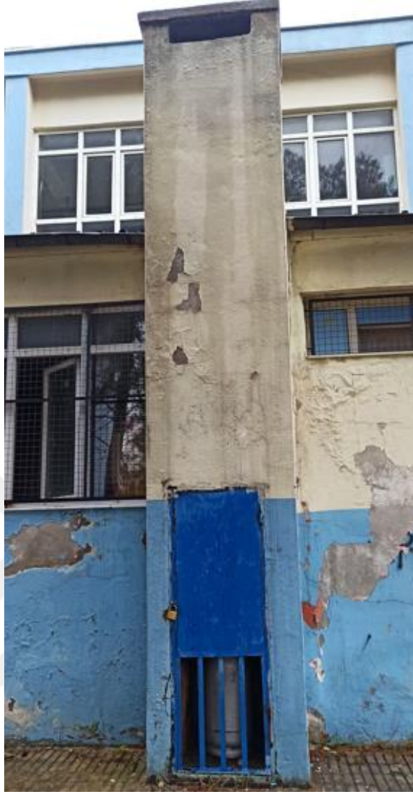
Şekil 4.11. Korunaklı Alanda Bulunan Basıncılı Tüp
