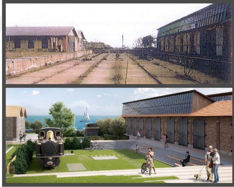
Görsel 181: Transportör Havuzu ve Vagonaj'ın eski görünümü ile Cer Loft tanıtımındaki kesiti.
