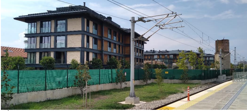
Görsel 90: İstasyondan, atölyelerin “yol” bölümü yapılarının yıkılmasıyla inşa edilen CER İstanbul apartmanlarına bakış, 2024.
