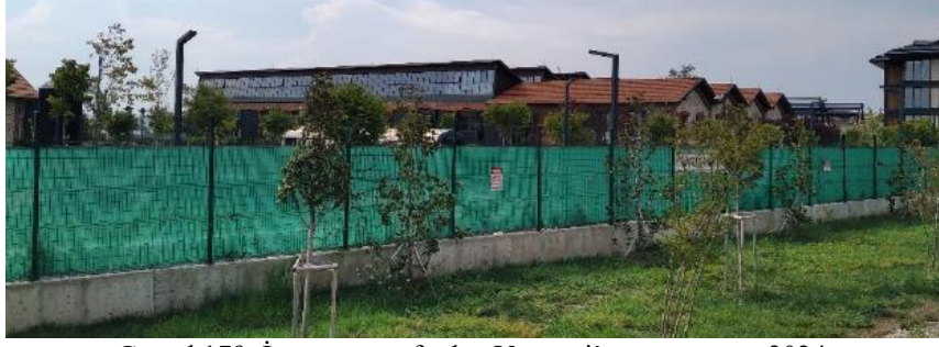
Görsel 179: İstasyon tarafından Vagonaj'ın görünümü, 2024.
