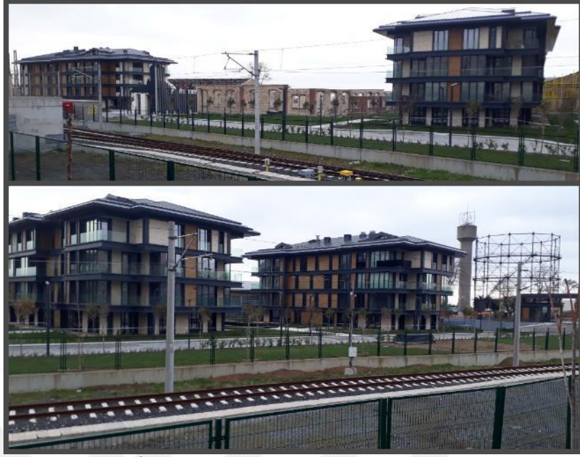
Görsel 162: Cer İstanbul projesi kapsamında inşa edilen apartmanlar, 2022.
