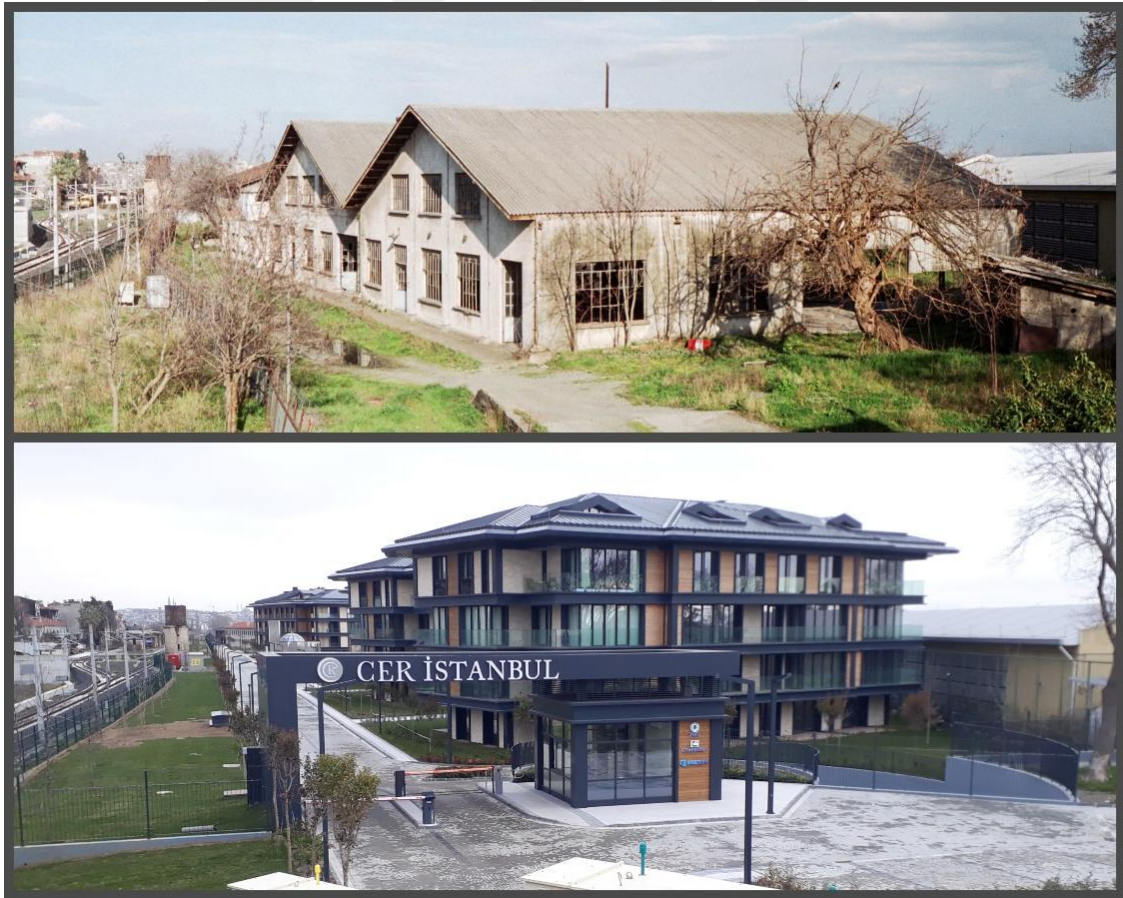
Görsel 132: Yedikule Cer Atölyeleri kompleksindeki yol atölyesi yapıları ile bu yapıların yıkılması sonrasında yapılan CER İstanbul apartmanları, 2016 ve 2022.
