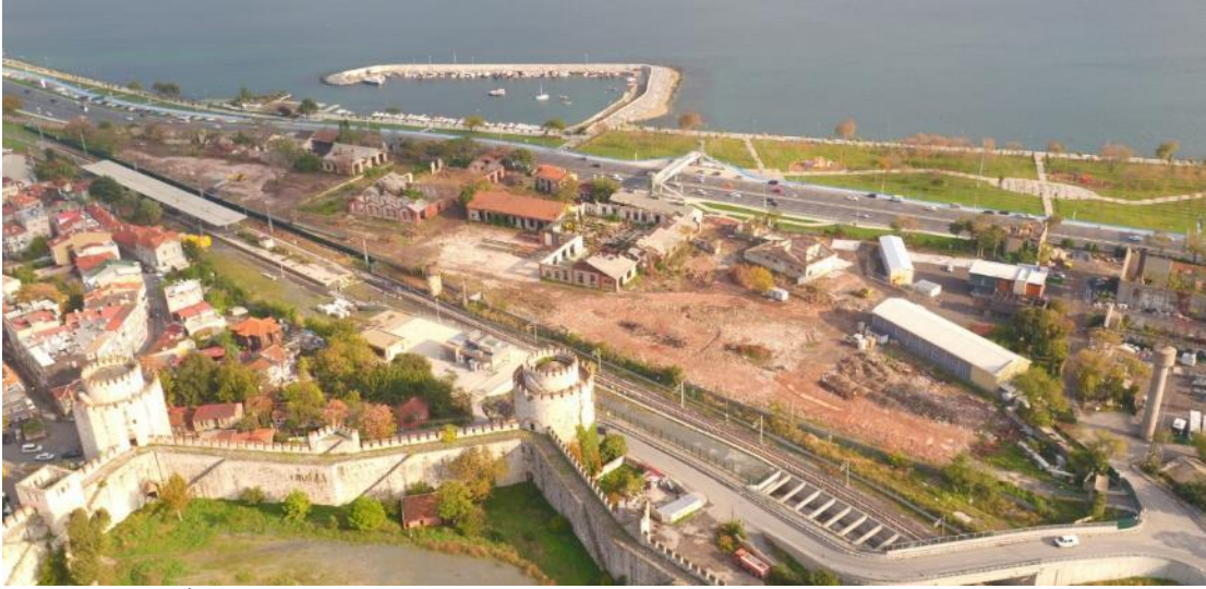
Görsel 156: Cer İstanbul projesi kapsamında birçok atölye yapısının yıkılarak apartmanlara yer açıldığını gösteren hava fotoğrafı, Kasım 2017.
