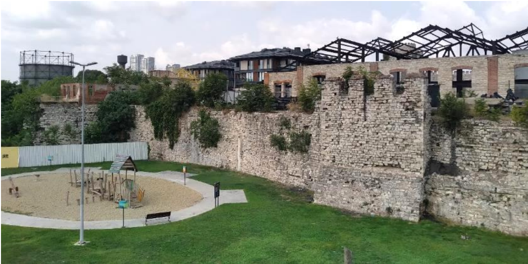
Görsel 164: Cer İstanbul apartmanları, Marmara surlarının 97. kulesi ve 97. duvarı, Montaj ve Fren Postası gibi birimleri barındıran atölye yapıları, 2024.
