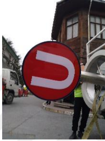
Görsel 83: Ulařtırma ve Altyapı Bakanlığı’nı ifade eden tabela Yedikule İstasyonu giriřine yerleřtirilirken, 2023.
