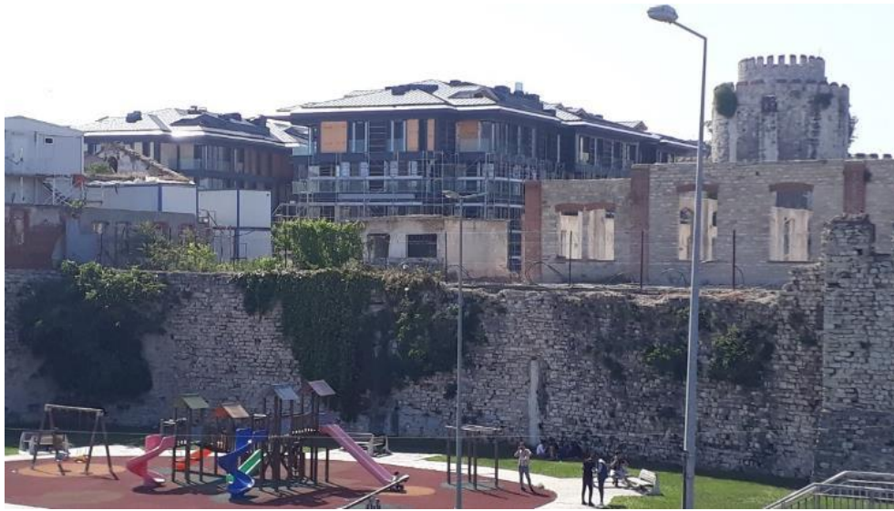
Görsel 160: Sahilden Marmara surları, Cer İstanbul apartmanları ve Yedikule Hisarı Top Kulesi, 2021.
