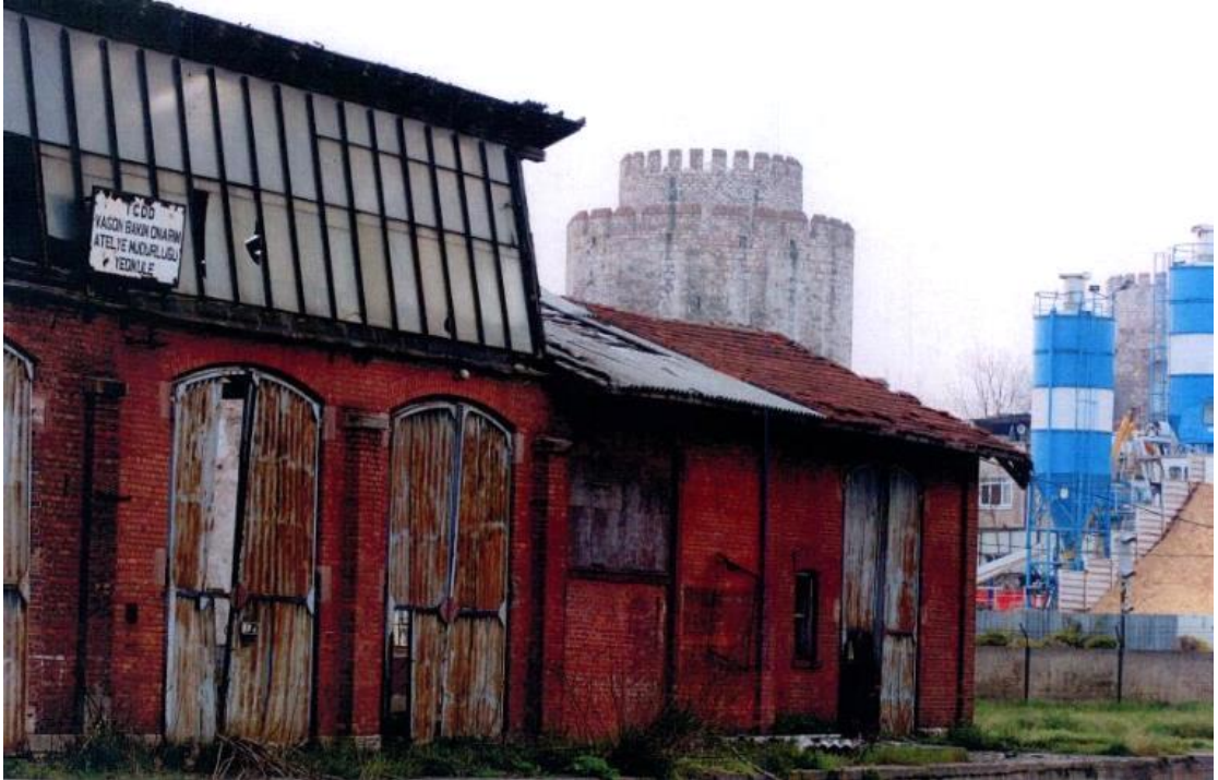
Görsel 175: Solda Yolcu Vagonajı, sağda marangozhane, arka planda Yedikule Hisarı Top Kulesi. Kaynak: Pancar, Öğrenci ve Balaban, Yedikule Tren Bakım Üniteleri Koruma Raporu.
