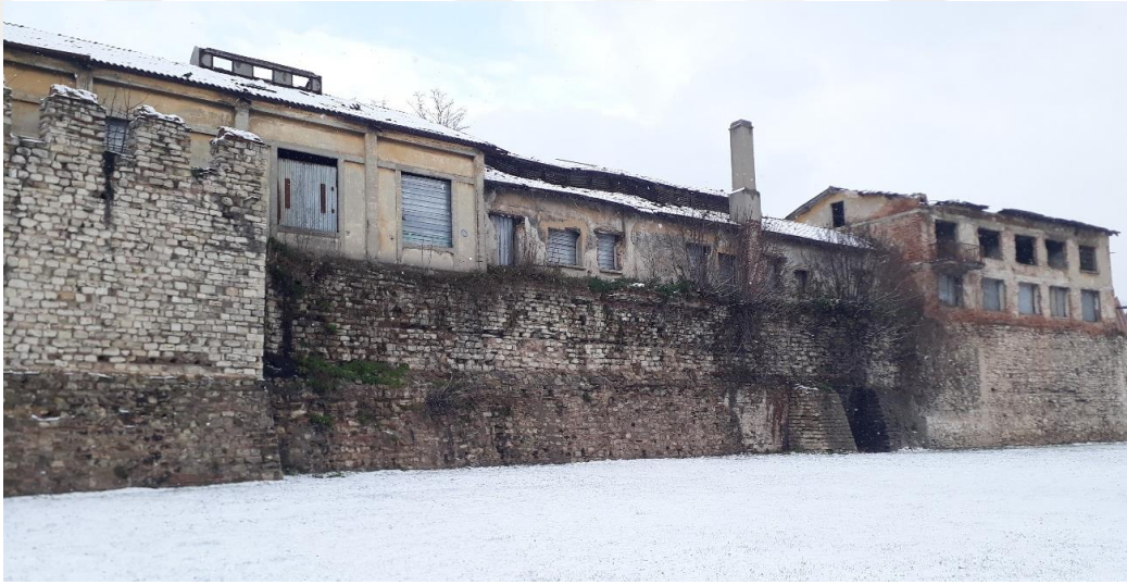
Görsel 172: Proje kapsamında yıkılan Demirhane, Kaynak Evi, Elektrikhane yapıları, 2021.
