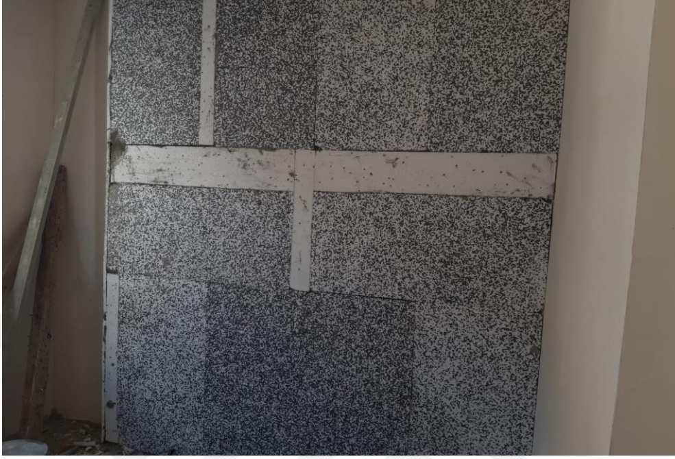
Şekil 1.15. İçten EPS yalıtımlı duvar örneği
