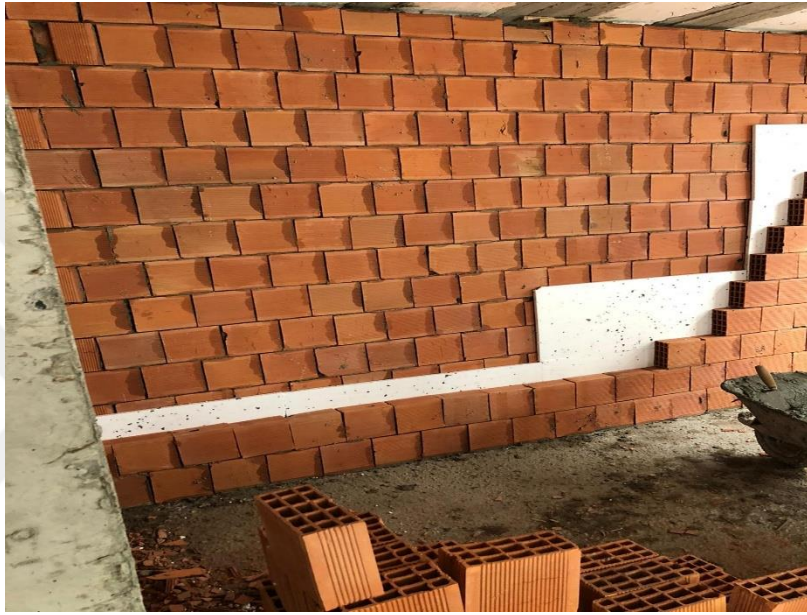
Şekil 1.17. EPS yalıtımlı (Sandviç) tuğla duvar örneği
