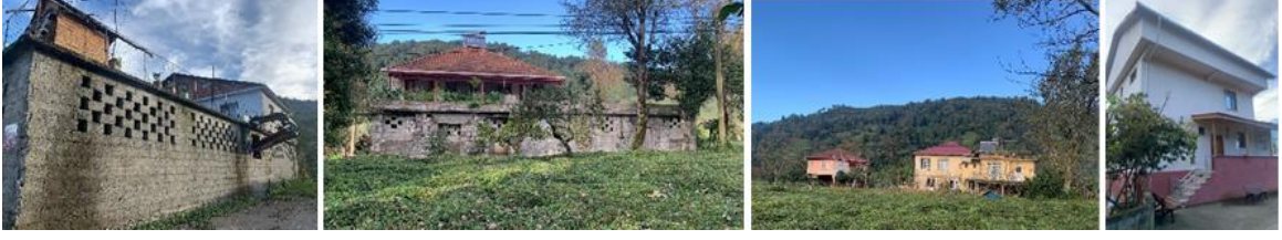
Resim 3.21. Rize İli Çayeli İlçesi Şirinköy Geleneksel Dokuya Aykırı (Kaynak: Yazar Arşivi, 2022-2024)
