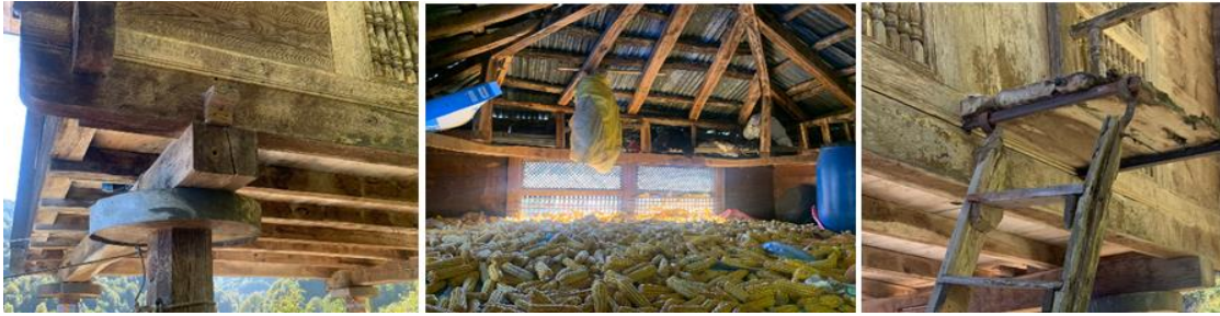
Resim 3.9. Serender Havalandırma ve Aydınlatma Düzeni (Kaynak: Yazar Arşivi, 2022-2024)
