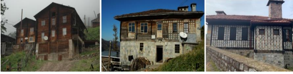
Resim 3.5. Doğu Karadeniz Bölgesi Yapım Tekniği Ahşap Yığma Ev Örnekleri (Kaynak: Özen, 2019; 2021), B. C. Ahşap Yığma ve İskelet Sistemin Birlikte Kullanıldığı Örnek, Göz Dolma Konut Örneği/Fındıklı (Kaynak: Yazar Arşivi, 2022-2024)
