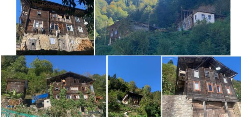
Resim 3.14. Rize İli Çayeli İlçesi Kaptanpaşa Köyü (Köyüçü Mevki) Geleneksel Konut Örnekleri (Kaynak: Yazar Arşivi, 2022-2024)
