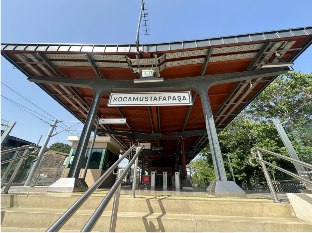
Şekil 4.25 Kocamustafapaşa İstasyonu çatı örtüsü
