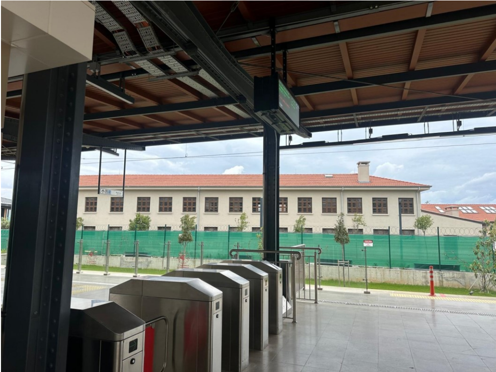
Şekil 4.30 Yedikule İstasyonu eski gara ait bina
