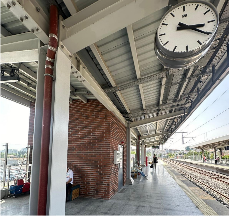
Şekil 4.33 Kazlıçeşme İstasyonu peronu
