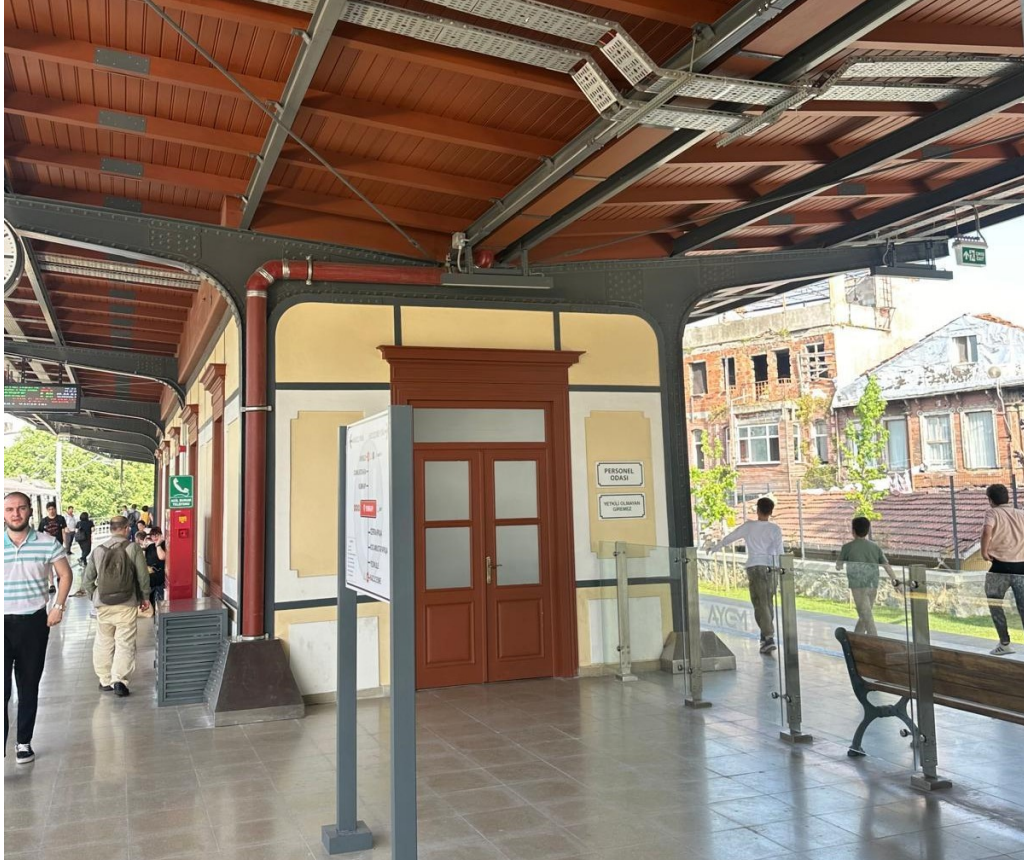
Şekil 4.18 Yenikapı İstasyonu çok amaçlı salonu (Henüz kullanıma kapalı)
