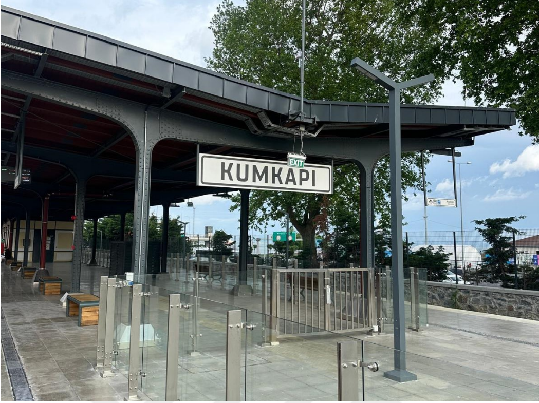
Şekil 4.13 Kumkapı İstasyonu üst örtüsü
