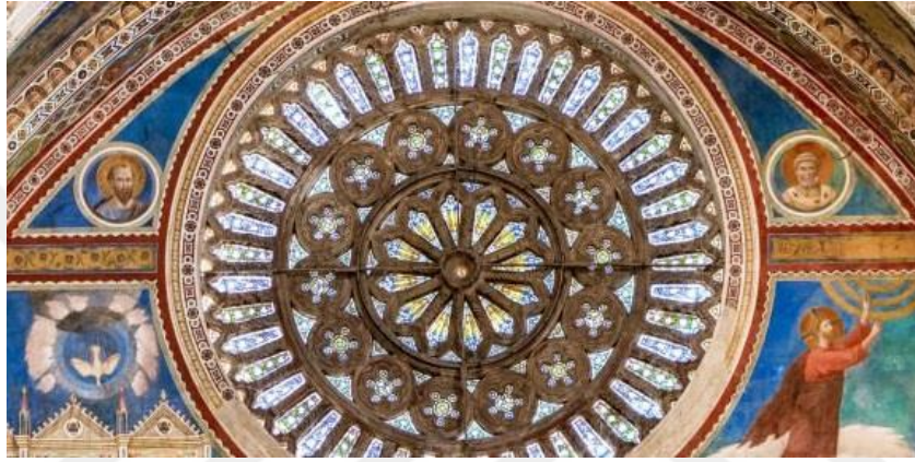
Şekil 3.8 Upper church of san francesco iç görünüş, assisi 1228
