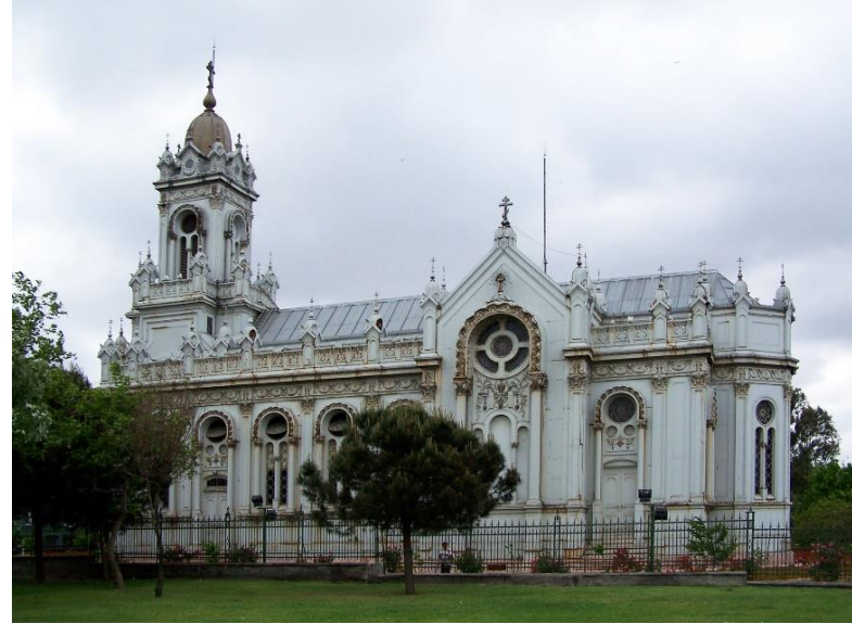
Güney Cephe genel görünüşü
