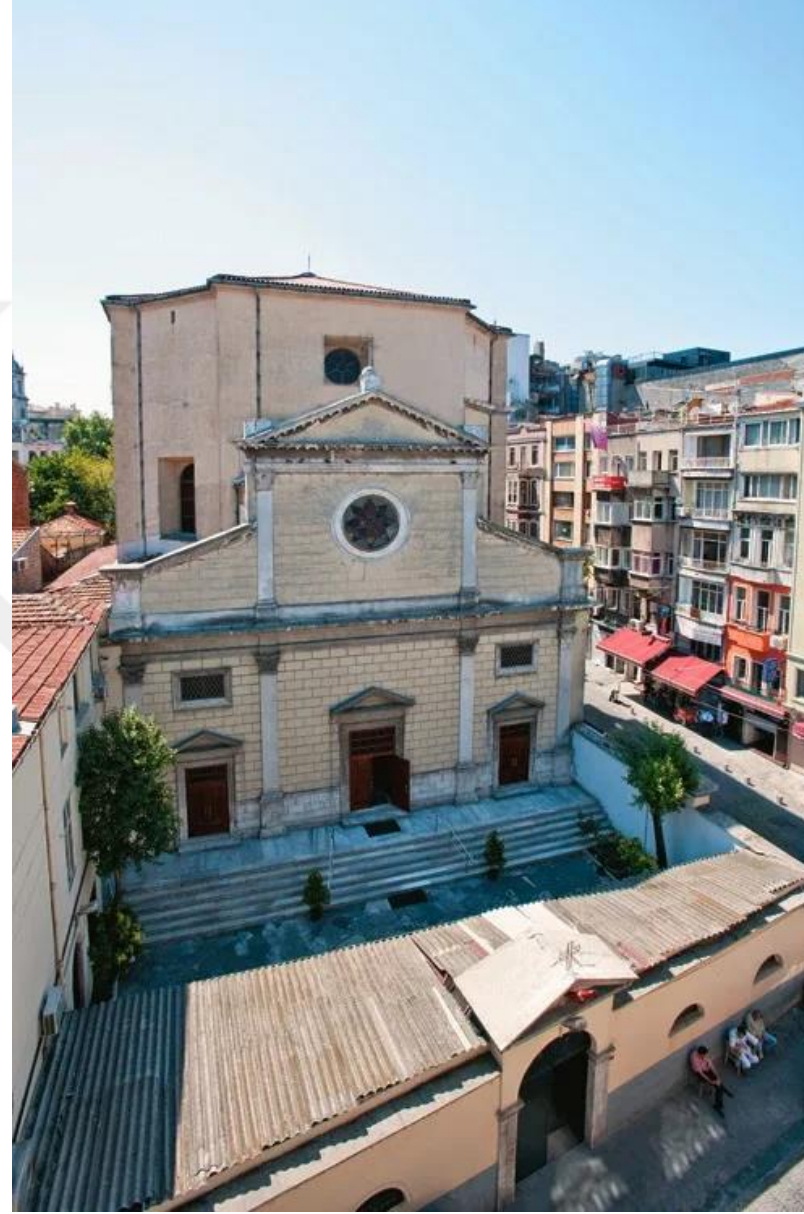
Batı Cephesi Görünüşü
