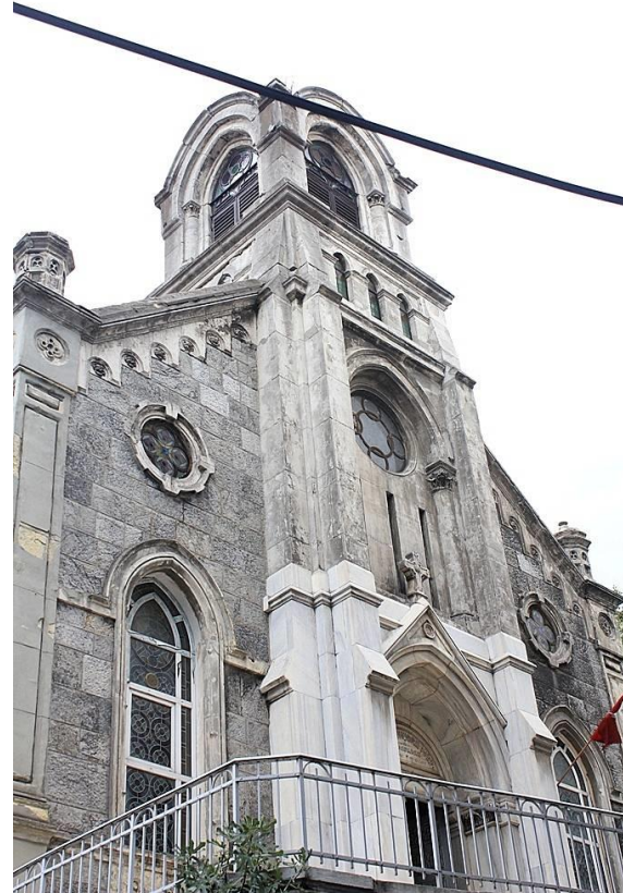
Batı Gişiş Cephesi
