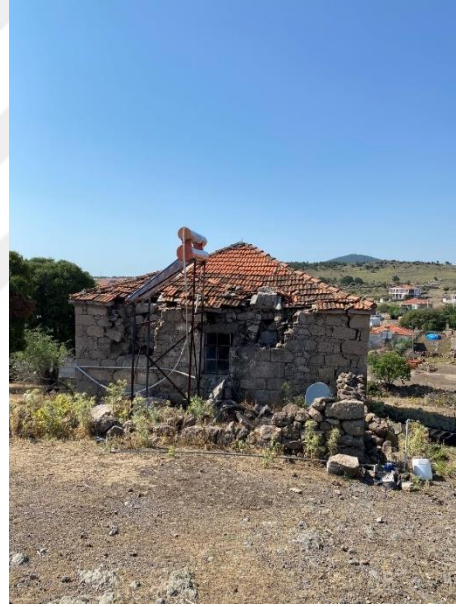
Görsel 3-4. Yukarıköy’de depremde hasar görmüş taş evin iç kısmı. Depremde hasar görmüş taş ev.
