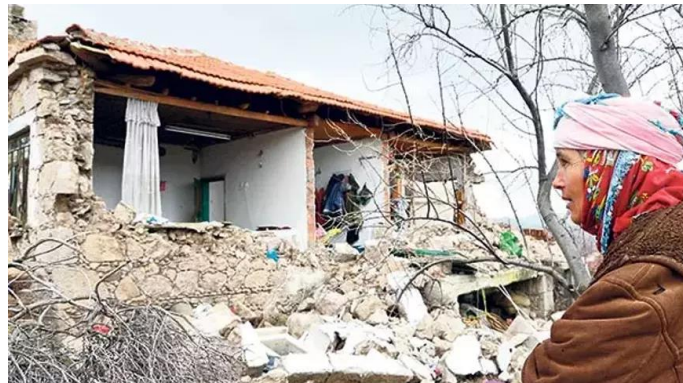
Görsel 2. Ayvacık Depremi’nden sonra Yukarıköy’de evi yıkılan bir vatandaş.
