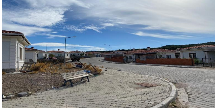
Görsel 6. Çamkalabak köyü yeni deprem konutları
