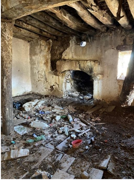
Görsel 3-4. Yukarıköy’de depremde hasar görmüş taş evin iç kısmı. Depremde hasar görmüş taş ev.
