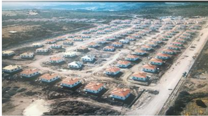
Görsel 5. Yukarıköy yeni deprem konutları yapım aşamasında
